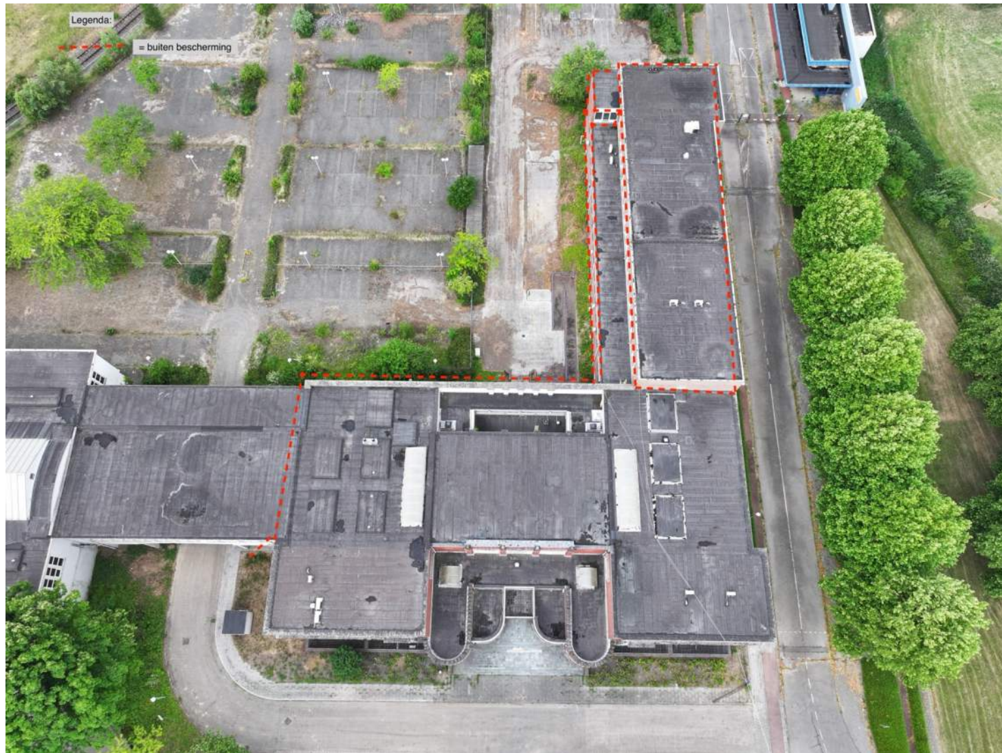
Afb. 08: luchtfoto van de daken en directe omgeving van de voormalige Loonhal met demarcatie niet beschermde elementen
