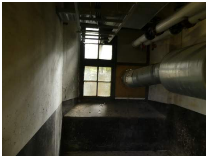
Afb. 5.4.21, ramen en ruitjes vervangen door leidingwerk, , gevel 09-16
