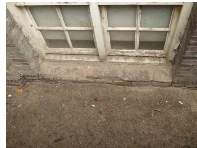
Afb. 5.3.24, afgebroken raamdorpelstenen koekoekkozijnen, gevel 16
