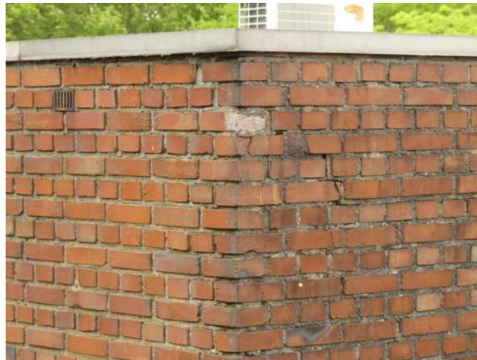
Afb. 5.9.03, verroest ventilatierooster onder dakrand, gevel 11
