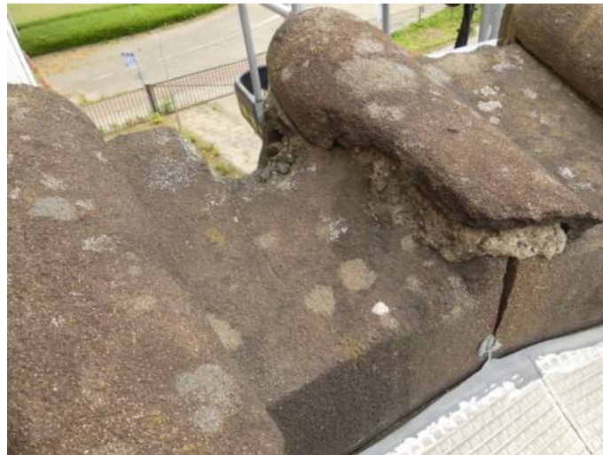
Afb. 5.3.06, afgebroken delen
