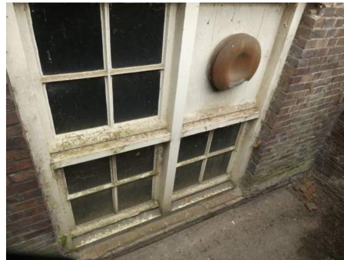
Afb. 5.4.13, draairaam vervangen door plaat, gevel 09
