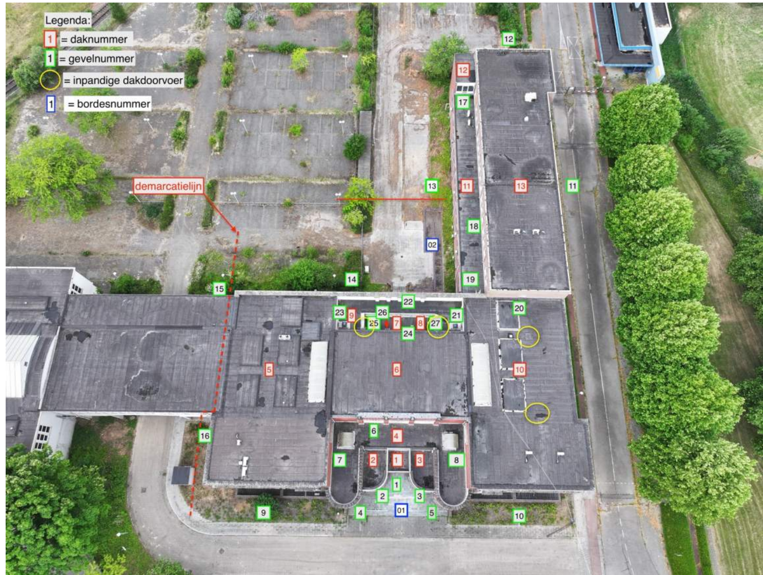
Afb. 15: luchtfoto van de daken van de voormalige Loonhal met dak-, gevel- en bordesnummer
