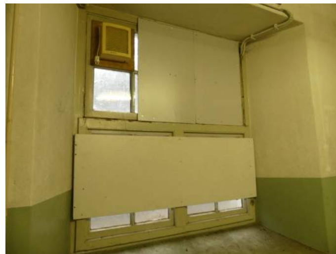
Afb. 5.4.22, ruitje vervangen door rooster, plaatwerk tegen kozijn, gevel 09
