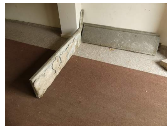
Afb. 5.8.08, afgenomen traptreden en stootborden in vestibule, bordes 01
