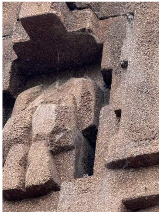
Afb. 5.3.08, verwerking en afgebroken delen
