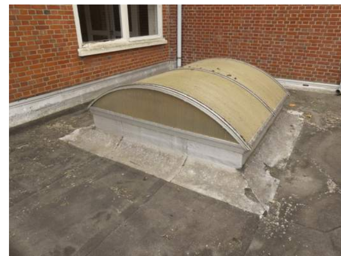
Afb. 5.4.29, daklicht met uitgeharde kunststof vol gaatjes, dak 04
