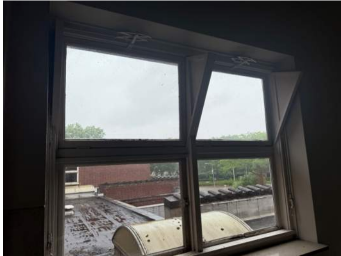
Afb. 5.12.25, raamkozijn (gevel 07), grotendeels origineel
