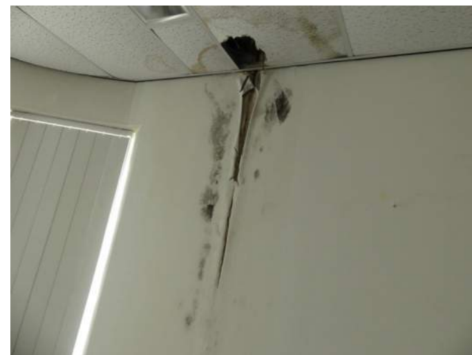
Afb. 5.12.23, gevolgschade van waterlekkage in ruimtes naast hoofdentree
