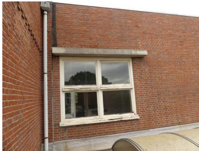
Afb. 5.4.08, origineel houten kozijn, gevel 08
