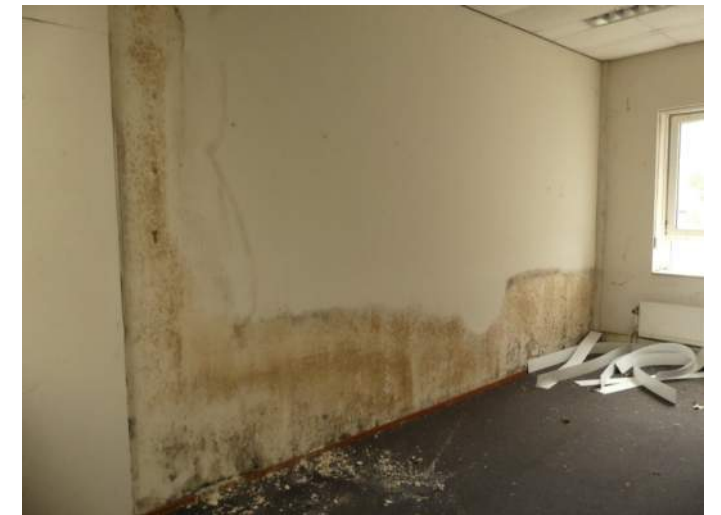
Afb. 5.12.19, gevolgschade (schimmel) van langdurige waterlekkage
