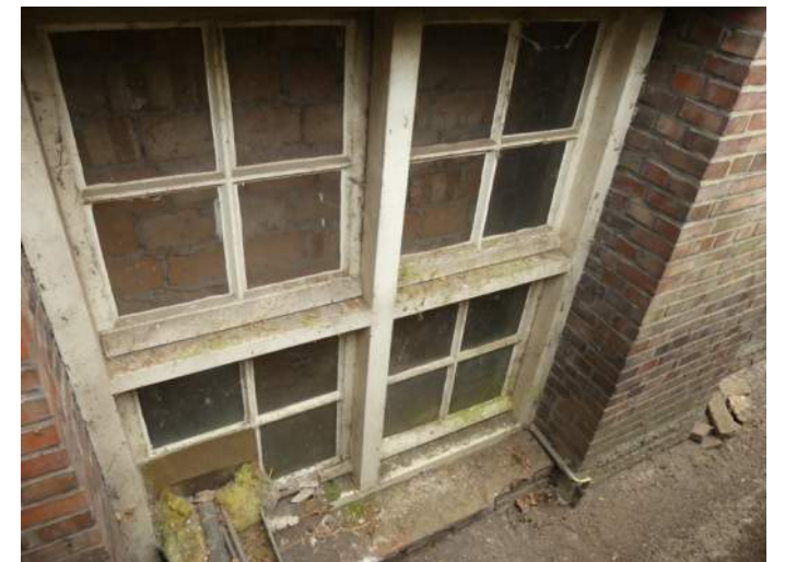
Afb. 5.10.06, koekoekkozijnen gevel 10
