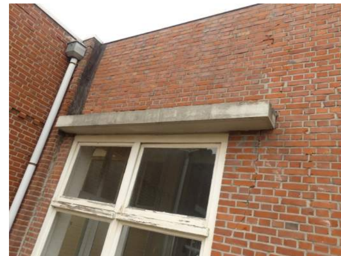
Afb. 5.2.01, betonlatei gevel 08
