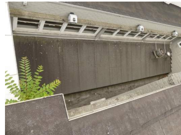
Afb. 5.6.22, overzicht dak 07 en 08
