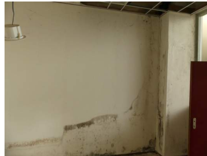
Afb. 5.12.19, gevolgschade (schimmel) van langdurige waterlekkage
