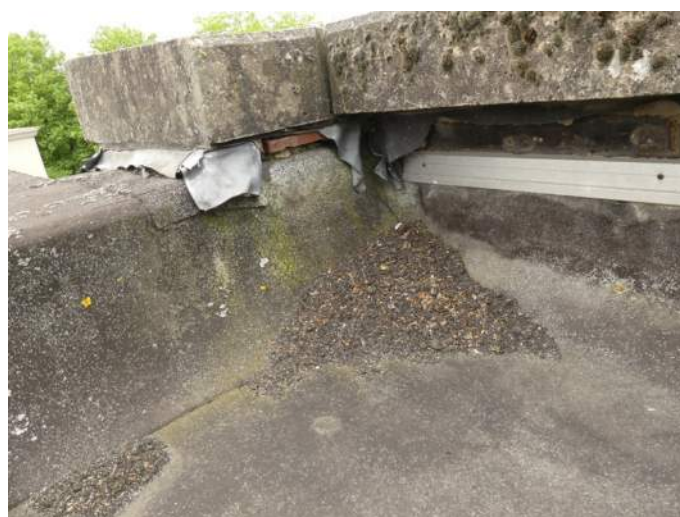
Afb. 5.6.18, verdwenen kitvoeg afdekken gevel 14/15, dak 05
