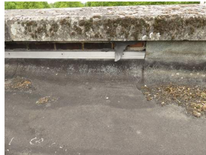
Afb. 5.6.19, verdwenen lood deels vervangen door bitumen, dak 05
