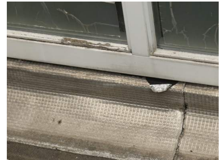
Afb. 5.4.26, aangetaste glaslat, gevel 24
