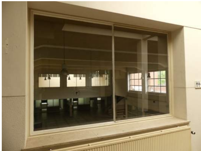
Afb. 5.12.39, binnenwand naast voormalige Loonhal
