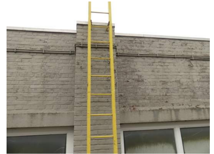
Afb. 5.3.10, vervuild en afgedrukt sauswerk
