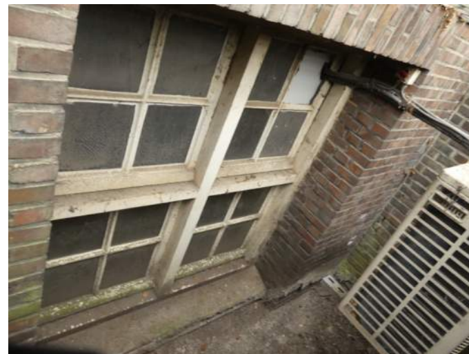
Afb. 5.4.15, ruitje vervangen door plaat met leiding, gevel 09
