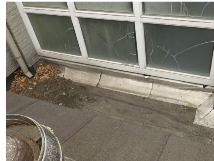
Afb. 5.4.25, onderzijde kozijn, gevel 24
