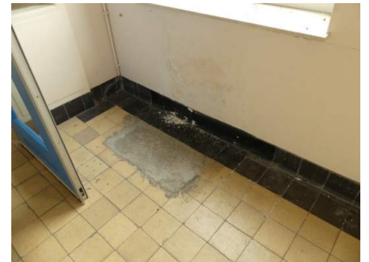
Afb. 5.12.60, met smeervloer gerepareerde tegelsparing
