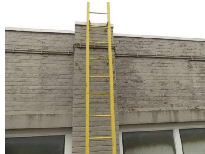
Afb. 5.5.03, dakladder voldoet niet aan veiligheids- dan wel arbo-voorschriften, voorschriften, gevel 24
