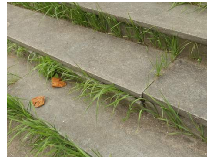
Afb. 5.8.04, verzakte stootborden en verschoven traptreden, bordes 01
