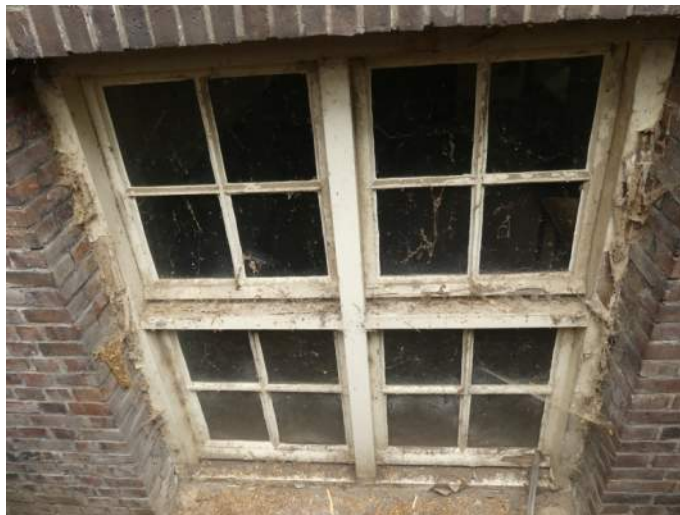
Afb. 5.10.07, koekoekkozijnen gevel 16
