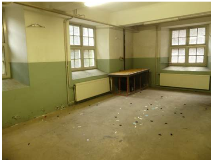
Afb. 5.4.19, koekoek kozijnen, gevel 09-16
