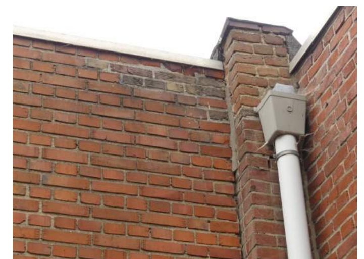
Afb. 5.11.06, PVC vergaarbak met PVC hwa, gevel 07,
