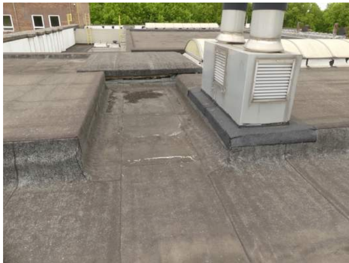
Afb. 5.6.13, diverse reparaties, dak 05
