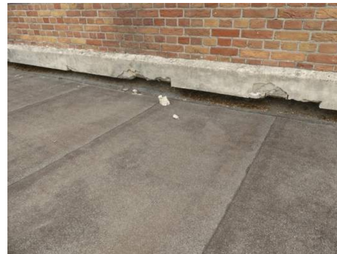
Afb. 5.2.11, afgebroken randen
