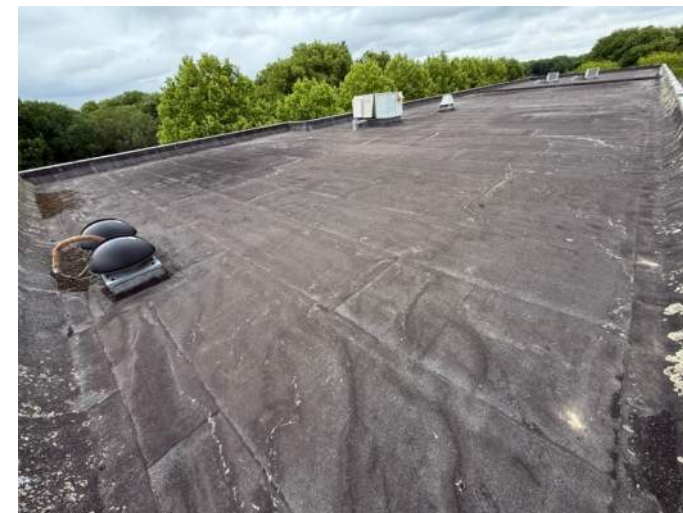
Afb. 5.6.33, overzicht dak 13 met plooivorming
