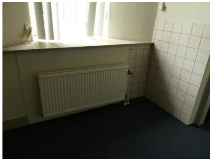
Afb. 5.12.16, vochtlekages, en gevolgschade, langs vensters op meerdere locaties
