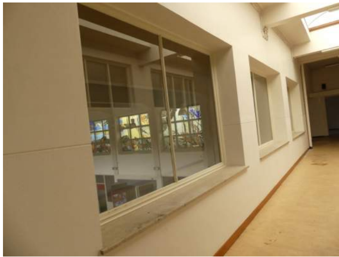
Afb. 5.12.37, binnenwand naast voormalige Loonhal
