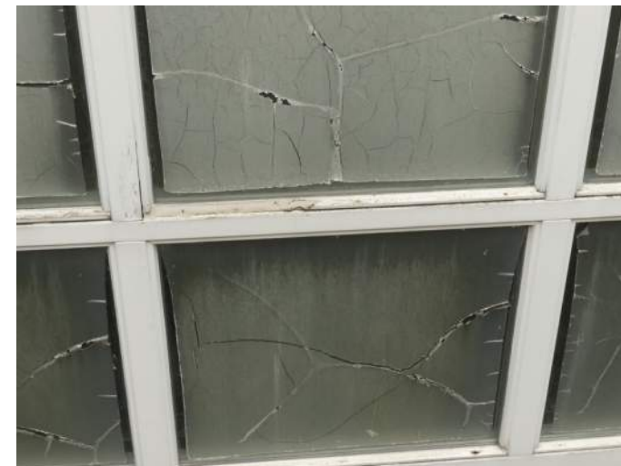
Afb. 5.4.27, 'herstelde' glaslat, gevel 24
