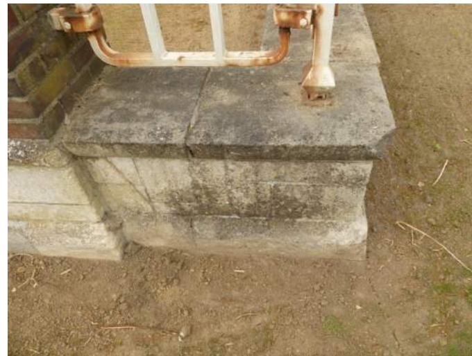
Afb. 5.1.02, afgebroken hoekje
