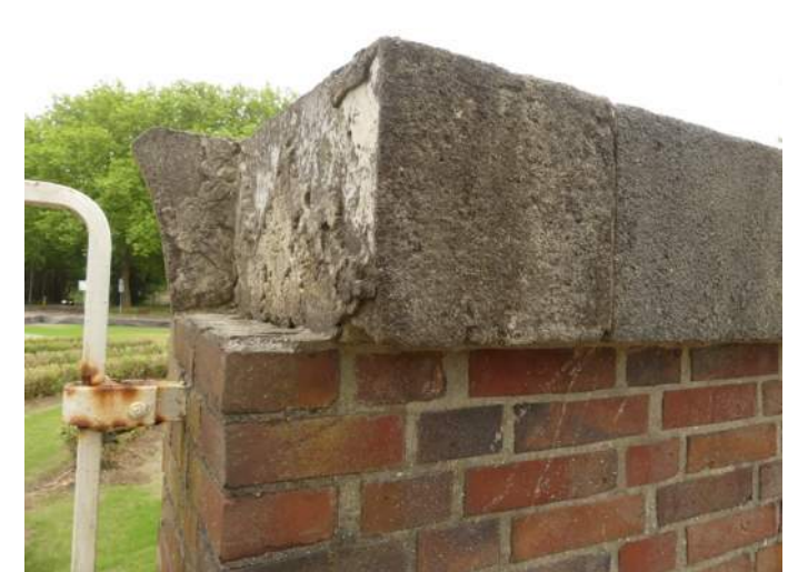
Afb. 5.1.04, afgefallen profielblok
