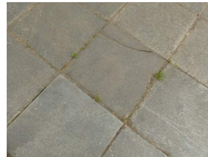
Afb. 5.8.06, gebroken tegel, bordes 01
