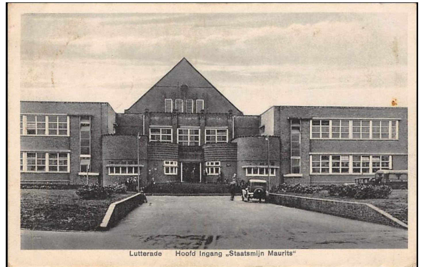
Afb.03: Hoofdingang Staatsmijn Maurits, nog compleet met achter de loonhal gelegen bad- en kleedgelegenhedengebouw, 1931 (HoC)
