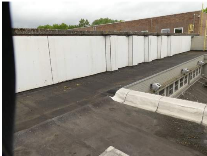
Afb. 5.6.25, door Trespa vervangen gevelbekleding, dak 09
