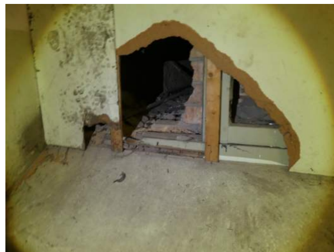
Afb. 5.4.24, plaatwerk tegen kozijn, originele kleur zichtbaar? gevel 16
