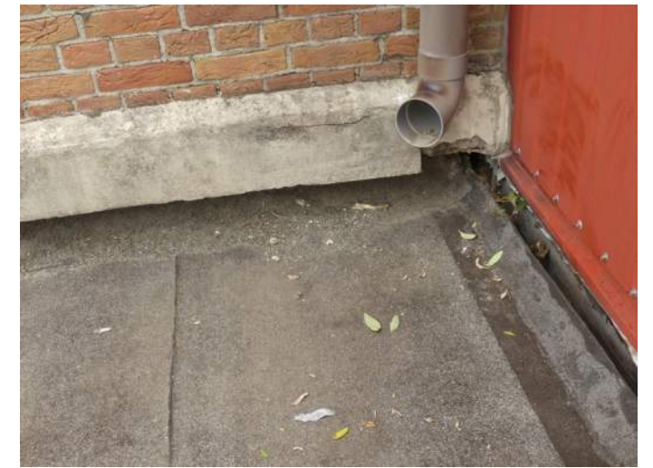
Afb. 5.2.10, afgebroken rand
