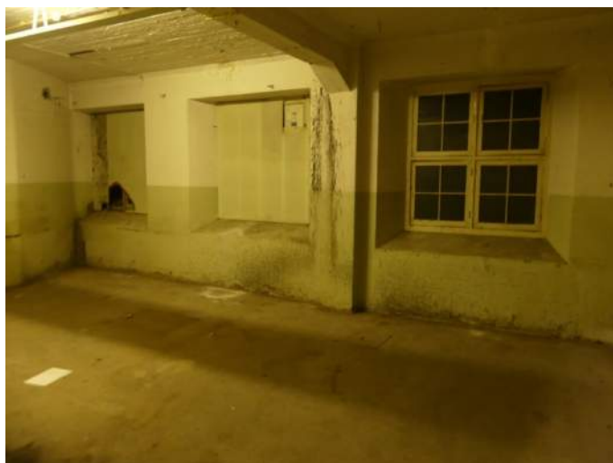
Afb. 5.4.23, koekoekkozijnen, gevel 15-16
