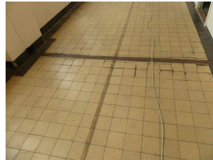
Afb. 5.12.57, tegelvloer met dilatatieprofiel
