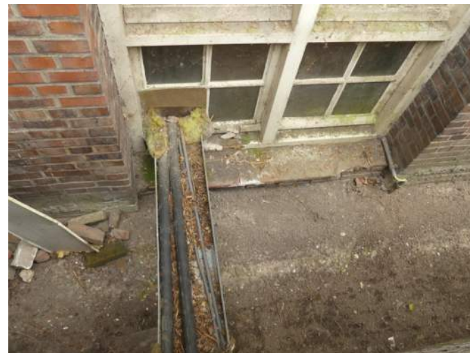
Afb. 5.4.17, ruitje vervangen door leidingbaan en plaat, gevel 10 a
