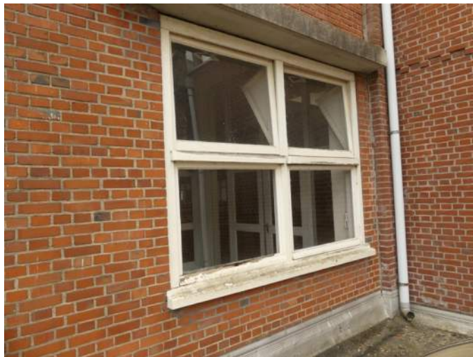
Afb. 5.4.07, origineel houten kozijn, gevel 07
