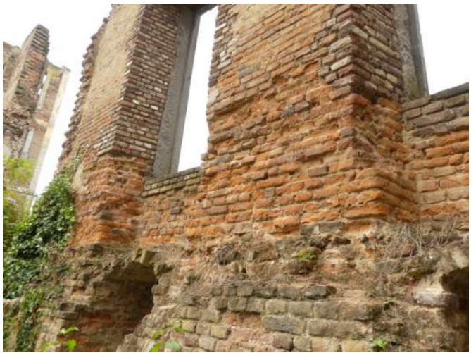
Afb. 01.30, kapotte muren onder hersteld werk, bewust?
