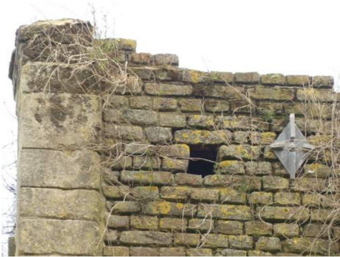
Afb. 01.07, losliggende lagen bovenzijde
