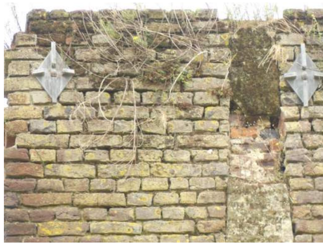
Afb. 01.08, losliggende lagen bovenzijde
