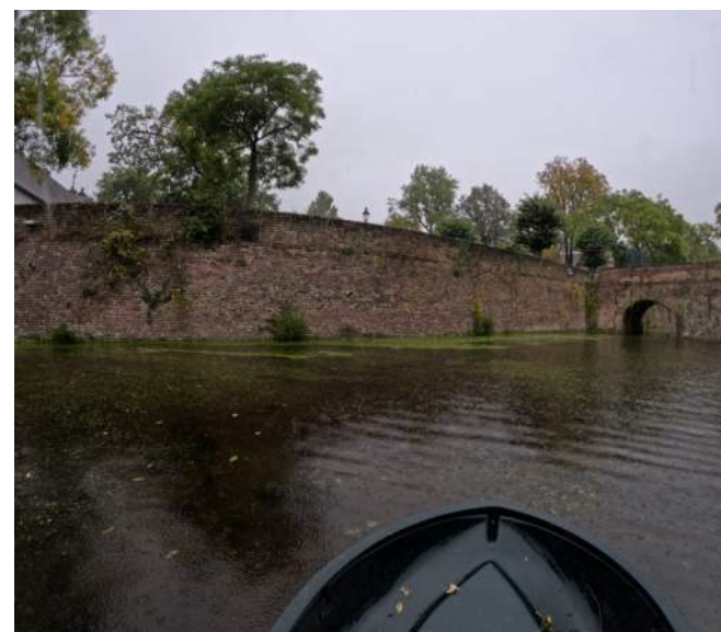
Afb. 04.03, overzicht grachtmuur met vegetatie
