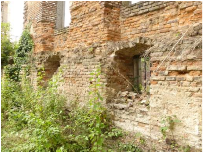
Afb. 01.29, kapotte muren onder hersteld werk, bewust?
