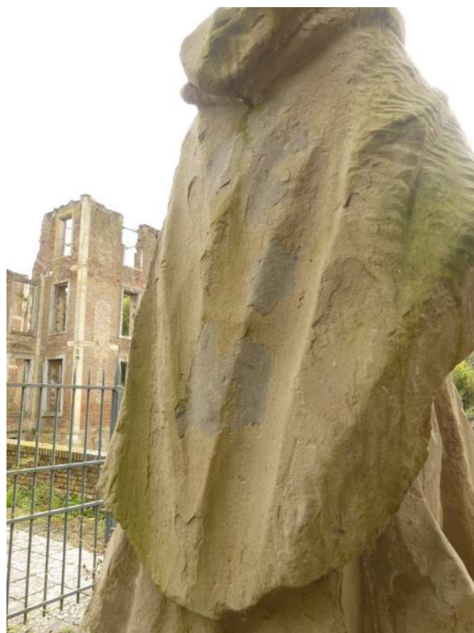
Afb. 02.16, afschilferend werk (staand leger?)
