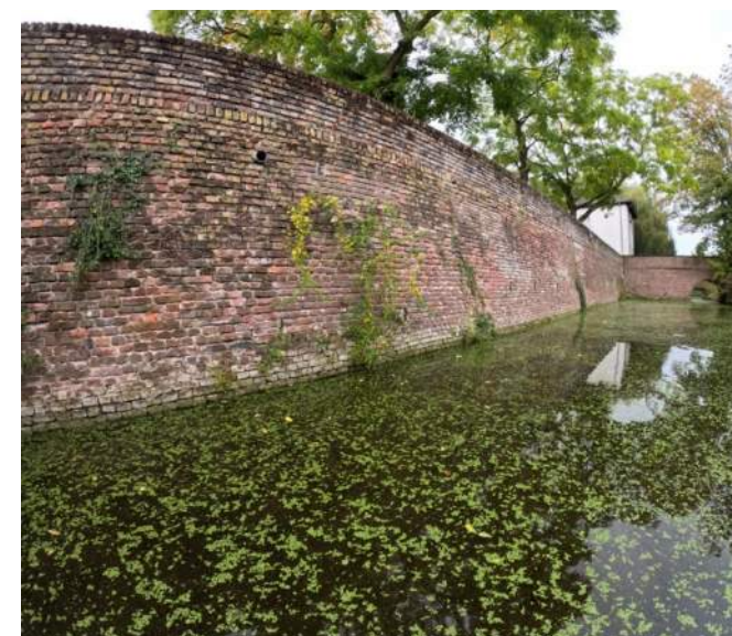
Afb. 04.04, overzicht grachtmuur met vegetatie
