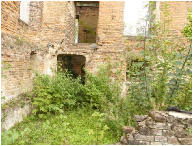
Afb. 01.25, kapotte stenen en scheuren
