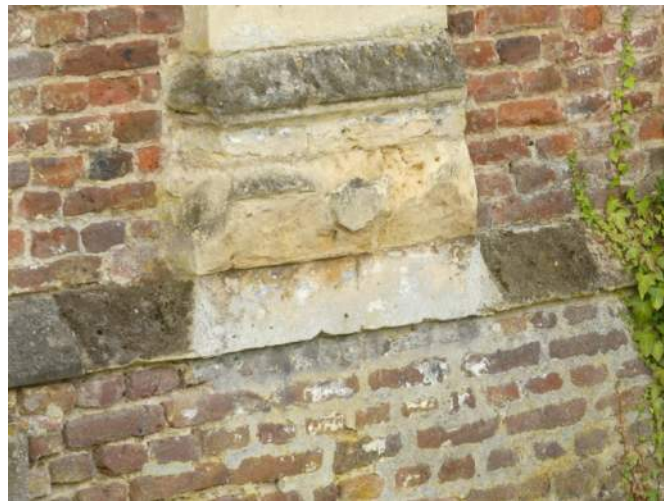
Afb. 01.10, afgeschilferd mergelblok
