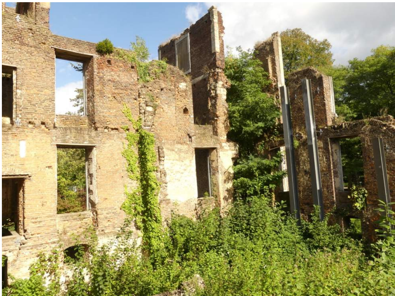
Afb. 01.05, overzicht binnenzijde ruïne, richting toren 2, met begroeiing en boom
