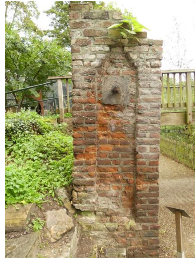
Afb. 05.01, penant met begroeiing, afgeschilferde stenen
