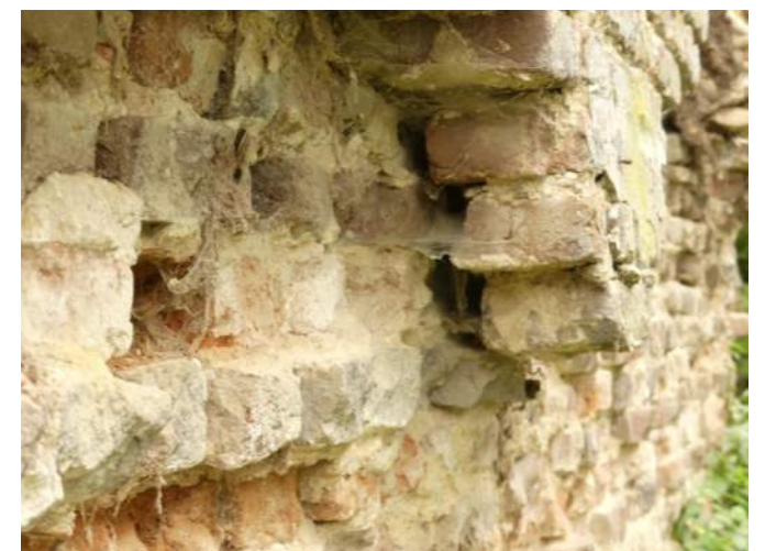
Afb. 01.18, loshangend gevelvlak
