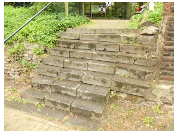
Afb. 05.03, trap met onregelmatig liggende bloktreden
