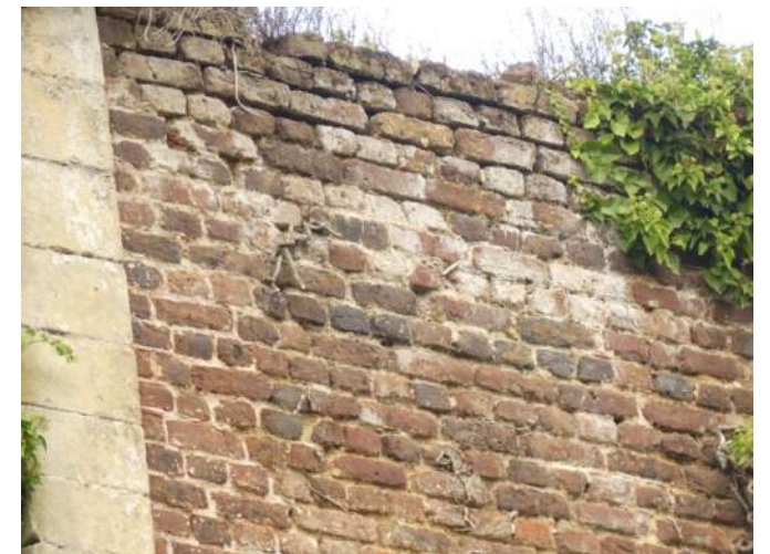
Afb. 01.14, losliggende lagen bovenzijde
