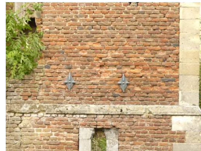
Afb. 01.15, afgeschilferde bakstenen
