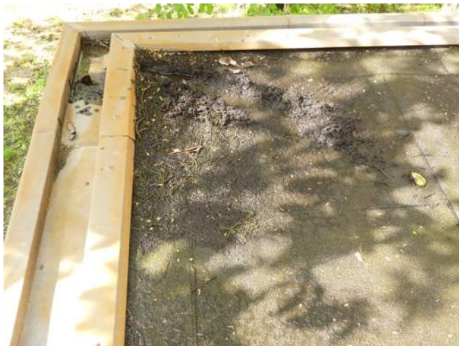
Afb. §33.33.05, veel troep bij snel verstopte afvoer, er is geen noodoverstort
