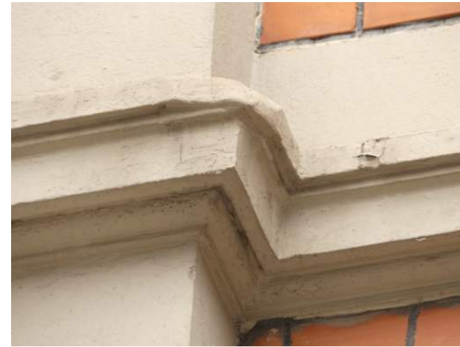
Afb. §40.09, gescheurd lijstwerk
