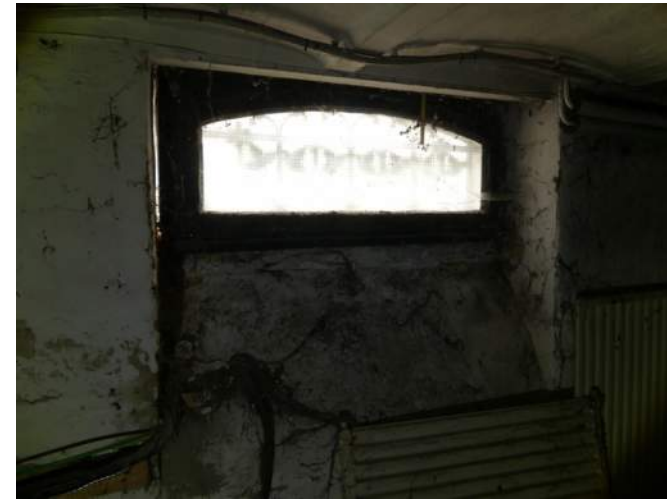
Afb. §89.19, raam aan voorgevel (met smeedwerk, afb.§43.04)
