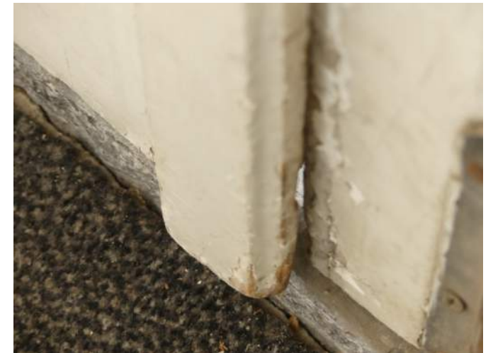
Afb. §30.08, ontbreken van tochtwering en slechte sluiting
