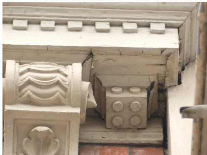
Afb. §46.21.06, afbladderende verf
