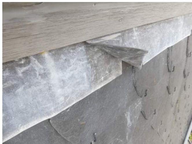
Afb. 35: loodstrook tegen het weer in en zonder felsrand en kruiskopschroeven in de boeiplank
