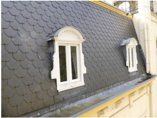
Afb. §33.87.43, overzicht dakkapellen vernieuwd dak achterzijde
