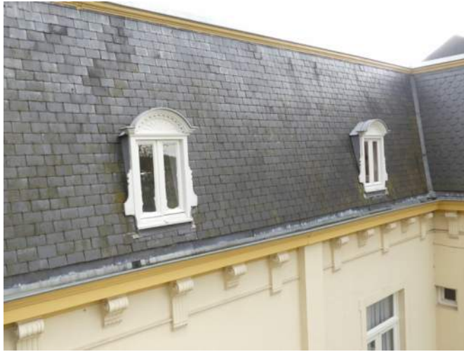
Afb. §33.51.13, overzicht origineel dak (11 – LB472)
