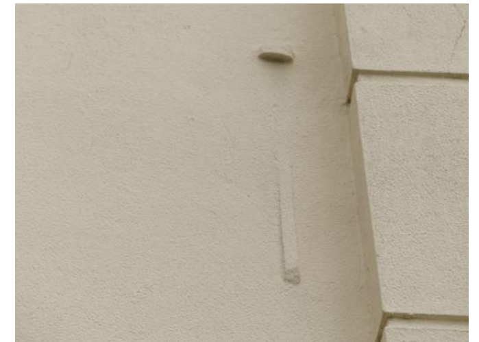
Afb. §43.10, anker in toren, bijna verzonken
