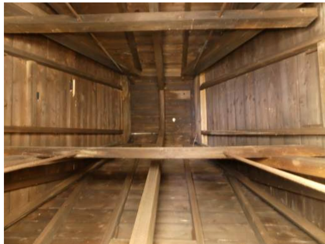
Afb. §24.15, overzicht onderste torenkap
