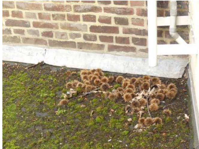
Afb. §33.33.02, blad- en vruchtenresten en mosaan groei (en oud lood boven vernieuwd plat dak, zie §33.87)
