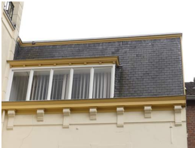
Afb. §33.51.15, overzicht origineel dak (09 – LB4712)
