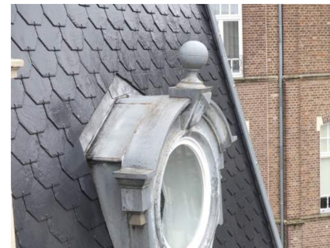
Afb. §33.87.20, nieuw lood boven oeil de boeuf, welke keuze?
