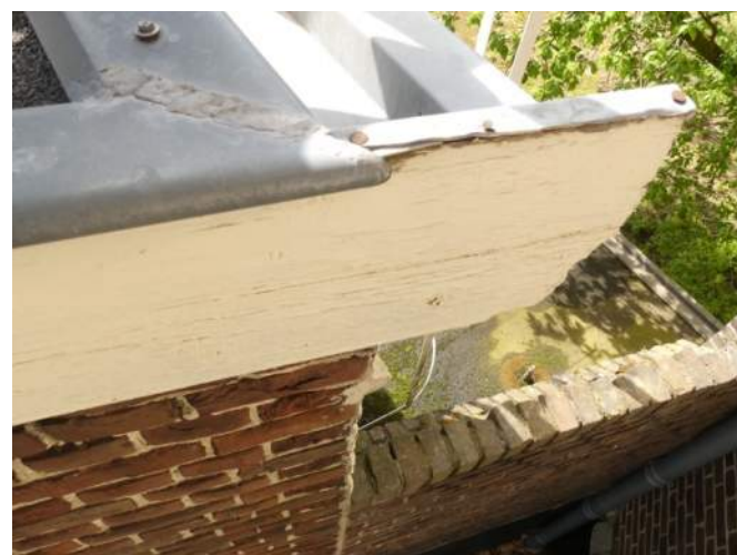
Afb. §33.87.30, in het zicht genagelde strook dak
