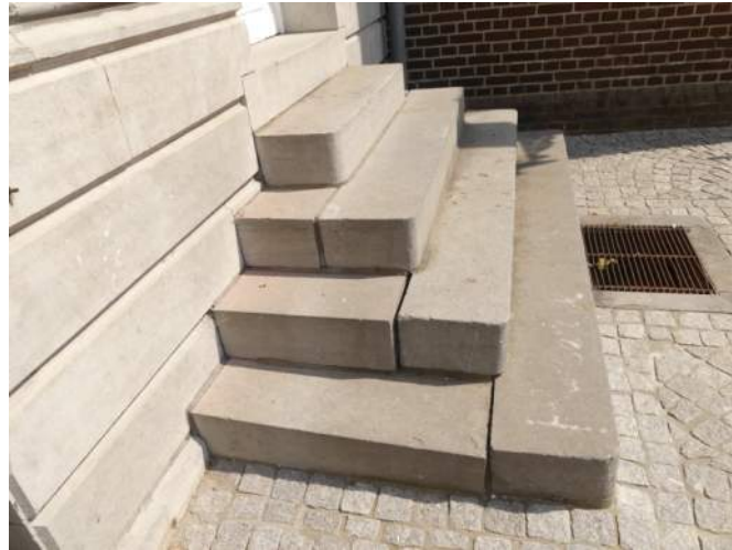
Afb. §35.38, uitgespoelde voegen en iets verschoven tredes
