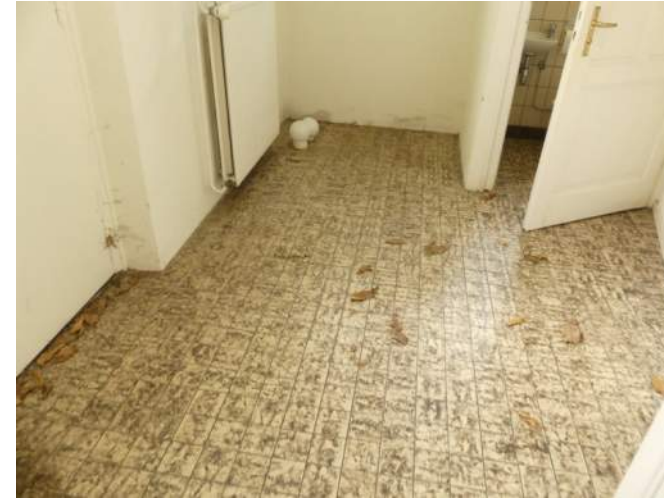
Afb. §41.07, tegelvloer dienstvertrek met toilet
