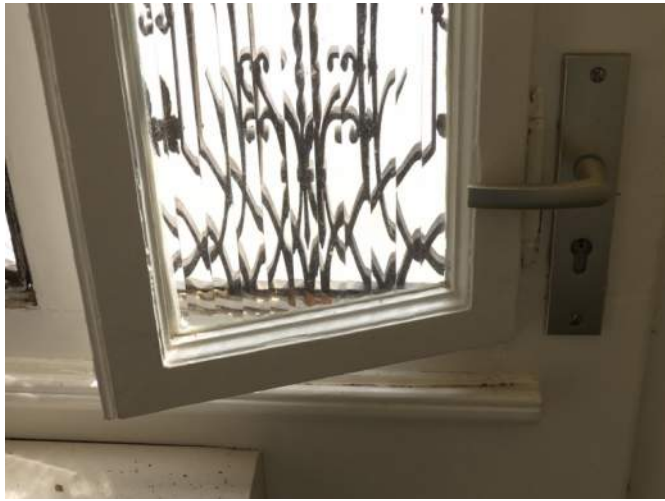
Afb. §30.11, foutieve moderne handgreep binnenzijde
