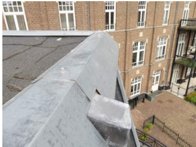
Afb. 33: lichtmetalen afdek, houten onderconstructie zichtbaar
