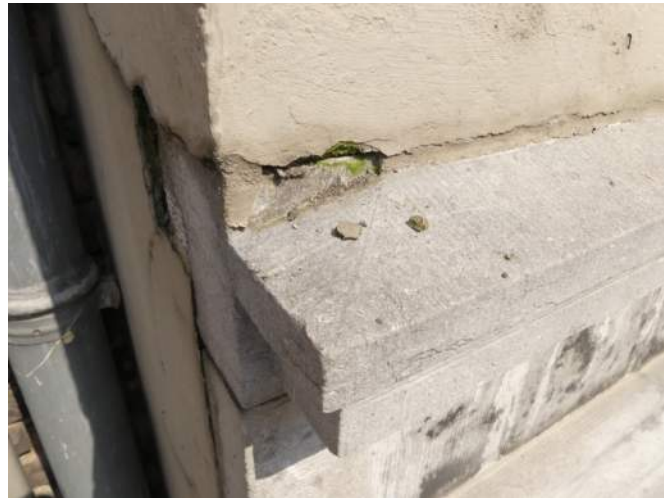
Afb. §40.16, gescheurd lijstwerk
