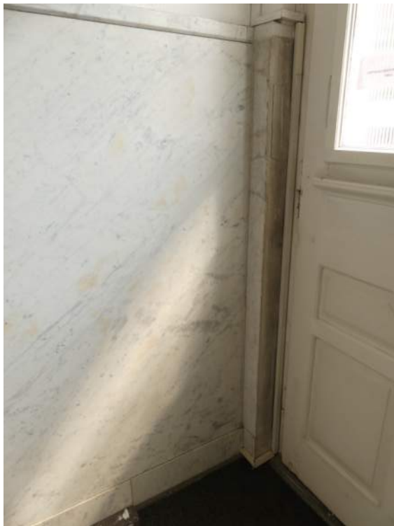
Afb. §35.53, hoekbekleding lambrisering-deurkozijn
