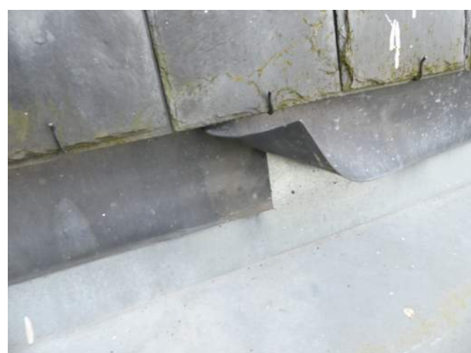
Afb. §33.87.18, ontbrekend felskantje bij overlap (onder bestaand werk), overlap te kort!
