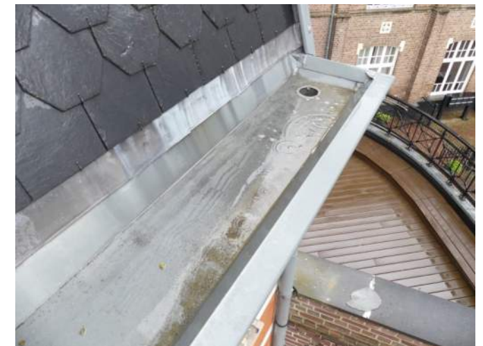
Afb. §33.87.40, goot niet op afschot, afwijkende neuslijst (vgl. met afb. §33.87.31, vlakke neuslijst)
