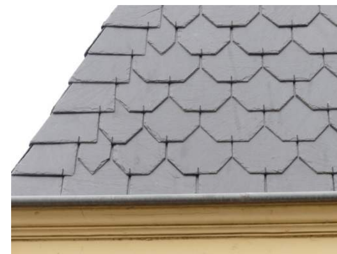
Afb. §33.51.34, te kleine zijdelingse overlap bij keperaansluiting zeer onrustig werk, zowel esthetisch als technisch
