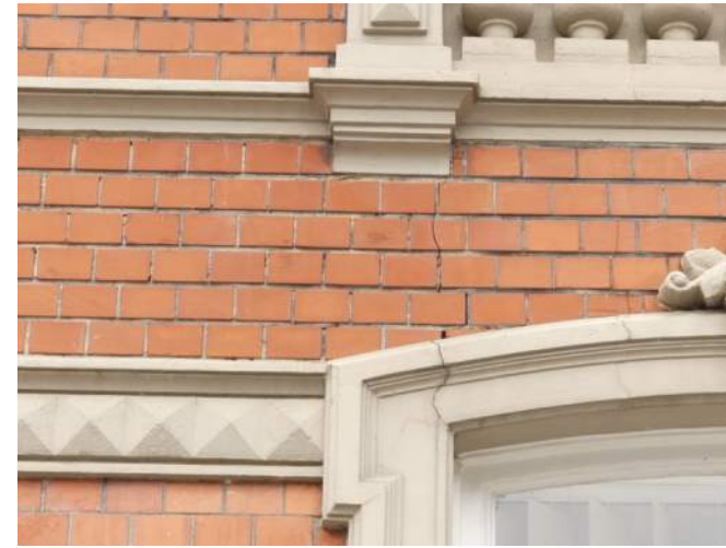
Afb. §40.07, gescheurd lijstwerk
