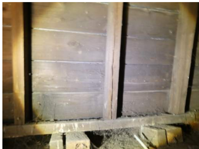
Afb. §24.17, gebarsten spoor
