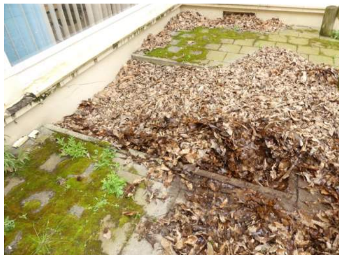
Afb. §30.28, achtergevel binnenplaats, keldertrap en raam-opening souterrain (dichtgezet?)
