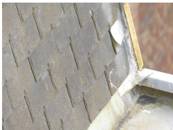
Afb. §33.51.30, uitzakkende koperen leihaken, opgewaaid indeklood
