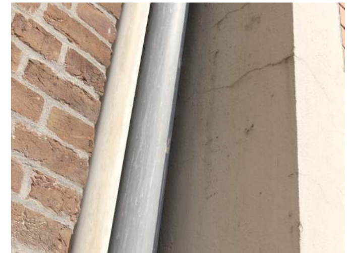
Afb. §40.12, gescheurd lijstwerk
