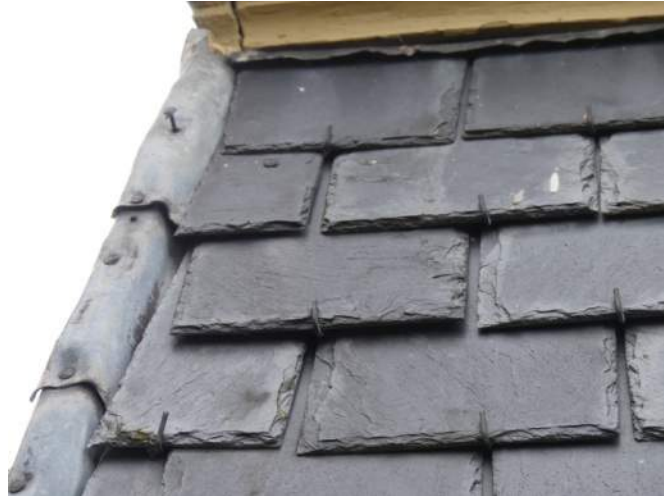
Afb. §33.51.18, nagels in zicht, uitgezakte leien, indeklod in zicht genageld (één nagel zonder trekkracht), uitzakkende koperen leihaken
