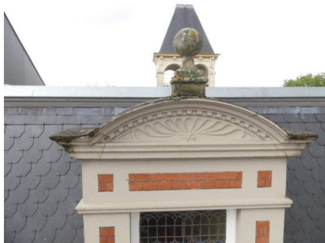
Afb. §35.26, fronton dakkapellen met op beide hoeken openstaand dakleer
