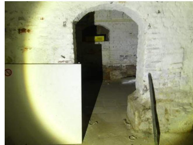
Afb. §89.09, doorgang naar andere souterrain-ruimtes
