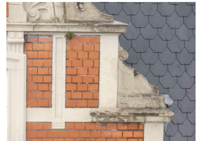
Afb. §35.24, vervuild en gescheurd werk
