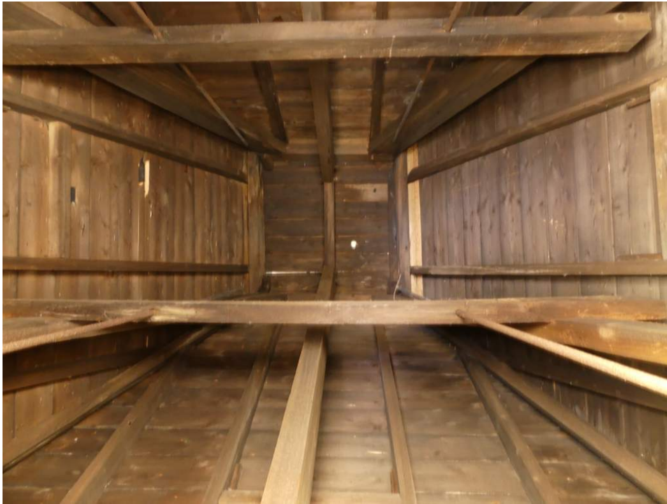
Afb. 19: overzicht torenkap naar boven toe, met rode pijlen de vier 'losse' stangen aangegeven
