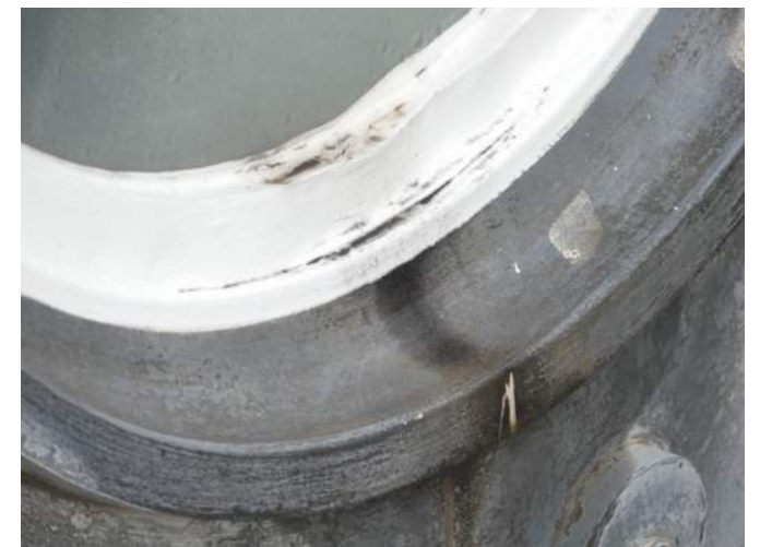
Afb. §30.22, aangetaste en niet correct herstelde dorpel oeil de boeuf-kozijn
