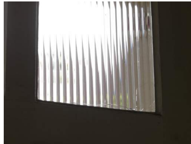
Afb. §34.31.11, gescheurd figuurglas
