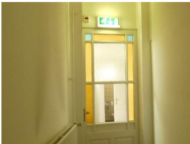
Afb. §34.31.05, aanzicht dienstdeur vanuit gang, met (waarschijnlijk vervangen) blank enkel glas midden onderin en bij deurgreep afwijkend gekleurd glas
