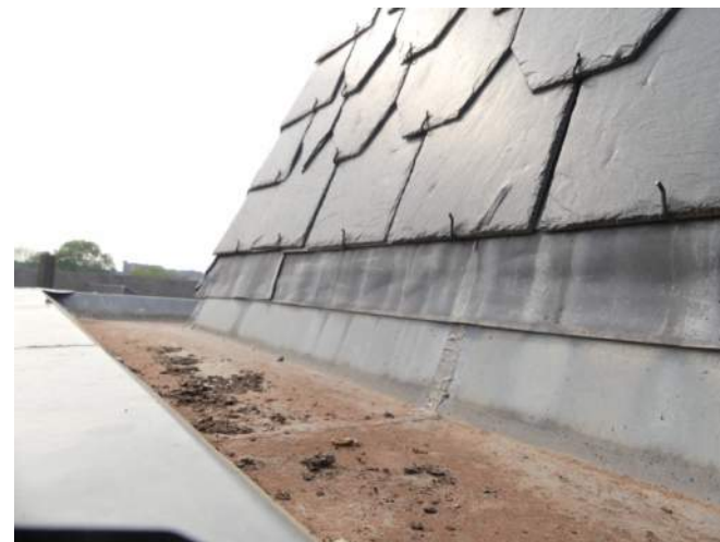
Afb. §33.51.35, openstaande klemhaken (dus zonder functie)
