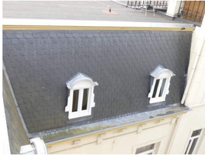
Afb. §33.51.14, overzicht vervangen dak
