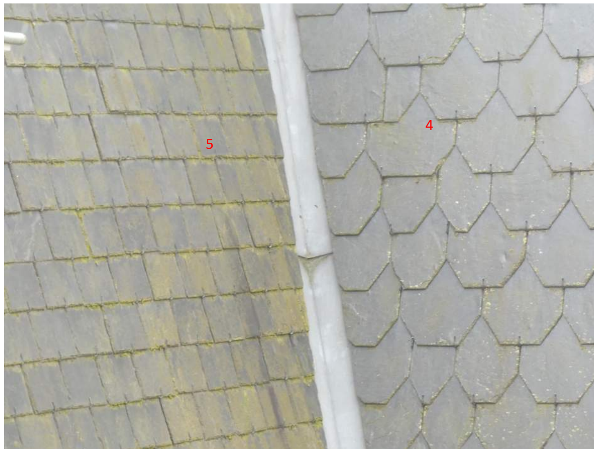
Afb. 27: bestaand en vernieuwd leiwerk op daken aan de achterzijde
