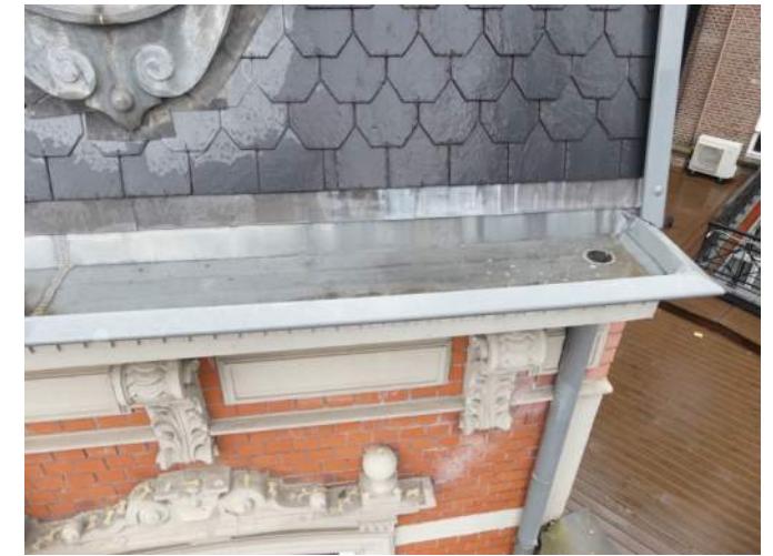
Afb. §50.08, 'schuine' neuslijst, afwijkend van de bij de linker-goot toegepaste rechte neuslijst
