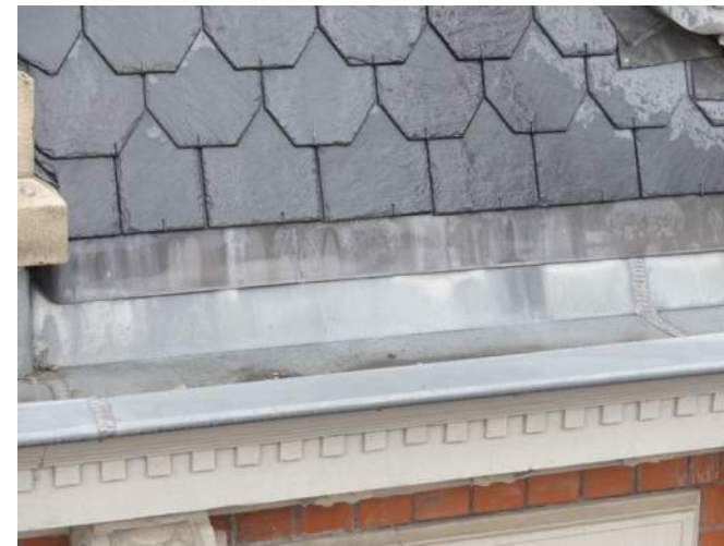
Afb. §33.51.07, te steile lamme koppen (vgl. afb. §33.51.03)
