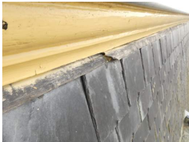
Afb. §33.51.26, uitzakkende koperen leihaken, te smal lood
