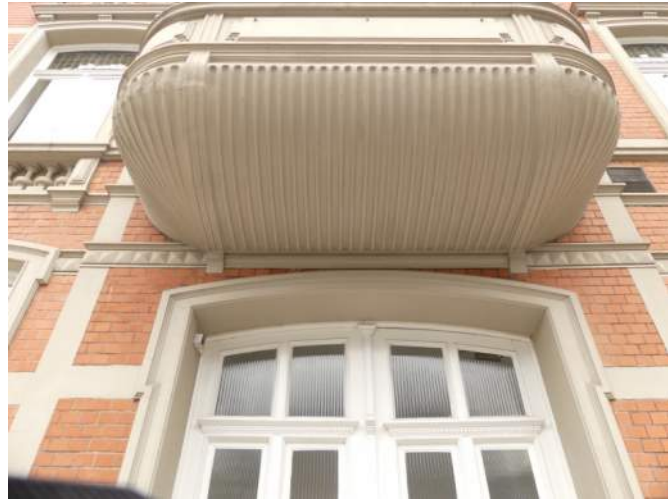
Afb. §40.23, onderaanzicht erker met gepleisterde cannelures
