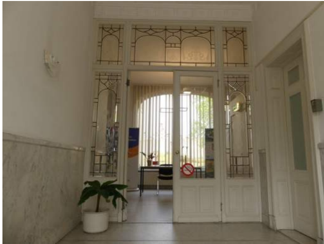
Afb. §34.31.01, overzicht vestibulepui met facetgeslepen glas
