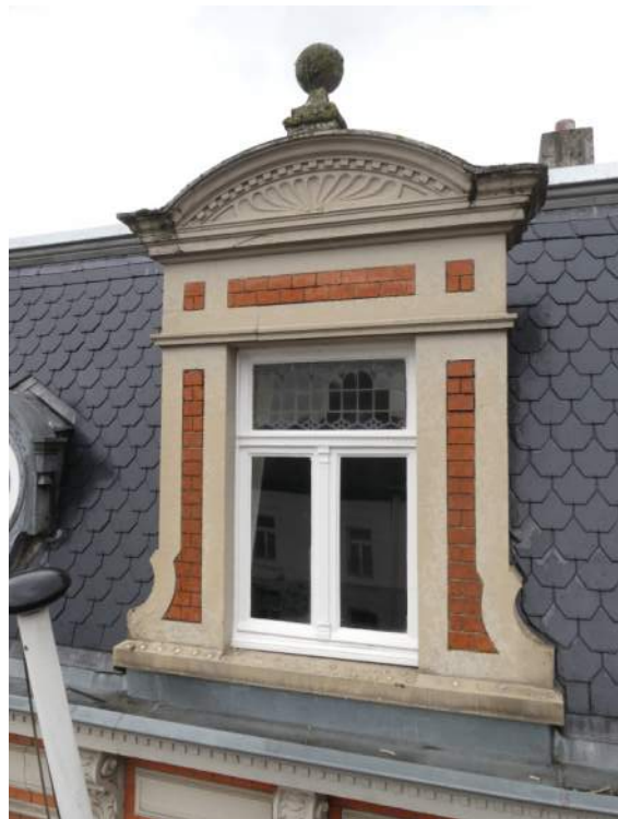
Afb. §35.25, stenen dakkapellen
