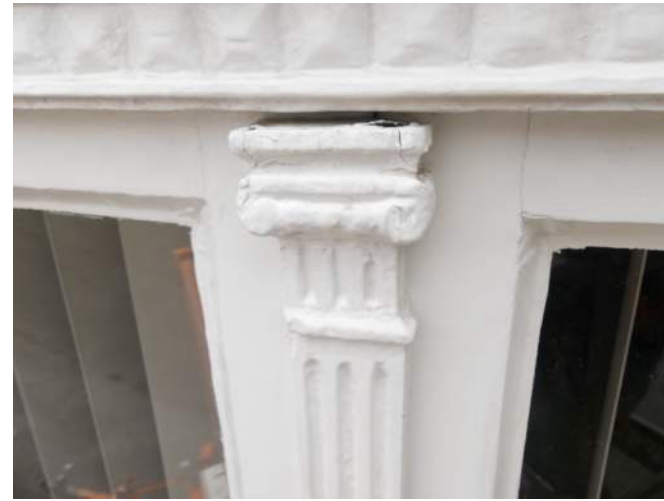
Afb. §46.21.19, veel te dikke verf op fijn gedetailleerd werk
