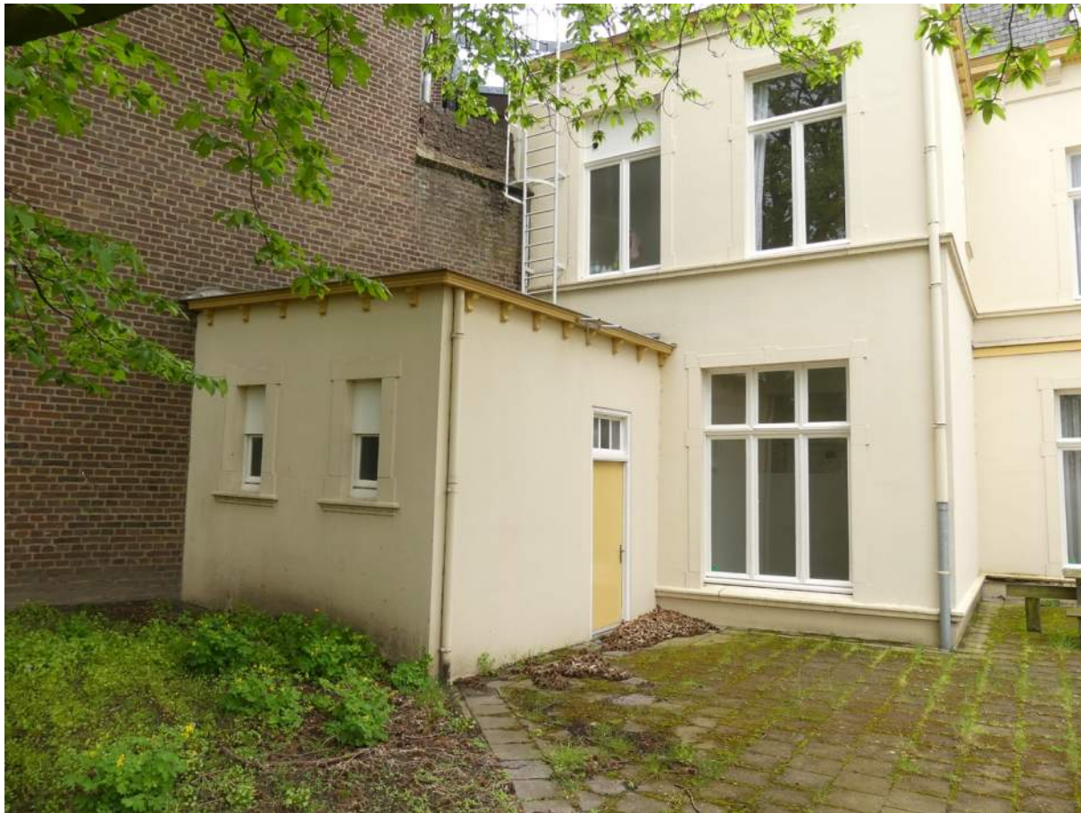
Afb. 8: achtergevels aanbouw achterzijde
