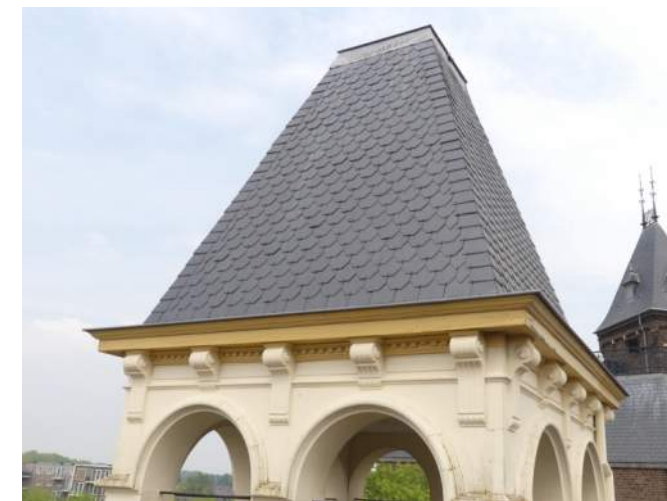
Afb. §33.51.32, aanzicht vervangen leiwerk toren
