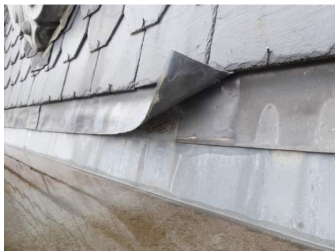
Afb. §33.87.15, ontbrekend felskantje bij overlap (nieuw werk)
