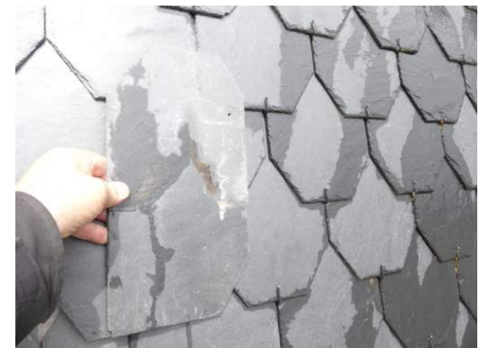
Afb. §33.51.12, overlap is wel voldoende (>6cm), maar de lei is niet genageld
