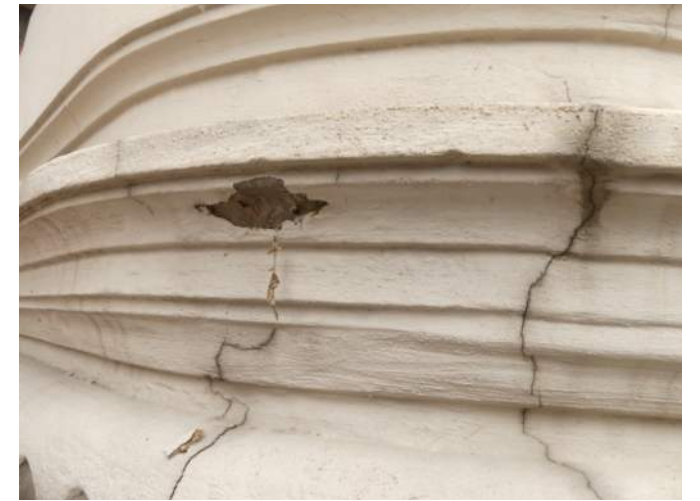
Afb. §40.30, onthecht verfwerk na voorzichtig aanraken
