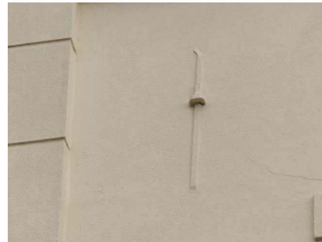
Afb. §43.09, anker in toren, aan oppervlakte
