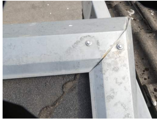
Afb. §33.87.56, hoek afdekkap, schroeven in liggend werk verhinderen thermisch reageren van afdekkap
