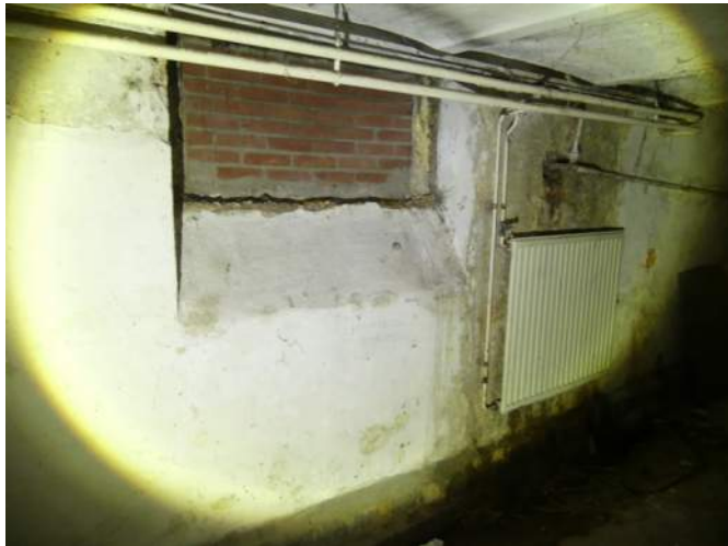
Afb. §89.15, dichtgezette opening achtergevel
