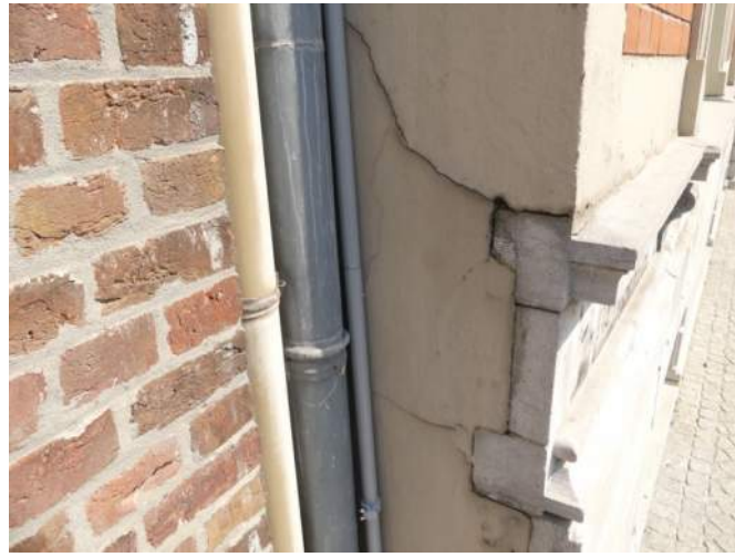
Afb. §40.14, gescheurd lijstwerk
