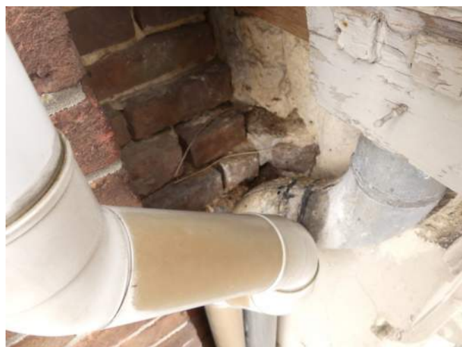
Afb. $50.17, hwa-aansluitingen van bakgoot Huis Van Vesseem en van Jochem Erenshoes (PVC)
