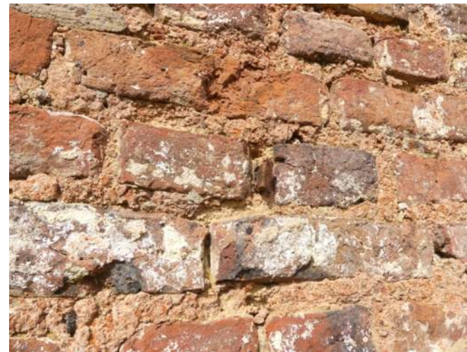
Afb. §22.35 oud ijzer en gekleurde voegen, grove mortel
