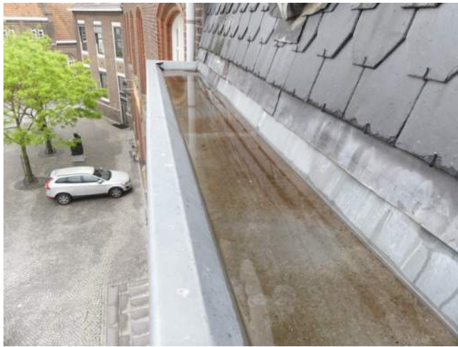
Afb. §50.03, verkeerd afschot linkse goot
