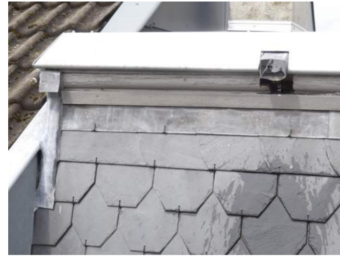
Afb. §33.87.07, eindaansluiting dak met gevel en lijst
