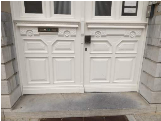
Afb. §30.03, enigszins uitgezakte deuren met modern beslag
