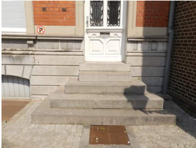
Afb. §35.37, natuursteentrap dienstingang
