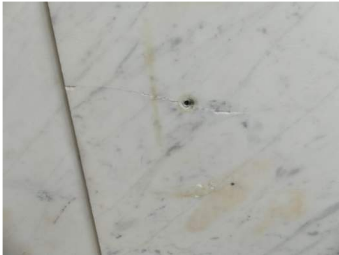
Afb. §35.51, ongelijke plaat, boorgaatje met scheur
