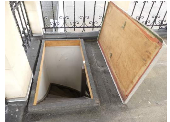
Afb. §33.87.42, luik torengalerij, zonder goede grendels, stormketting en randdetaillering
