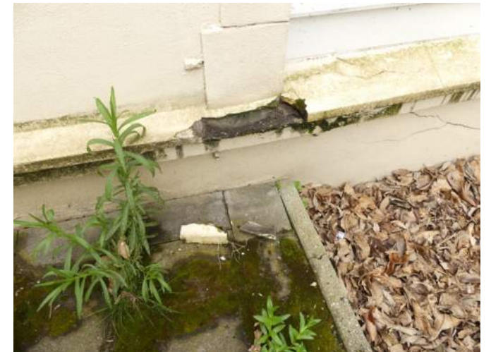
Afb. §35.32, afgebroken neut
