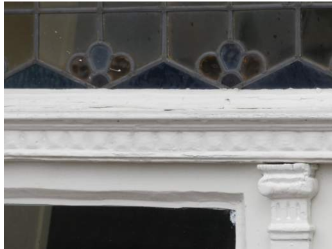
Afb. §46.21.18, barsten in liggend werk, veel te dikke verf op fijn gedetailleerd werk
