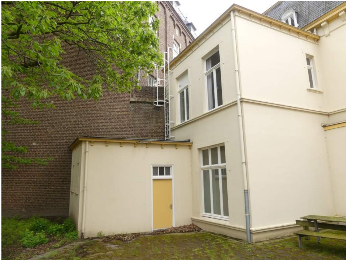
Afb. 7: zijgevel aanbouw achterzijde
