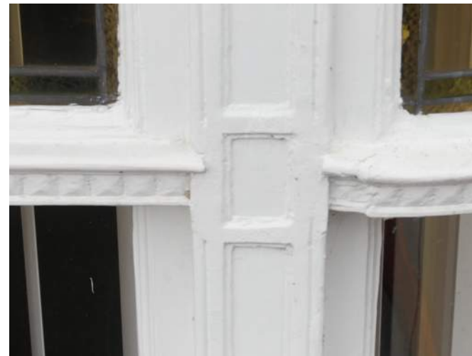
Afb. §30.21, detail aansluiting kalf erkerkozijn
