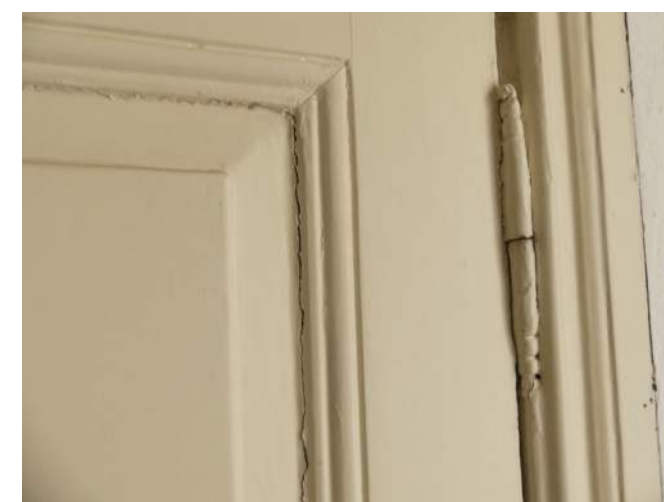
Afb. §46.21.46, losgekrompen verf op binnendeur
