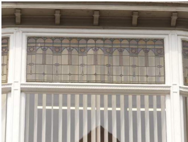
Afb. §34.25.03, uitgezakt gedeformeerd middenpaneel
