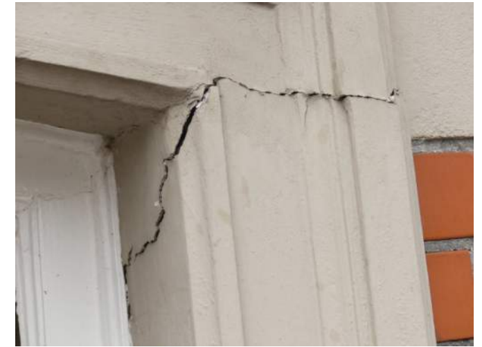
Afb. §40.10, gescheurd lijstwerk
