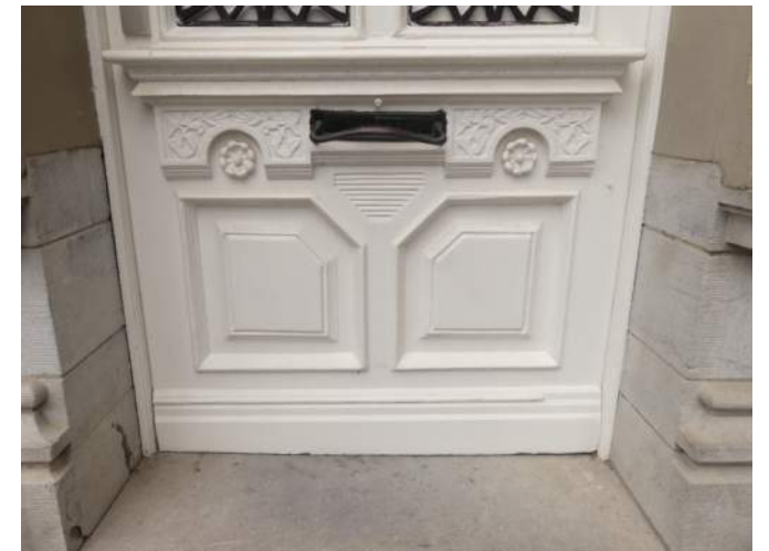
Afb. §30.10, uitgezakte deur, originele handgreep met brievenbus
