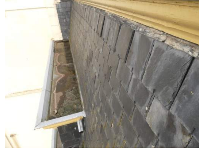
Afb. §33.51.23, uitzakkende koperen leihaken, te smal lood
