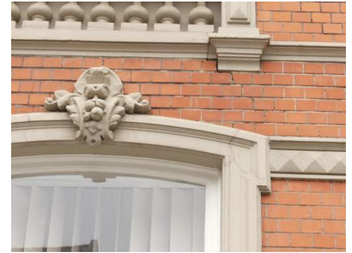
Afb. §40.08, gescheurd lijstwerk
