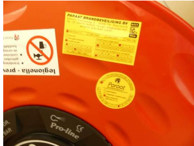
Afb. §54.02, laatst uitgevoerde onderhoud in januari 2020, dit dient, volgens NEN-EN 673-1 jaarlijks te gebeuren
