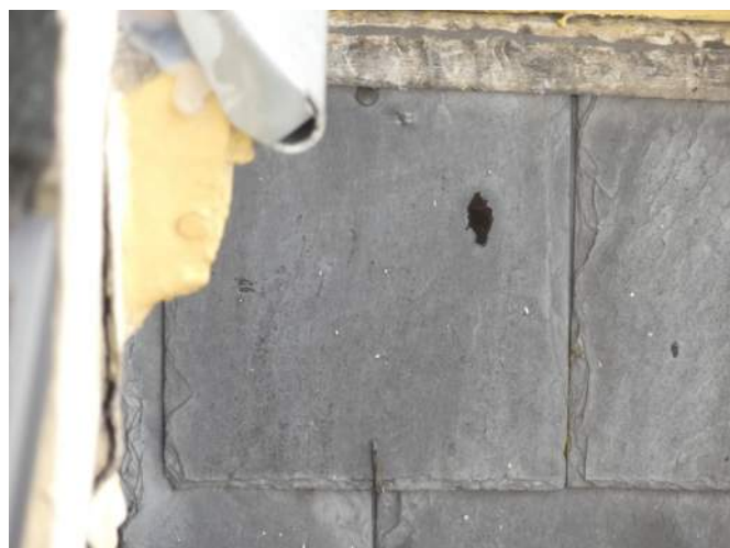
Afb. §33.51.28, gat in lei, nagel in het zicht (te smal lood)
