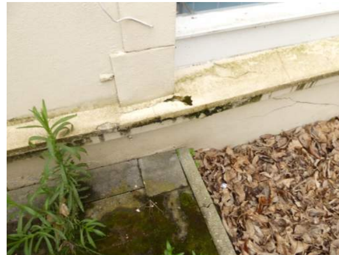
Afb. §35.31, dorpel groot raam met schade aan neut
