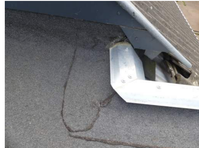
Afb. §33.87.53, 'koude' aansluiting afdekkap (geen ingewerkt lood)
