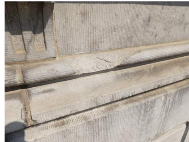
Afb. §35.11, afgescheurde profiellijst
