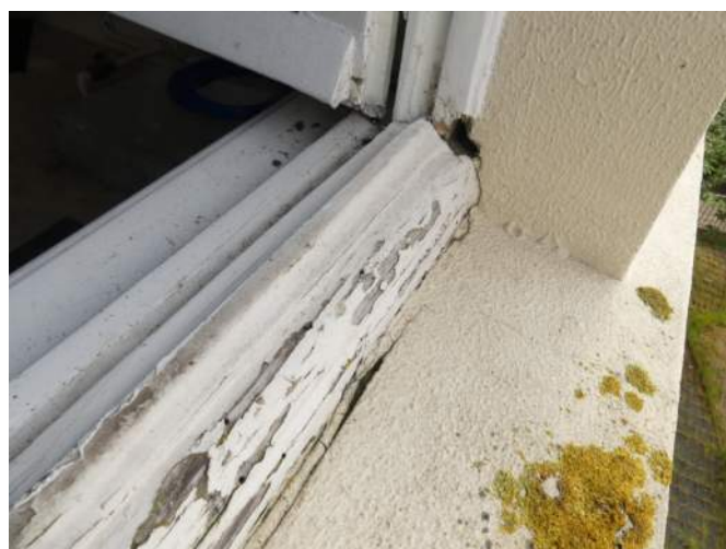
Afb. §46.21.40, volledig versleten verfwerk, let ook op onder-aansluiting met gepleisterde raamdorpel
