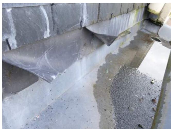
Afb. §33.87.17, ontbrekend felskantje bij overlap (nieuw werk)
