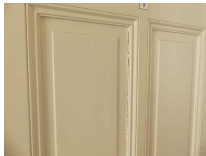
Afb. §46.21.47, losgekrompen verf op binnendeur
