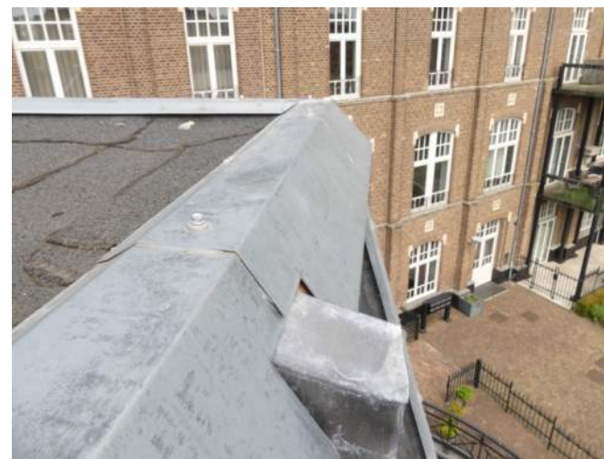
Afb. §33.87.53, overlap met kit 'afgedicht', kit hecht -zéker zonder primer- niet op zink
