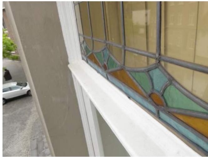
Afb. §34.25.14, uitgezakt geformeerd bovenlichtpaneel
