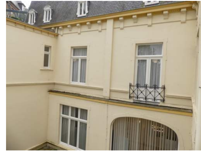
Afb. §33.87.31, overzicht achterzijde met verspringende gevel
