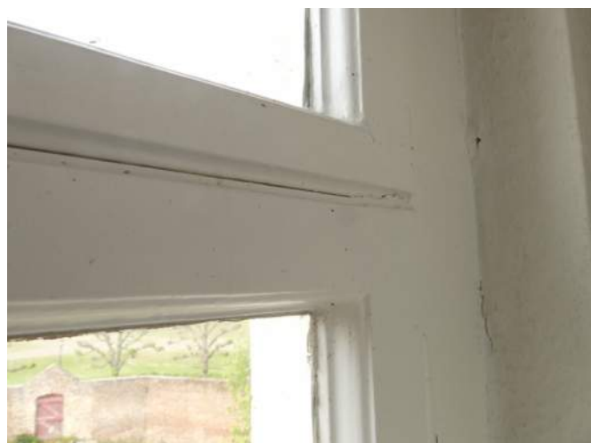
Afb. §46.21.41, het schilderen lijkt bij een gesloten raam te zijn gebeurd, getuige de verfbarst op de raamdorpel...
