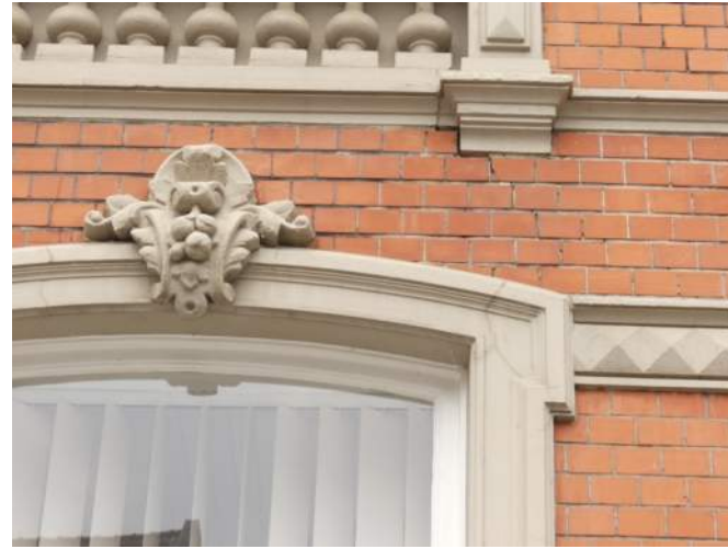
Afb. §22.02 scheuren tussen beletage en verdieping
