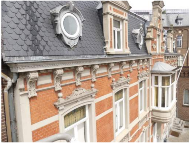
Afb. §33.87.31, overzicht dak voorzijde
