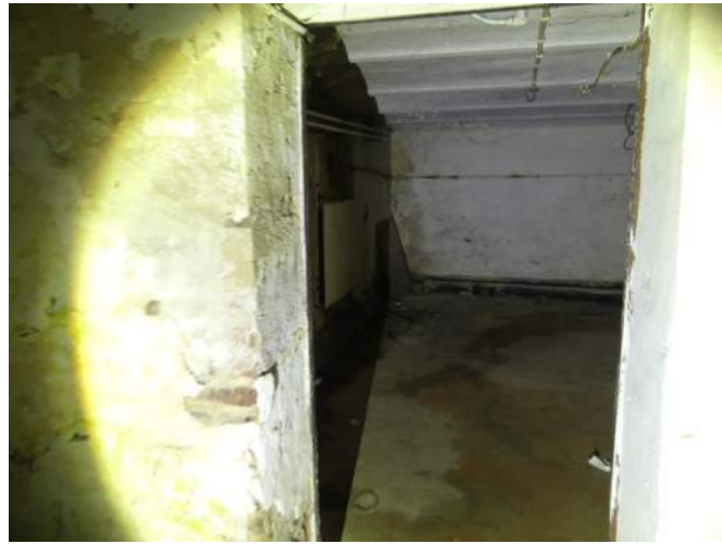
Afb. §89.14, doorgang naar troggewelfliggerplafond
