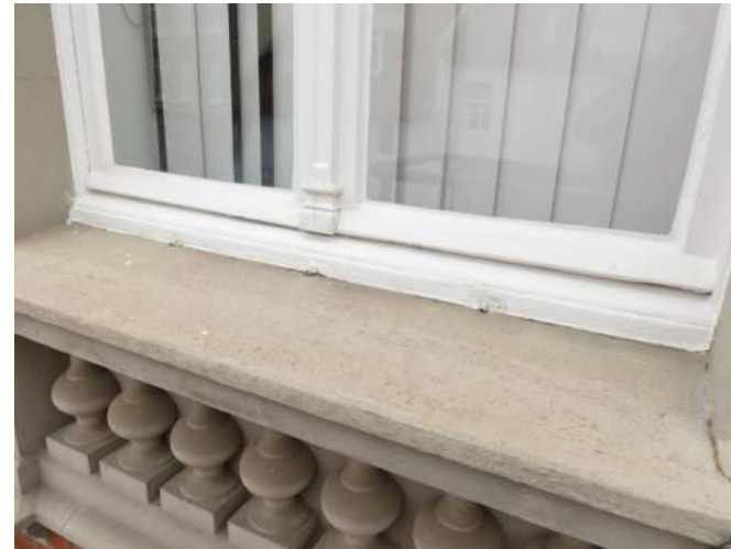
Afb. §46.21.23, barsten op liggend en gedetailleerd werk
