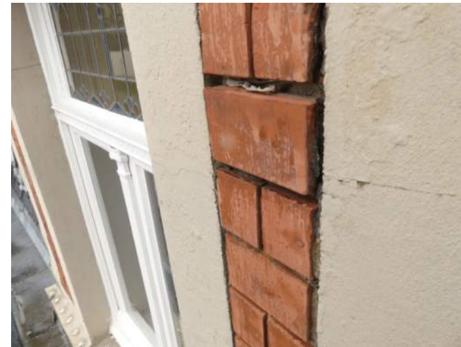
Afb. §22.09 uitgespoeld voegwerk en loszittende 'tegels'
