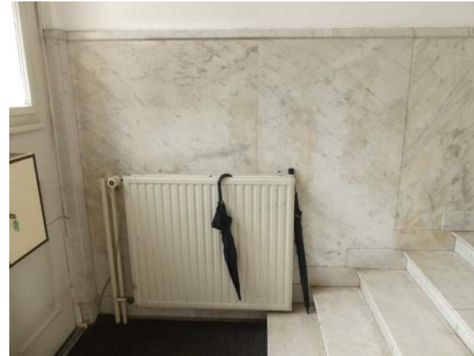
Afb. §35.43, lambrisering linkerwand vestibule
