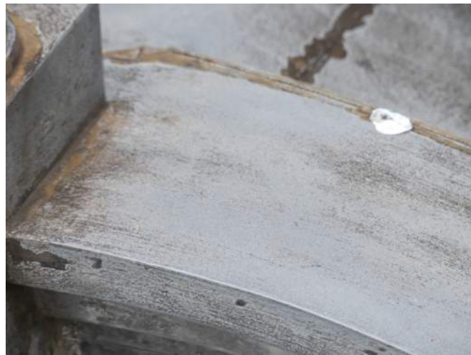
Afb. §33.87.34, ingezakte verbindingen, verweerd zink
