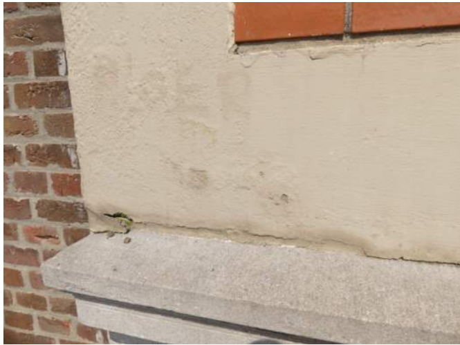
Afb. §40.15, gescheurd lijstwerk
