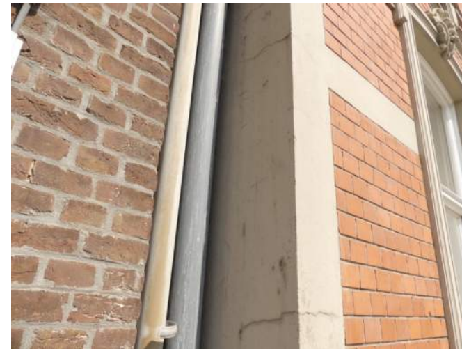
Afb. §40.11, gescheurd lijstwerk
