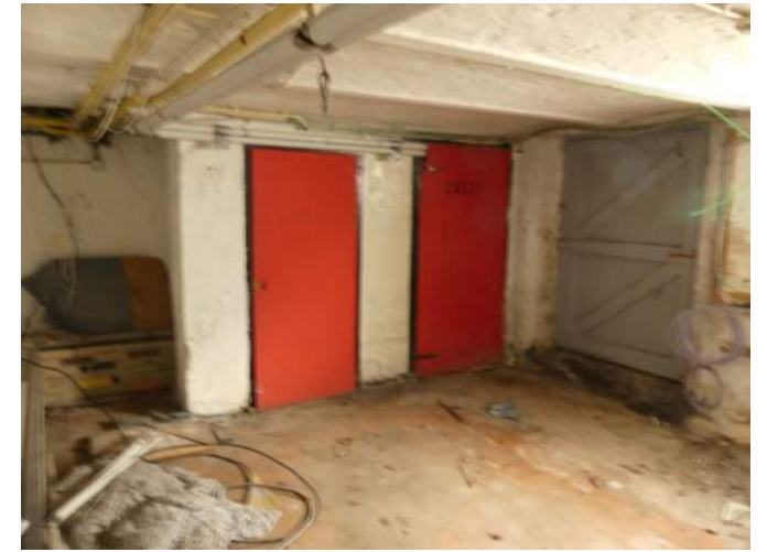
Afb. §89.20, troggewelfliggers met klampdeur naar voorgevel en twee paneeldeuren
