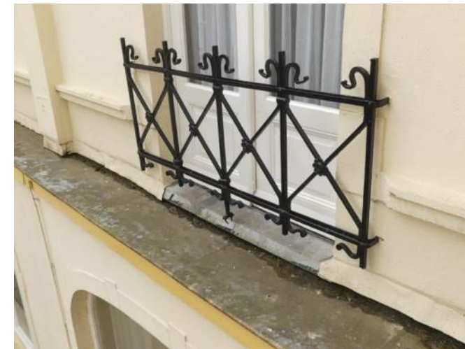
Afb. §33.87.33, ontbrekende felsrand bij aansluiting dorpel
