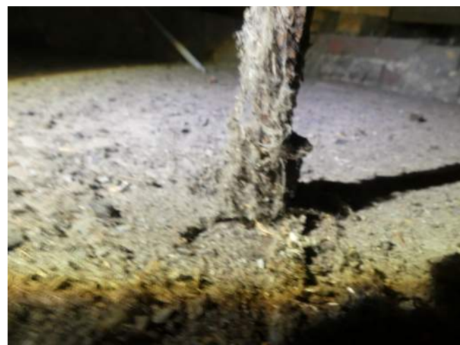
Afb. §24.18, losstaande ankerstaven bovenste torenkap
