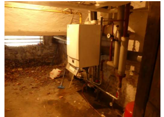
Afb. §89.24, ruimte onder vestibule met kelderkoekoek naar ijzeren mat (afb.§43.03), grote betonbalk en een cv-installatie
