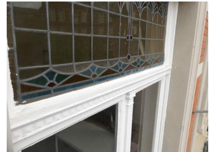
Afb. §34.25.12, uitgezakt geformeerd bovenlichtpaneel
