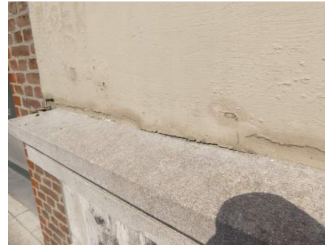
Afb. §46.23.09, degraderende, verpoederende en vochtbelaste verf op onderste gevellijst
