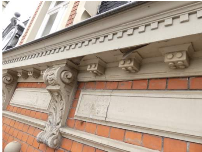
Afb. §46.21.01, geornamenteerde bakgoot voorgevel
