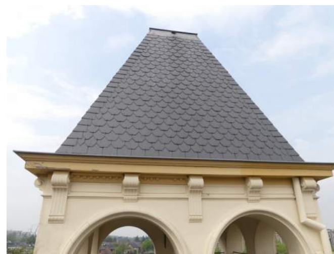
Afb. §33.51.33, aanzicht vervangen leiwerk
