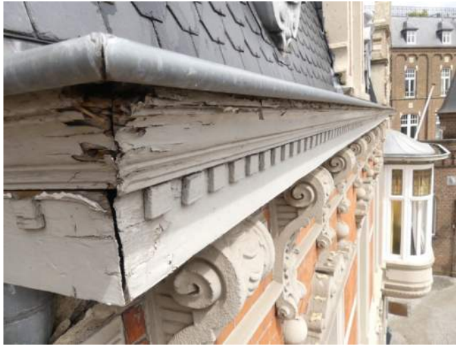
Afb. §50.01, overzicht neuslijn bakgoten voorgevel, verloopt niet in één strakke lijn
