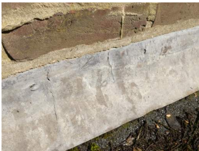
Afb. §33.87.29, scheurtjes in oud lood boven vernieuwd plat dak
