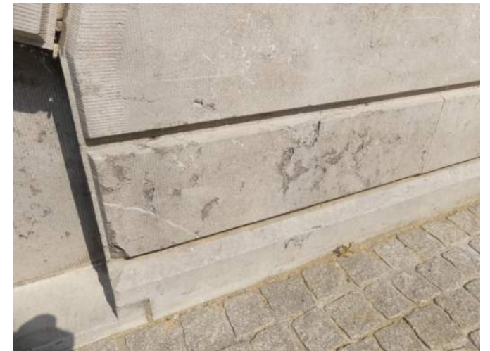
Afb. §35.08, uitgespoeld voegwerk, brandlagen en afgebroken stukje
