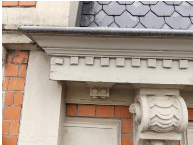
Afb. §24.05, beschadigde bloklijst
