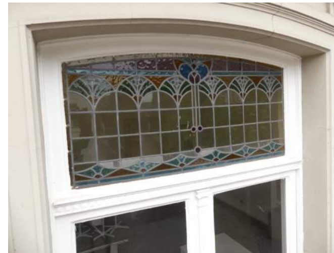
Afb. §34.25.11, uitgezakt geformeerd bovenlichtpaneel
