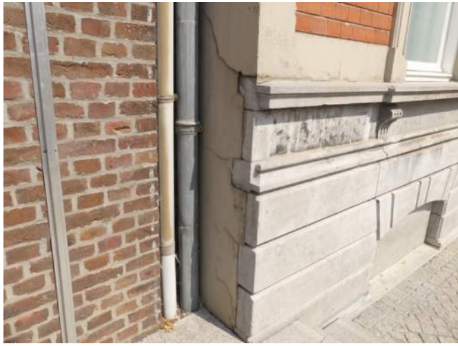
Afb. §40.13, gescheurd lijstwerk
