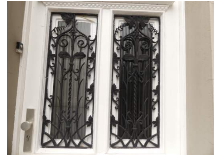
Afb. §43.06, smeedijzeren rooster dienstdeur, een ontbrekende spiraalkrul en ontbrekend drielobbig blad
