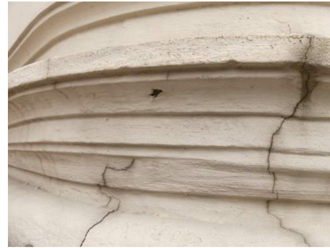
Afb. §40.29, blaasvorming onder verfwerk
