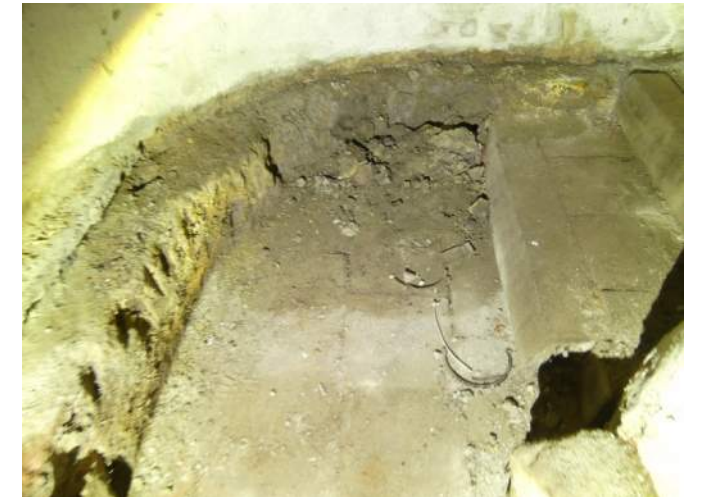
Afb. §89.10, bocht met traptredes uit stoeprand en trottoirtegels
