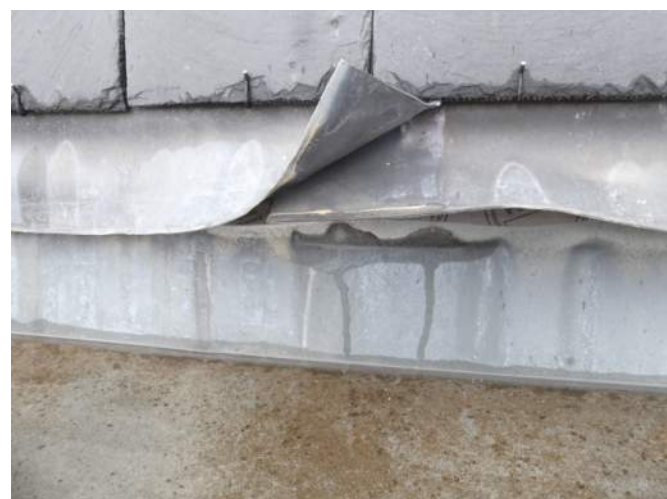
Afb. §33.87.16, ontbrekend felskantje bij overlap (nieuw werk), zie vochtsporen voor noodzaak
