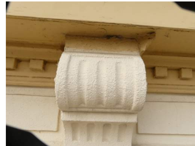
Afb. §24.21, weggefallen profiellijsten
