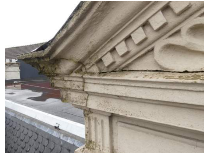
Afb. §35.19, scheuren in fronton, hoek en veld
