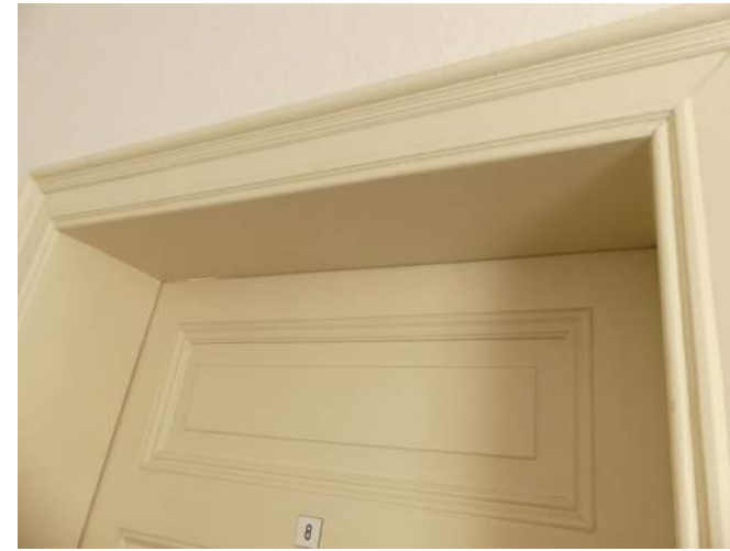
Afb §30.29, niet goed sluitende binnendeur
