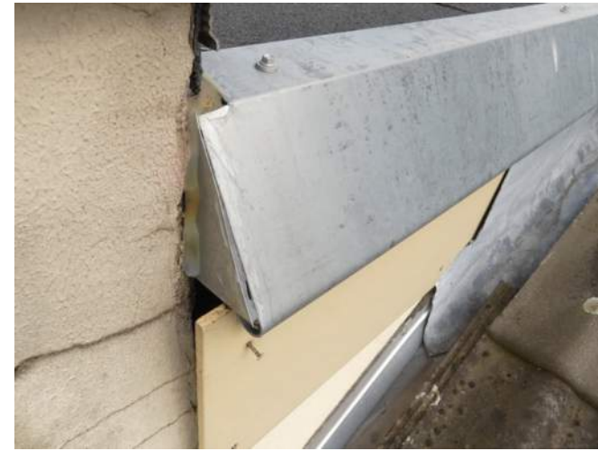
Afb. §33.87.53, met kit afgedichte openstaande naden
