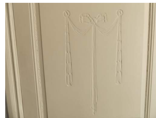
Afb. §46.21.48, losgekrompen verf op decoratief paneel
