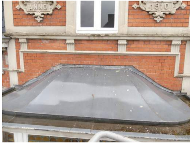
Afb. §33.87.02, aanzicht loodaansluitingen
