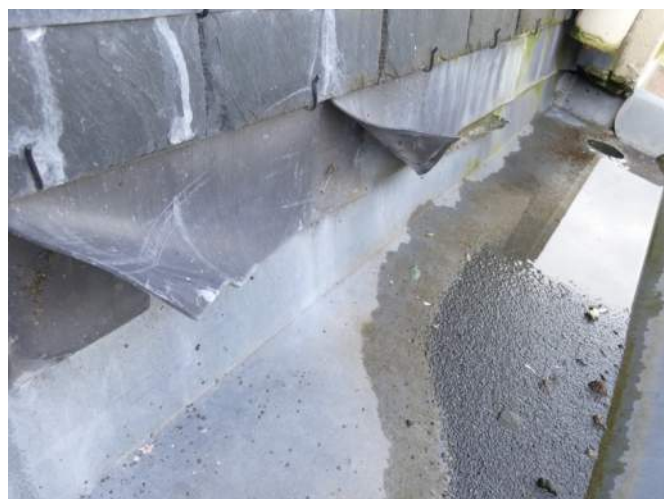
Afb. $50.15, bakgoot richting toren, slecht afschot
