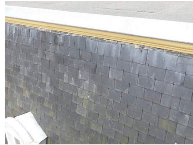
Afb. §33.51.19, afwijkende (op z'n kant geplaatste) stroomlaag
