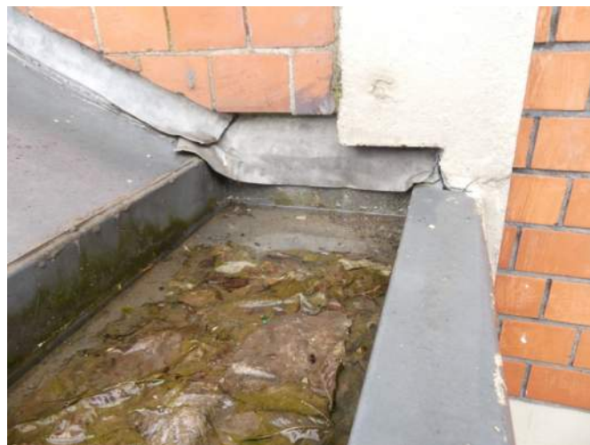
Afb. §33.87.06, niet aangedreven muurlood, geen felsrand bij onvoldoende overlap, aansluiting kraal onvoldoende
