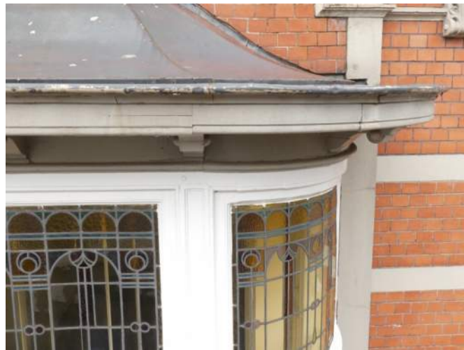
Afb. §24.13, openstaande verbindingen
