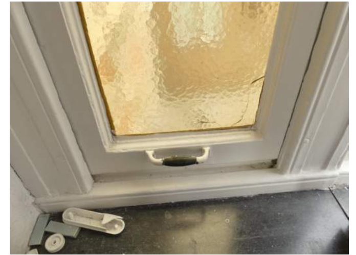
Afb. §34.31.08, gescheurd gekleurd glas schuifraampje in de erker
