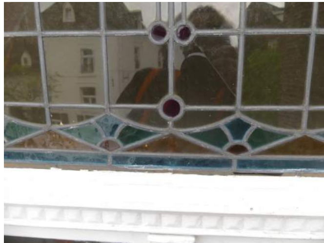
Afb. §34.25.16, uitgezakt geformeerd bovenlichtpaneel met gescheurd ruitje
