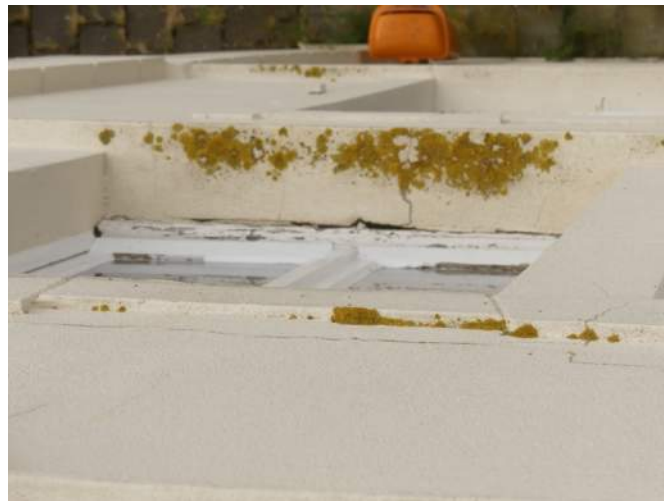
Afb. §40.18, scheuren in lijsten en dorpels torengelvel
