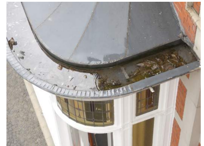
Afb. §50.12, na weghalen blad voor spuwer kan regenwater uit de goot
