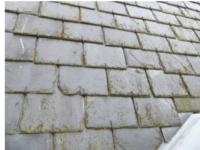
Afb. 38: voorbeeld versleten leiwerk op achterste dakvlak
