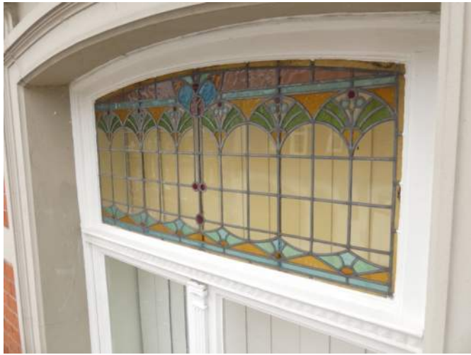
Afb. §34.25.13, uitgezakt geformeerd bovenlichtpaneel
