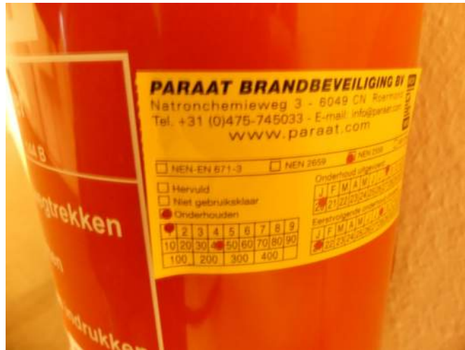
Afb. §54.03, laatst uitgevoerde onderhoud in januari 2020, dit dient, volgens NEN-EN 673-1 jaarlijks te gebeuren
