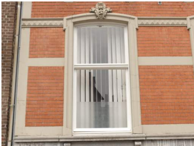
Afb. §30.13, aanzicht schuiframes beletage
