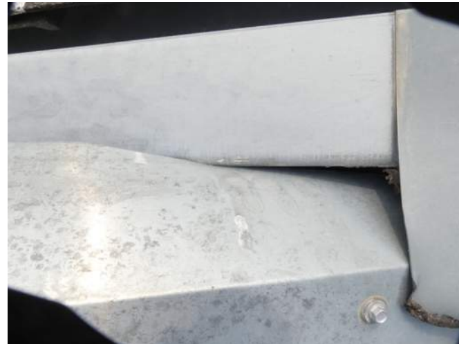
Afb. §33.87.54, detail zonder waterkering
