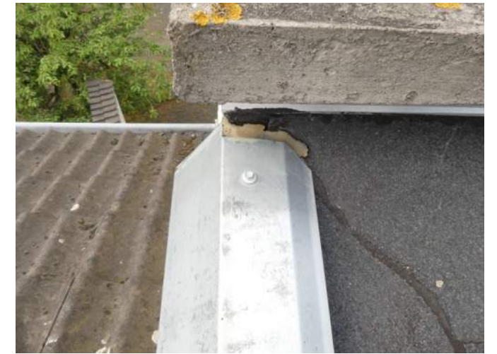
Afb. §33.87.54, 'koude' aansluiting afdekkap (geen ingewerkt lood)
