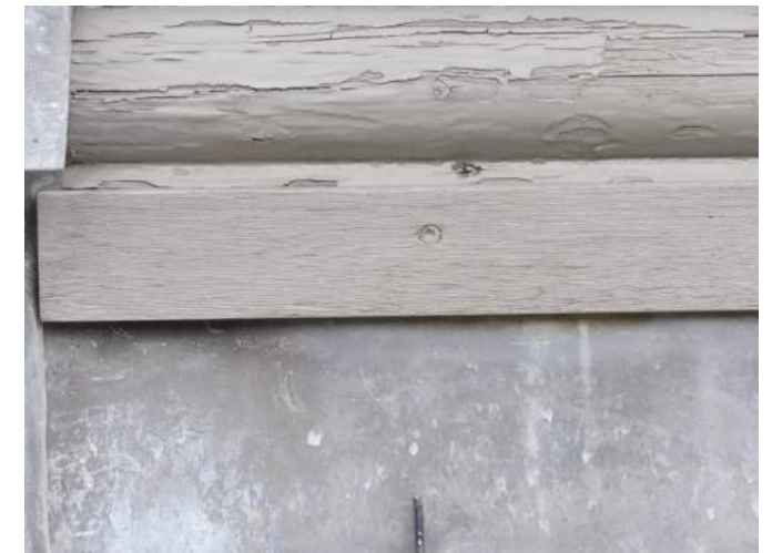
Afb. §46.21.10, gebarsten verf op kraallijst, de meranti lat lijkt alleen gegrond
