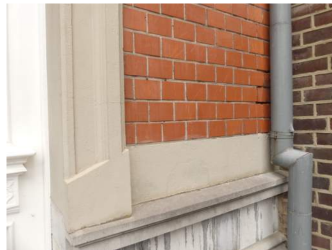
Afb. $50.19, hwa rechts op de voorgevel, haakse bochten kunnen makkelijk voor verstopping zorgen
