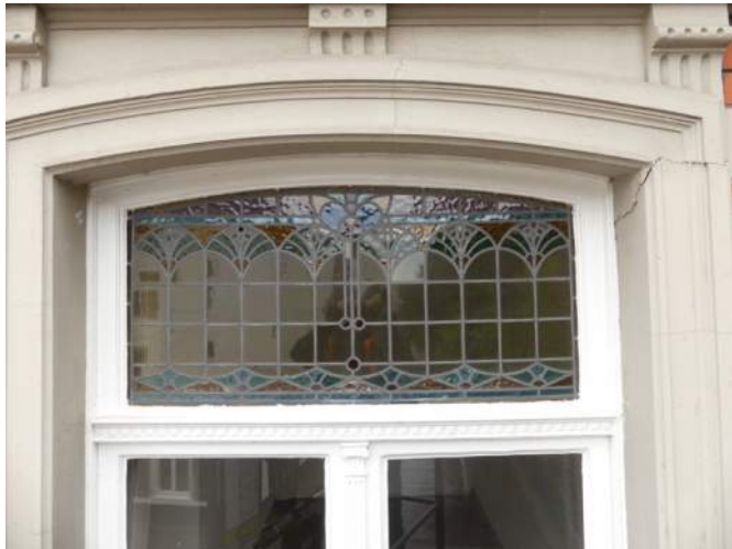
Afb. §34.25.15, uitgezakt geformeerd bovenlichtpaneel
