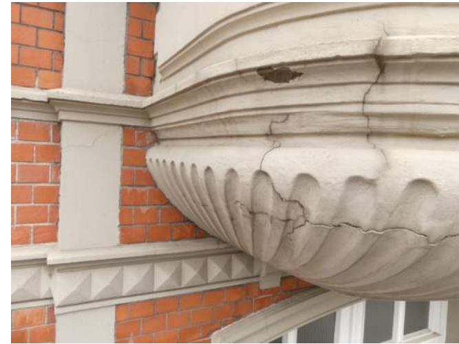
Afb. §40.31, onthecht verfwerk boven scheuren
