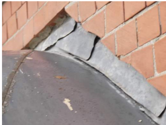
Afb. §33.87.04, niet aangeklopt muurlood
