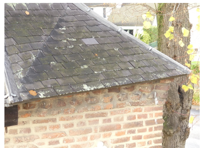
Afb. §33.02, overzicht rechterhoek dak voorzijde
