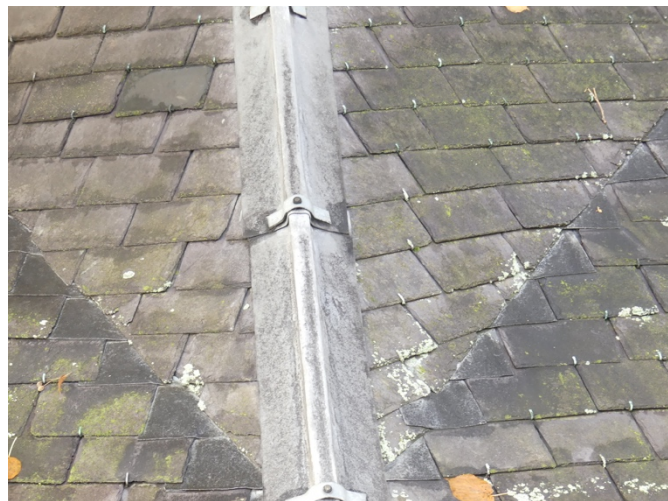
Afb. §33.04, foutieve reparatielei, scheefgezakte, weggevallen (pas-)leien, sommige alleen genageld, koperen leihaken
