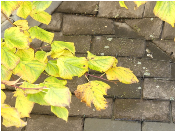
Afb. §33.19, scheefgezakte en slordig gedekte leien (gapers bij Inwendige hoek), koperen leihaken
