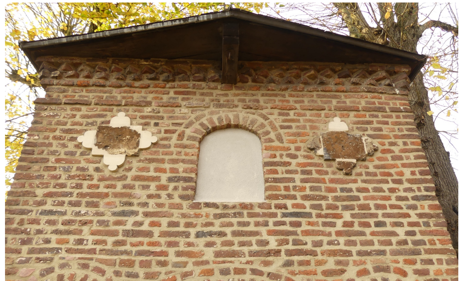
Afb. 14: onderzijde dakoverstek voorzijde
