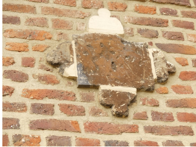
Afb. §35.02, grof herstelde (aangevulde?) cartouche, rechts op de voorzijde
