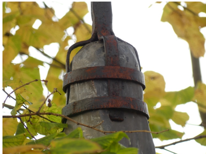
Afb. §43.02, roestvorming op starten en banden
