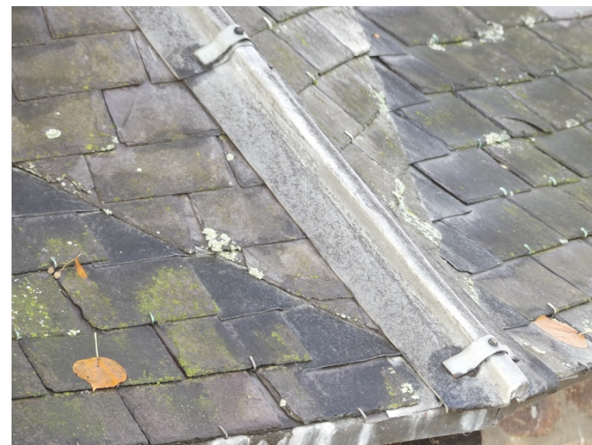
Afb. §33.13, dunne (versleten), gebroken en wegzakkende leien, koperen leihaken, te hard klemmende keperbeugels (natte plekken onder lippen)
