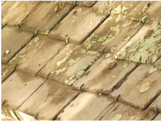
Afb. §33.15, openstaande rvs leihaken, bij dakvoet (na reparatie), koperen leihaken
