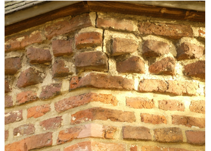
Afb. §22.02, detail scheurvorming muurkroon
