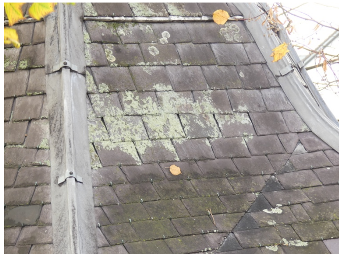
Afb. §33.03, dun versleten, gebroken en scheefgezakte leien, koperen leihaken
