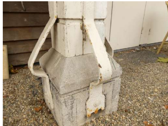
Afb. §24.10, roestvorming op de stijlankers
