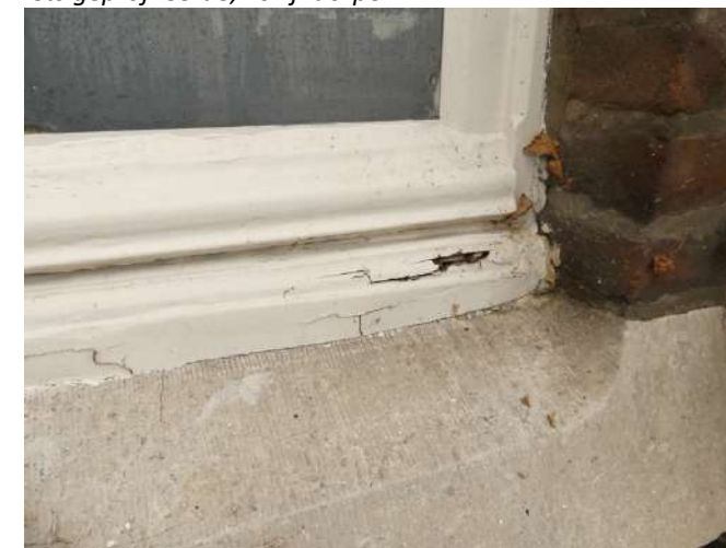
Afb. §30.22, aangetaste kozijndorpel
