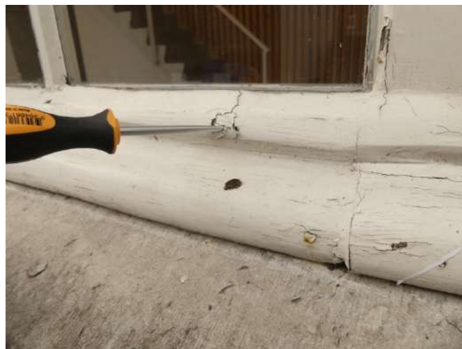
Afb. §30.16, aantastingen bij slecht dichtgezette stolpnaald
