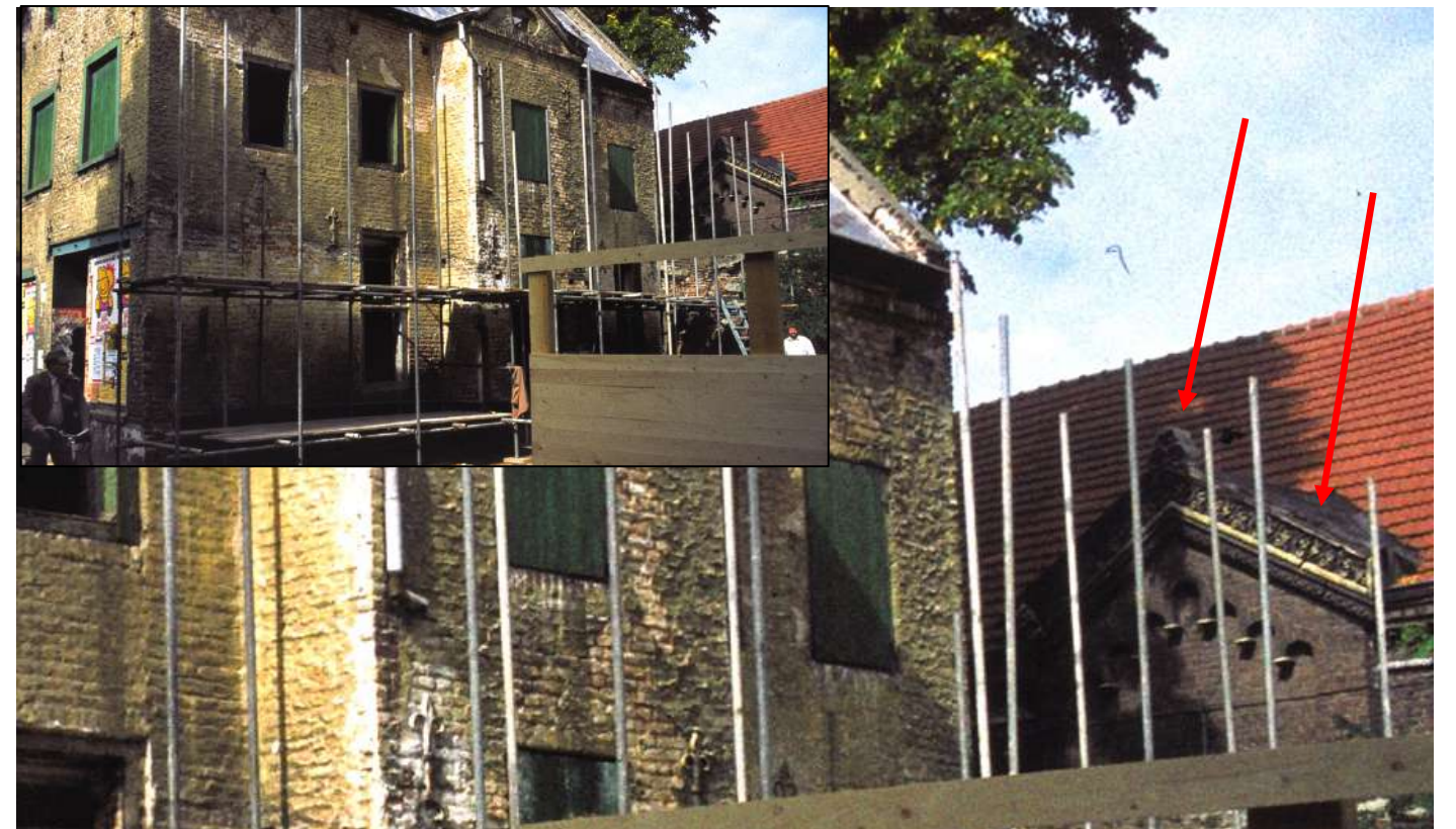
Afb. 23: Foto van 10-09-1976, ten tijde van de start van de restauratie van het Kapittelhuis (rechts op de insteekfoto) met rechts de kap van de vijfde as van de dwarsvleugel met afwijkende dakbedekking en een tuit op de frieslijst (RA Sittard-Geleen)
