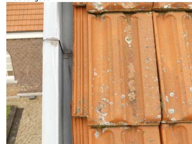
Afb. §33.41.18, te smalle, voor reiniging ontoegankelijke, 'goot' met
