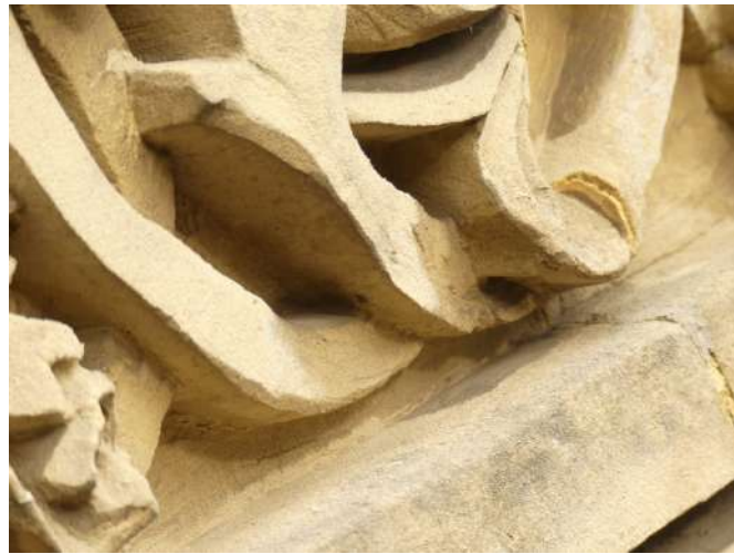
Afb. §35.08, detail zware slijtage, degraderend werk, gelige mortel harder dan mergel
