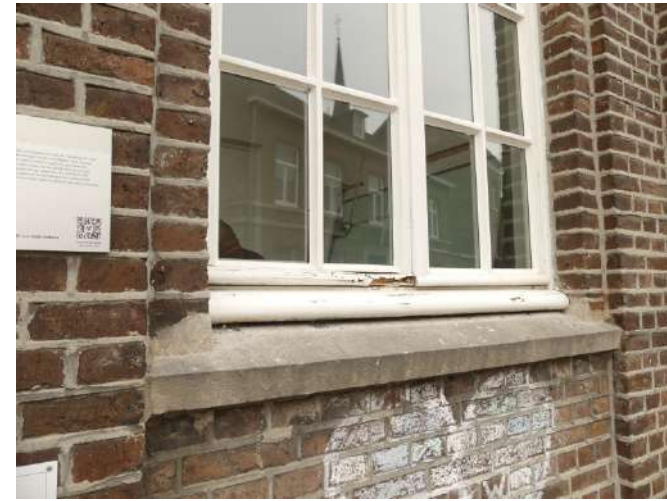
Afb. §30.07, kozijn voorgevel voormalige onderwijzerswoning
