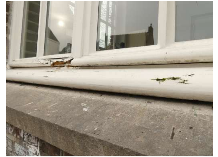
Afb. §30.08, aantastingen kozijn- en raamdorpels
