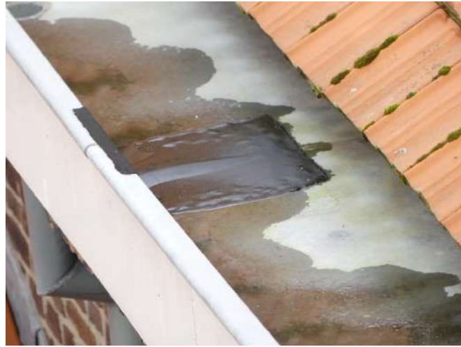
Afb. §33.87.18, (vermoedelijk) gescheurd zink door te lange lengtes zonder expansiemogelijkheid, noodreparatie discutabel: de blaas lijkt vocht aan te geven
