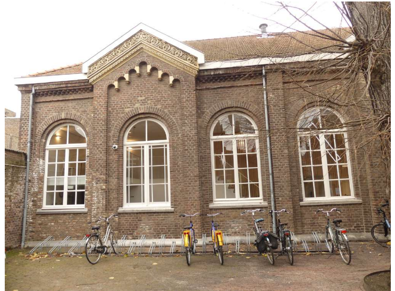
Afb. 8: oostgevel dwarsvleugel met hoger opgaande risaliet
