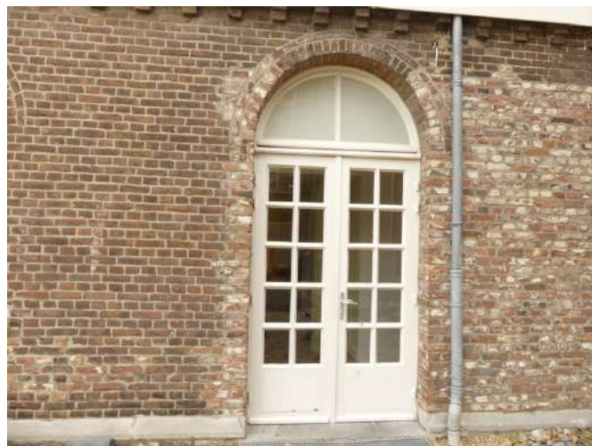
Afb §30.37, nieuwe deur in zuidgevel schoolvleugel
