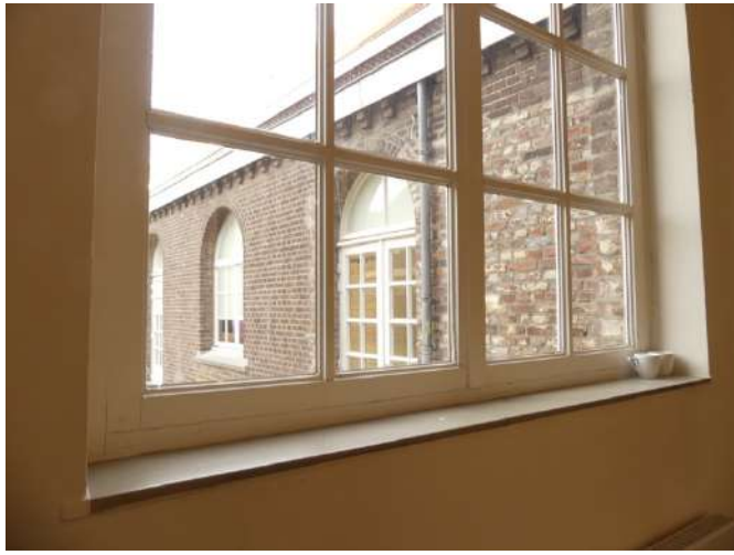
Afb. §30.25, kozijn in hal bij westelijke speelplaats
