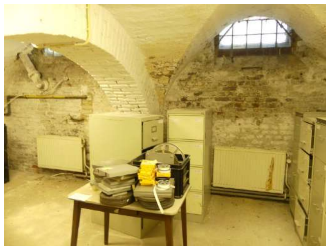
Afb. §22.25 overzicht souterrainruimte
