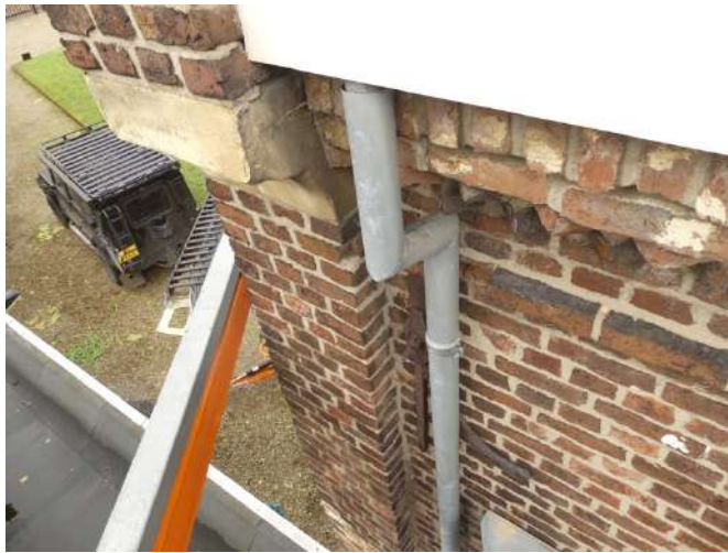
Afb. §33.87.19, haakse bochten in hwa, gevoelig voor verstopping
