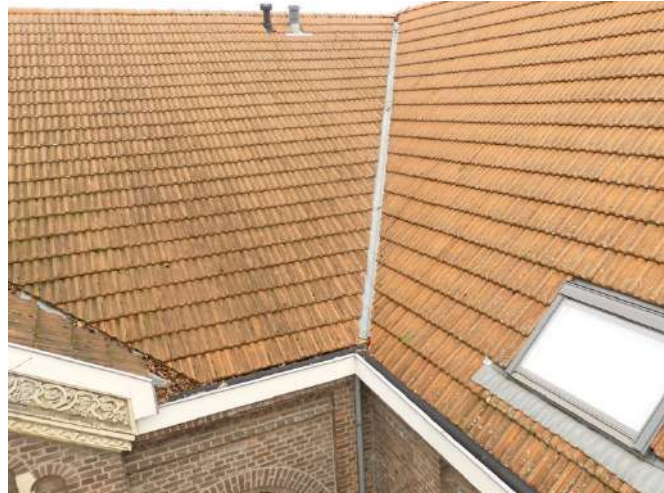
Afb. §33.41.10, twee dakdelen met verschillende panlagen, mogelijk ook dakhellingen, kniklijn dakgoot klopt niet met lijn kilgoot en inwendige hoek gevels
