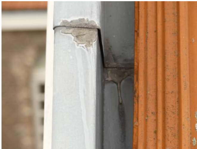
Afb. §33.87.21, openstaande naad, nooit gesoldeerd geweest
