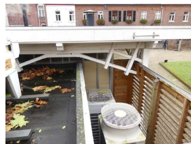
Afb. §24.06, overzicht overkapping speelplaats
