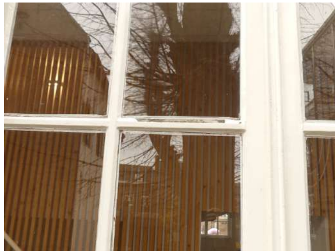
Afb. §34.25.04, verdroogde, uitgevallen en loszittende stopverf
