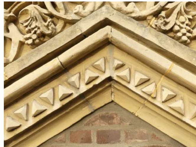
Afb. §35.03, verschillende kleuren (en types?) voegmortel en verschillende breedtes voegen
