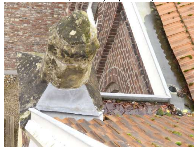
Afb. §33.87.15, afdeklood discutabel aangebracht
