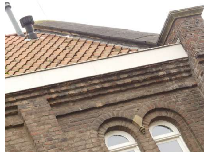
Afb. §33.87.03, voorzijde scheimuur onderwijzerswoning-schoolvleugel
