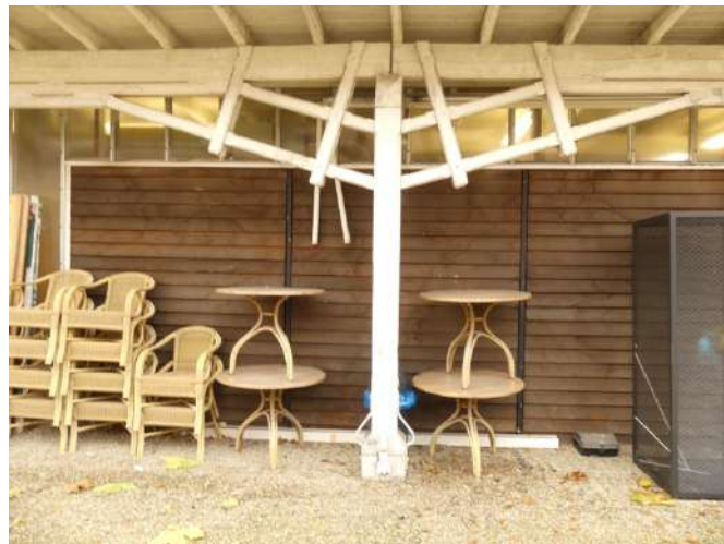
Afb. §24.09, stijl met open verbinding tussen draagbalken
