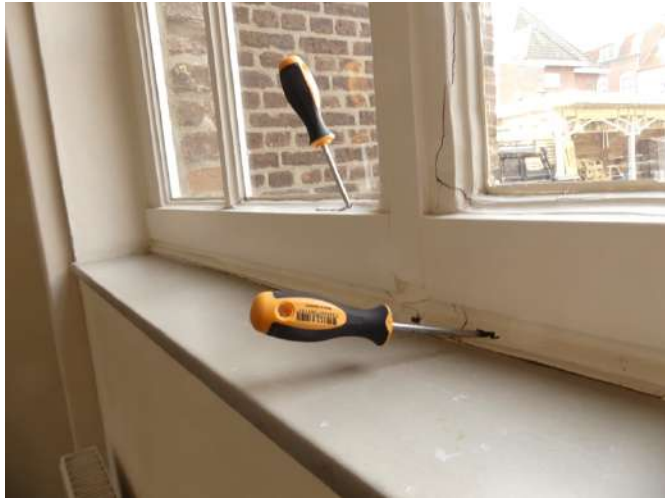
Afb. §30.27, aantastingen en deformatie (overgeschilderd?)
