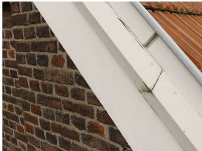
Afb. §46.21.12, vervuiling open stuiknaden lijstwerk achter-gevel
