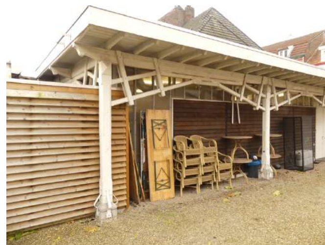
Afb. §24.05, overzicht overkapping speelplaats
