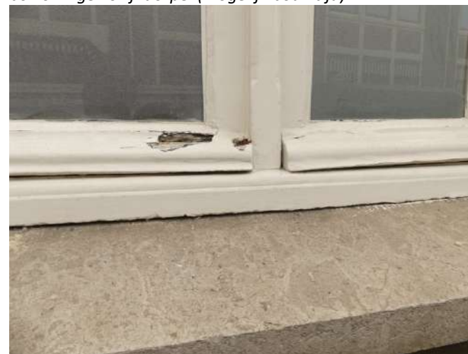
Afb. §30.21, aangetaste raamdorpel en stopverf
