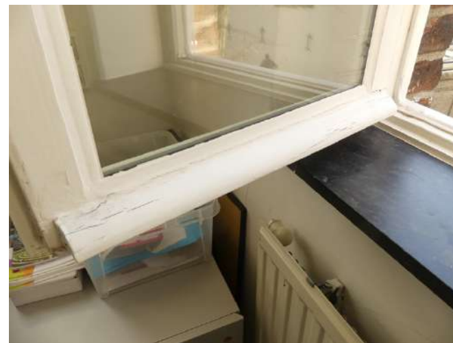
Afb. §30.23, windscheuren in raamdorpel en aantasting in stijl
