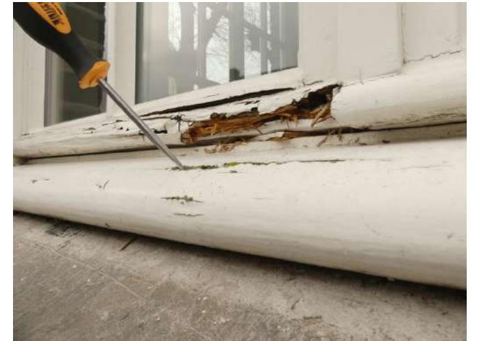
Afb. §30.10, opmerkelijk strakke glaslat, let op de bolvormige onderdorpel (mogelijk bouwtijd)
