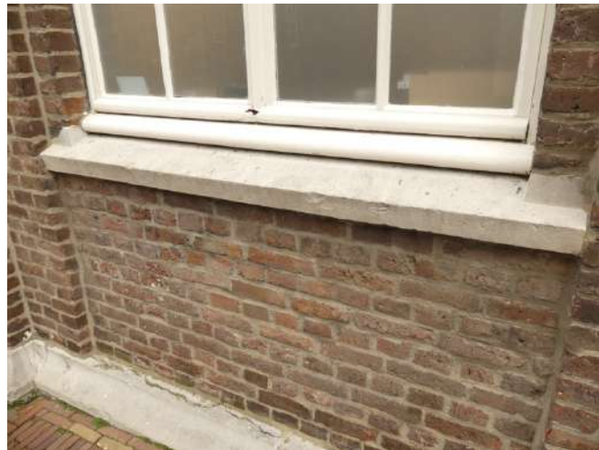
Afb. §30.05, kozijn oostelijke speelplaats
