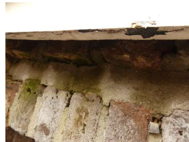
Afb §24.02, aangetaste boeiboord
