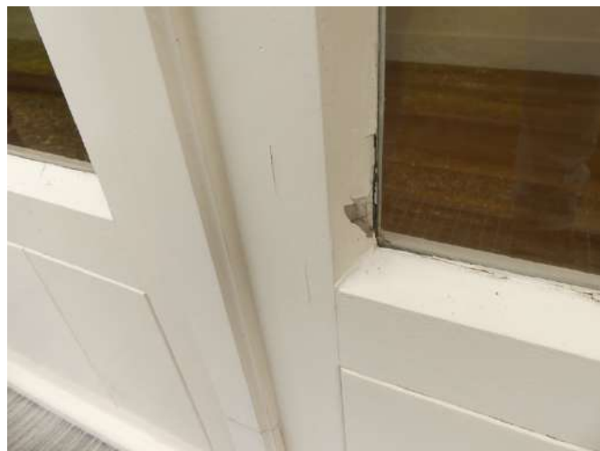
Afb. §34.25.06, verdroogde, uitgevallen en loszittende stopverf
