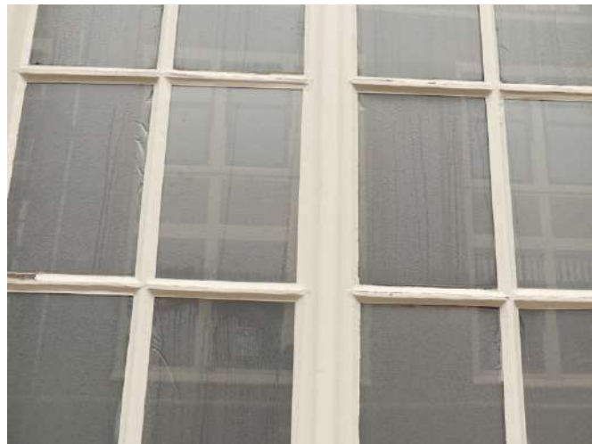
Afb. §34.25.03, verdroogde, uitgevallen en loszittende stopverf
