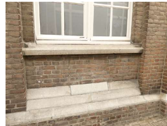
Afb. §30.20, raamkozijn straatgevel schoolvleugel met rechte, iets geprofileerde, kozijndorpel
