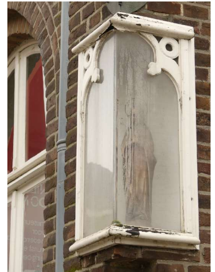
Afb. §24.12, verrot lijstwerk en onvoldoende ventilatie, beeld niet waar te nemen
