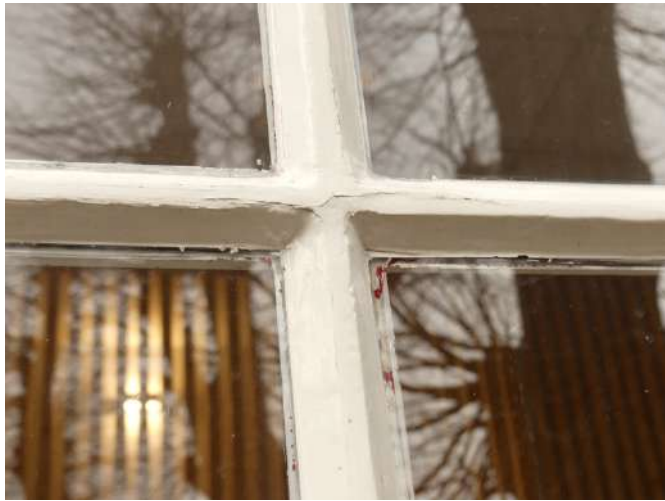
Afb. $46.21.21, barsten in verf, aan binnenzijde te ver op het glas geschilder
