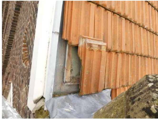
Afb. §33.41.20, kapotte dakpan uitgewisseld met gave dakpan en lekkagerisico verkleind
