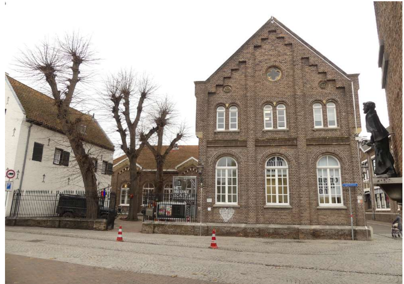
Afb. 4: oostgevel onderwijzerswoning, hekwerk met oostelijke binnenplaats
