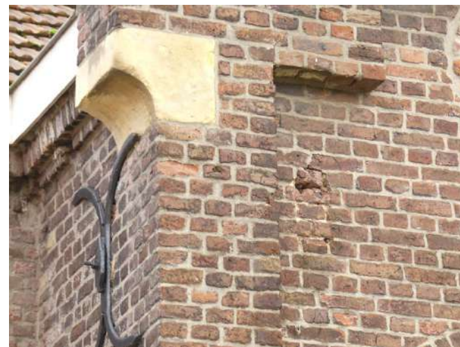
Afb. §22.17 losgescheurde aanzetsteen schouderstuk, kapotte steen
