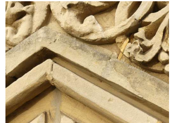
Afb. §35.04, in één voeg verschillende kleuren mortel, gelige mortel lijkt harder dan omliggende mergel
