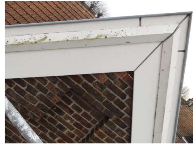
Afb. §46.21.13, vervuiling te schrale verf op lijstwerk
