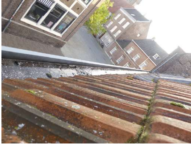
Afb. §33.87.17, bakgoot niet op afschot
