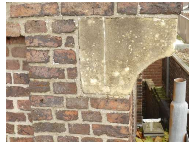
Afb. §22.18 losgescheurde aanzetsteen schouderstuk
