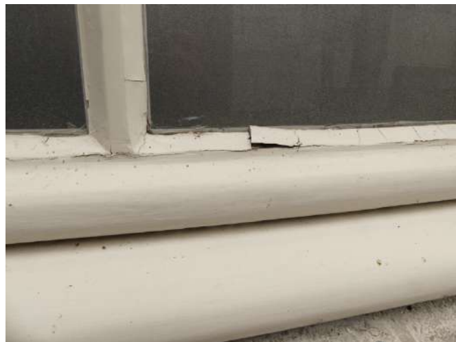
Afb. §34.25.05, verdroogde, uitgevallen en loszittende stopverf
