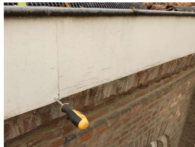
Afb. §24.01, aangetast hout bij haakse verbindingen boeiboord, uit multiplex
