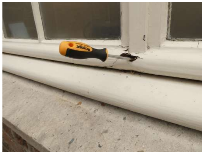
Afb. §30.06, aangetaste dichtgezette stolpnaald
