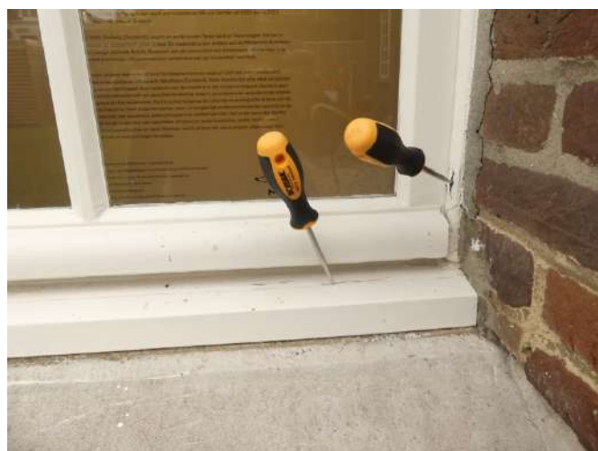
Afb §30.41, aantasting in (te rechte) kozijndorpel en -stijl
