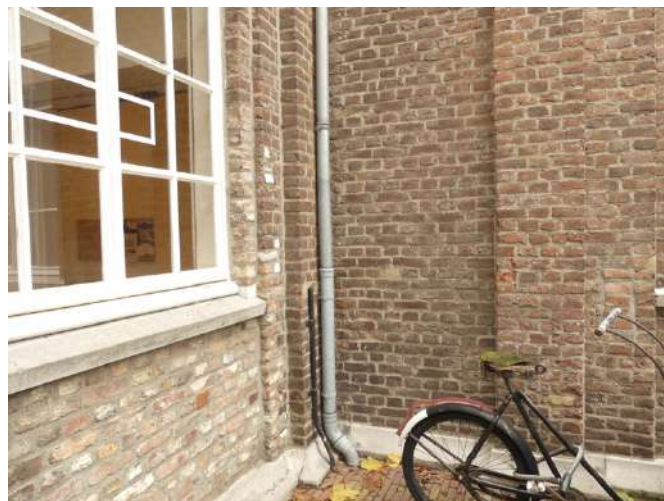
Afb. §30.14, situatie naast entreesluis
