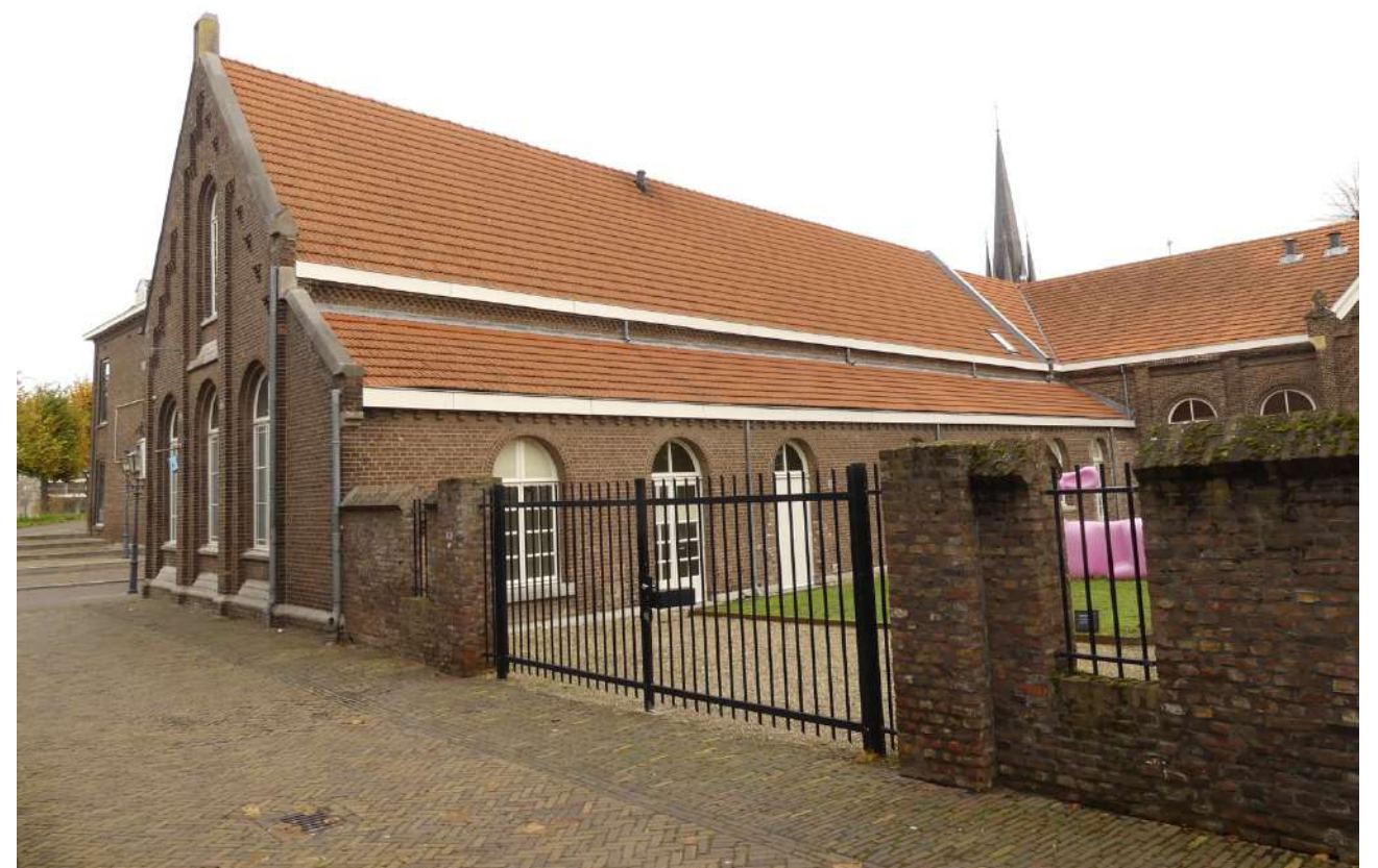
Afb. 13: westelijke tuitgevel, tuinmuur met (moderne) poort
