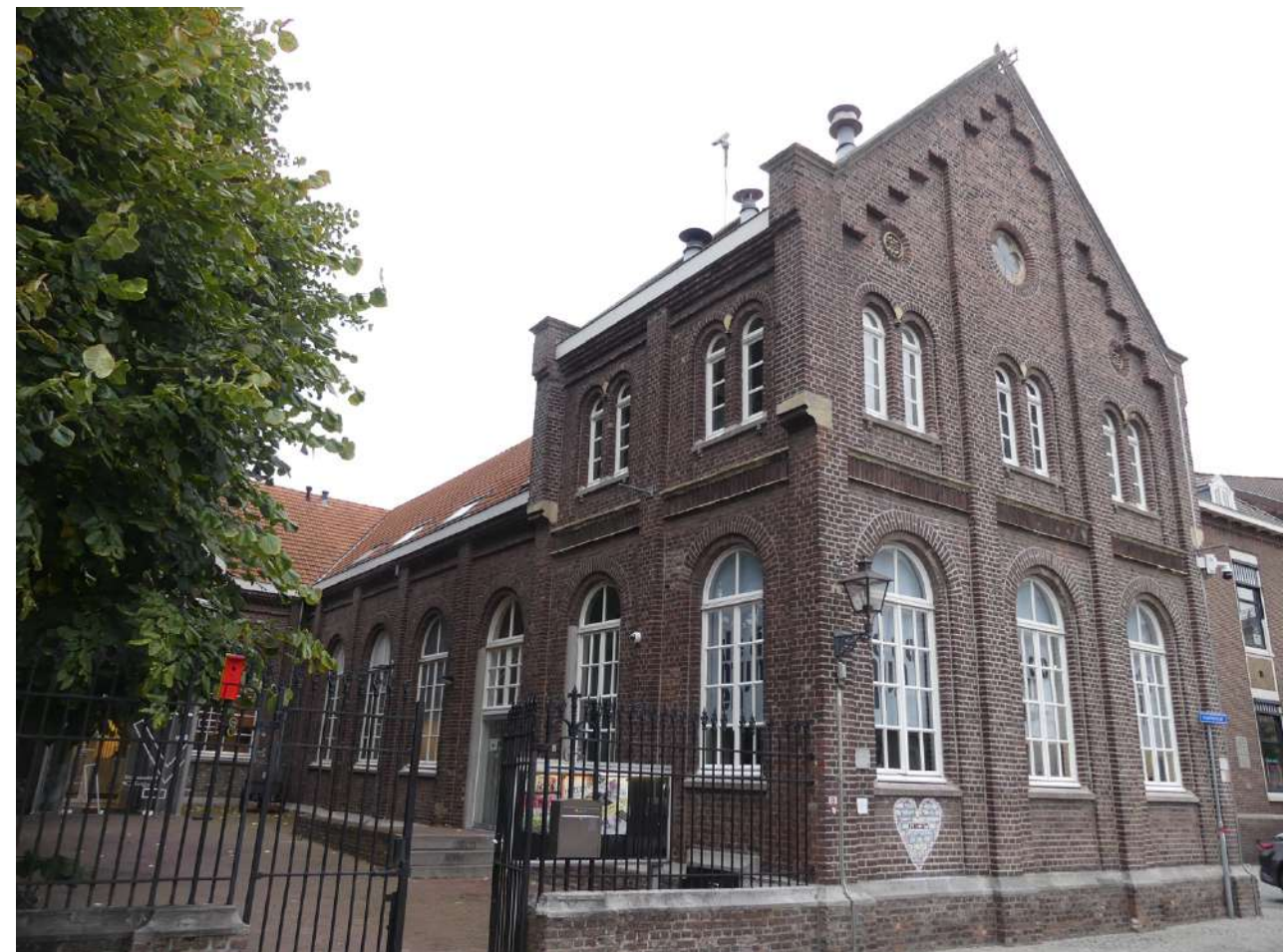
Afb. 5: oost- en zuidgevel onderwijzerswoning en schoolvleugel
