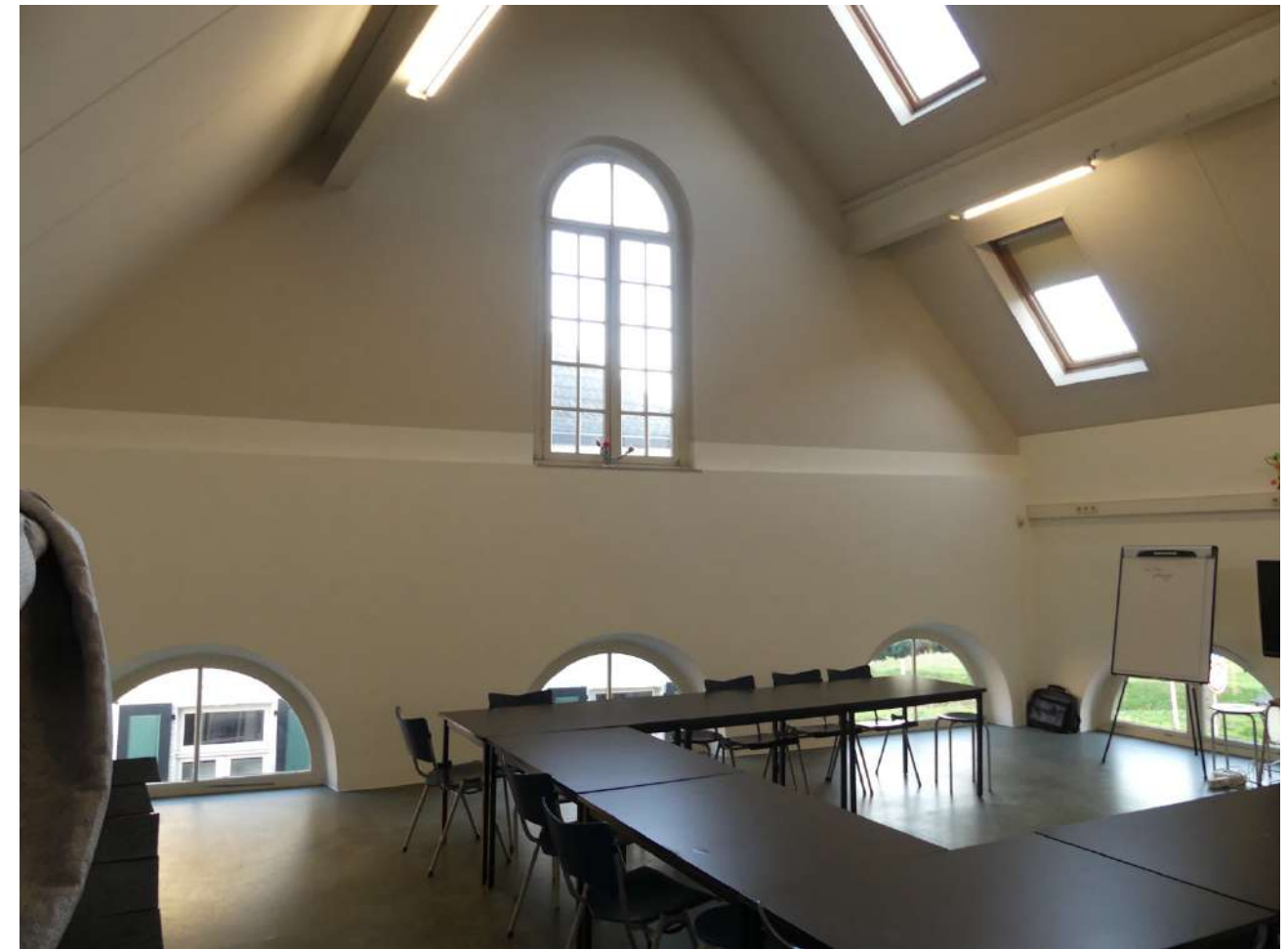
Afb. 20: interieurzijde westgevel NB: stalen gordingen
