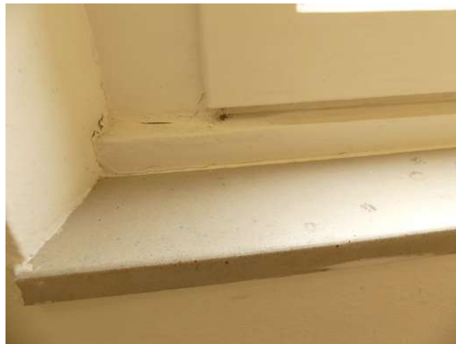
Afb. §46.21.34, loskrimpde verf aan binnenzijde
