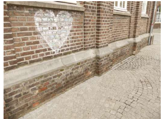
Afb. §35.40, brandlagen, scheuren en een steek
