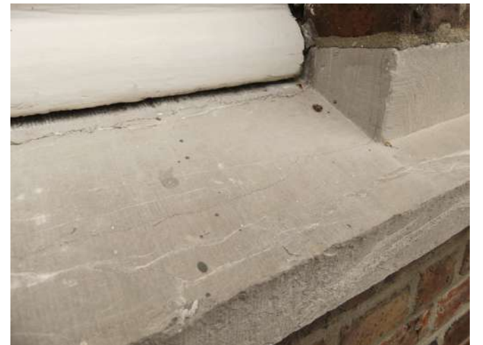
Afb. §35.50, brandlagen en (bijna verdwenen) versleten frijnslag op watervlak
