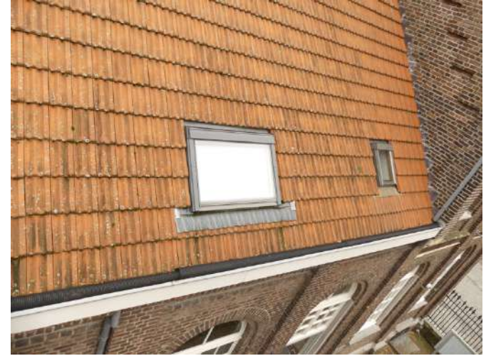
Afb. §33.87.24, moderne dakvensters op dak oostelijke speelplaats met verschillende detaillering
