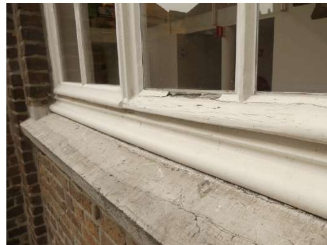
Afb. §35.51, brandlagen en (bijna verdwenen) frijnslag op watervlak
