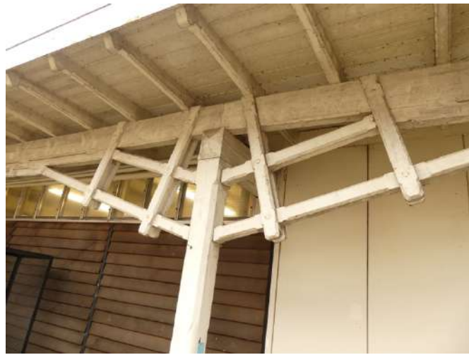
Afb. §24.07, stijl met draagbalken en schoren
