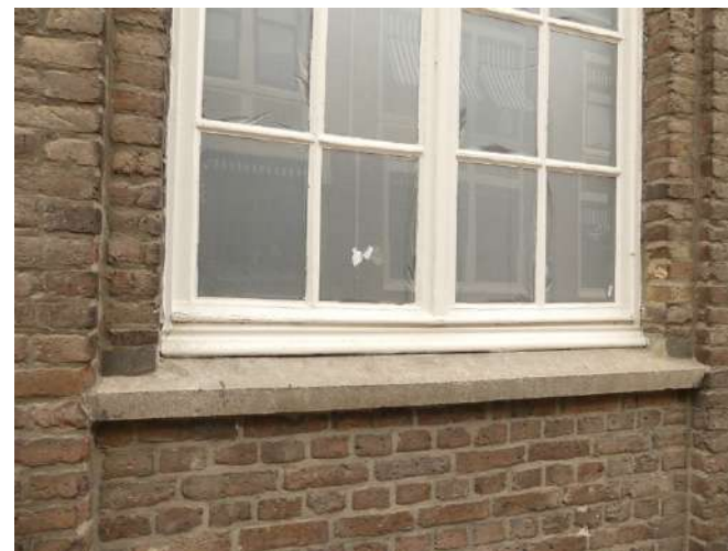
Afb. §30.19, raamkozijn straatgevel schoolvleugel met dunnere bolvormige kozijndorpel (mogelijk bouwtijd)
