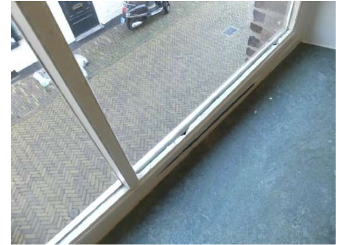
Afb. §30.34, aantasting in glaslat en slecht kitwerk
