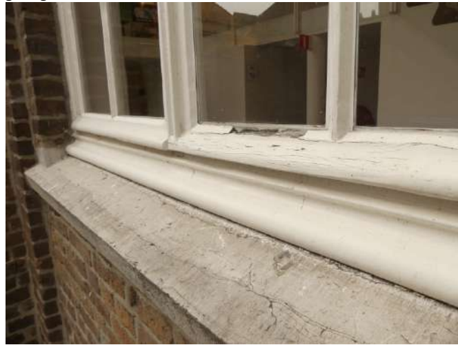
Afb. $46.21.22, barsten in verf op onder- en raamdorpel
