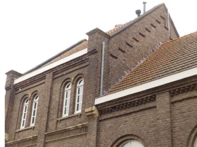
Afb. §33.87.05, achterzijde scheimuur onderwijzerswoning-school-aangedreven muurlood, geen vleugel
