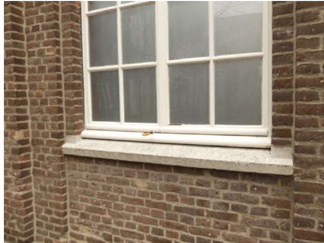
Afb. §34.25.01, verdroogde, uitgevallen en loszittende stopverf
