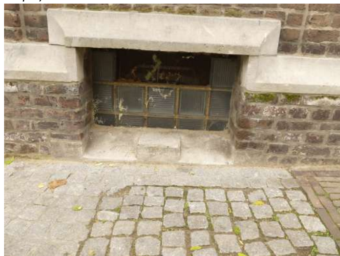
Afb. §35.46, verdwenen middenstijl bij souterrainvenster
