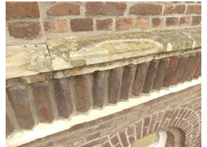
Afb. §35.18, opvallende reparaties waterlijst, alg-vervuiling op lijst
