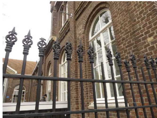
Afb. §43.10, ontbrekende hekwerkpunten en kop
