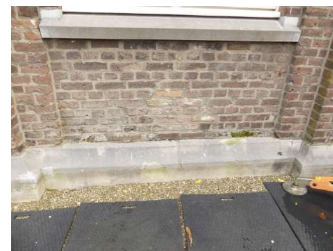
Afb. §22.20 open voegen boven plintlijst, mosgroei
