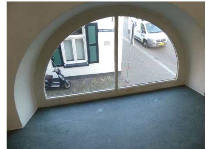
Afb. §30.36, slechte stopverf en mogelijk aantasting in kalf
