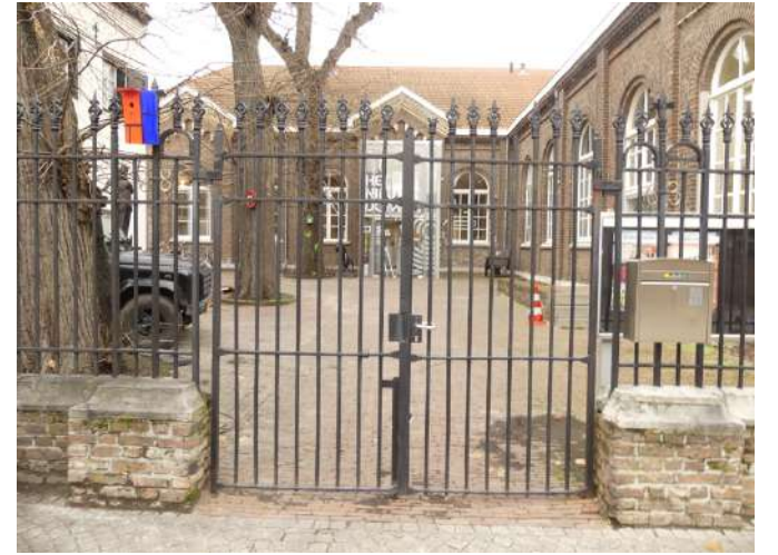
Afb. §43.02, poorten in gesloten toestand, midden- en boven-regel ongelijk
