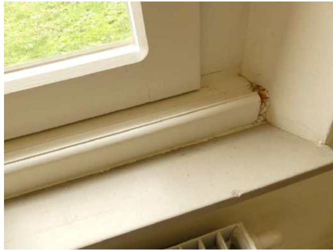
Afb. §30.30, slecht passend detail, met PUR-schuim geprobeerd 'op te lossen'
