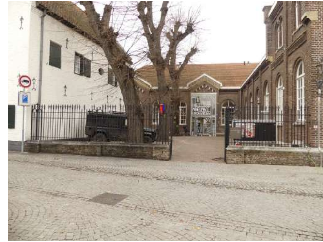
Afb. §43.01, overzicht smeedijzeren hekwerk oostelijke binnen-plaats
