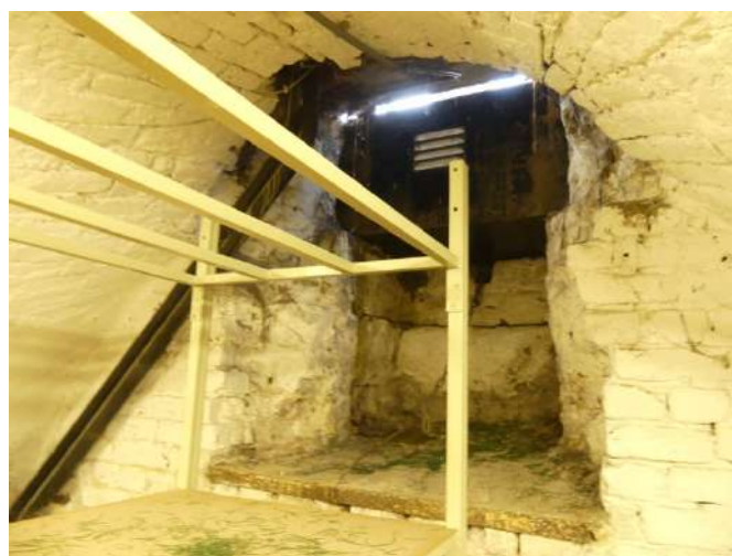
Afb. §22.28 gescheurd koekoekswerk en bijzondere leiding
