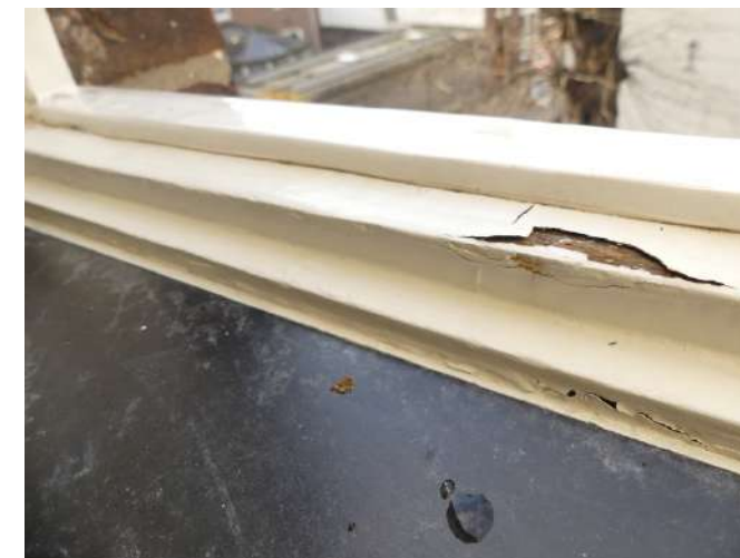
Afb. §30.24, aantasting in kozijndorpel en net boven venster- bank
