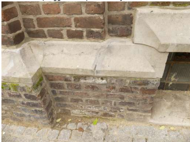
Afb. §35.45, brandlaag en steek (met reparatiesporen)
