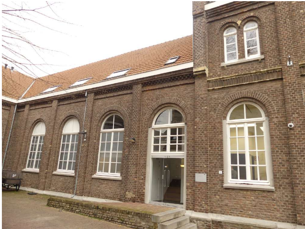
Afb. 6: zuidgevel schoolvleugel aan oostelijke binnenplaats
