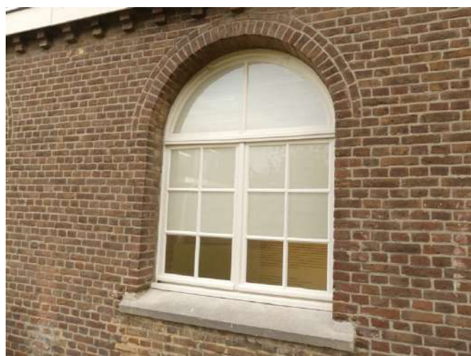
Afb. §30.39, hersteld raamkozijn in zuidgevel schoolvleugel
