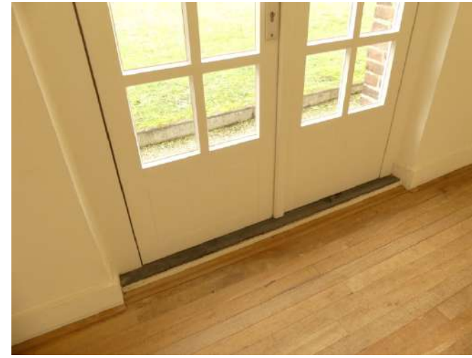
Afb. §30.31, nieuwe deur in oude speelplaatsgang
