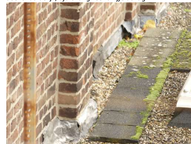
Afb. §33.87.16, opgewaaid, gescheurd en versleten muurlood
