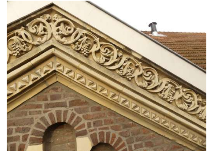
Afb. §35.02, versleten frieslijst, detaillering nog waarneembaar
