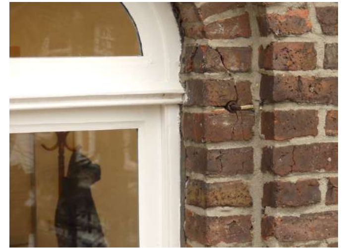
Afb. §22.06 kapotgedrukte stenen door roestend ijzer
