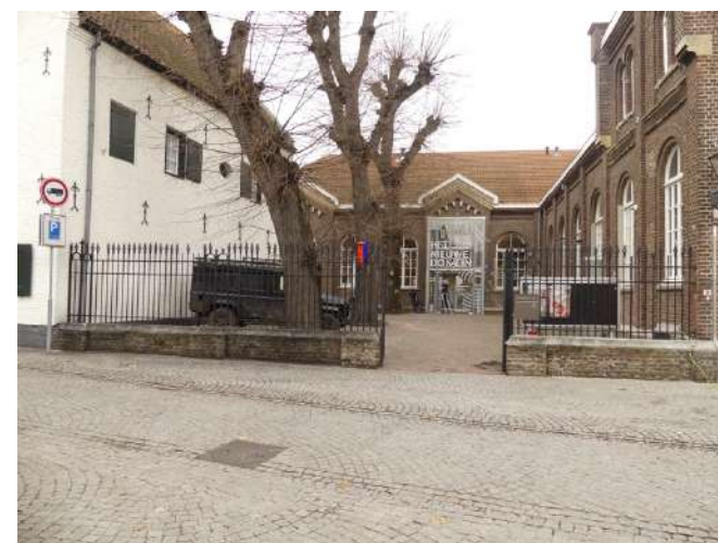
Afb. §35.23, overzicht muurafdekken oostelijke binnenplaats
