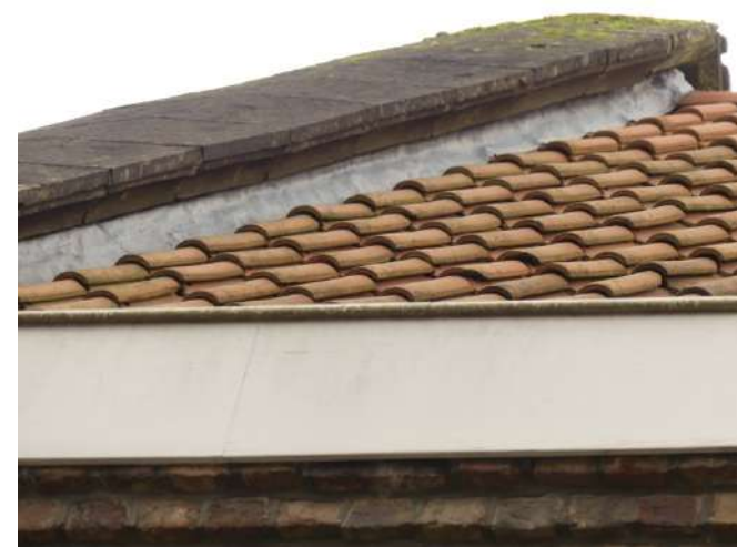
Afb. §33.87.01, achterzijde gevelafdek voorgevel onderwijzerswoning
