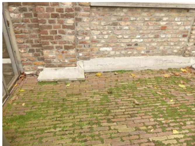
Afb. §35.33, brandlagen in waterlijst in gevel binnenplaats
