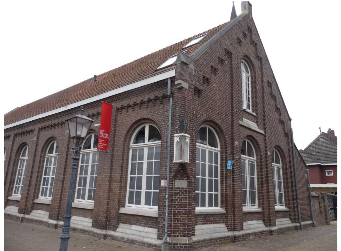
Afb. 12: achterste deel noordgevel en westelijke tuitgevel
