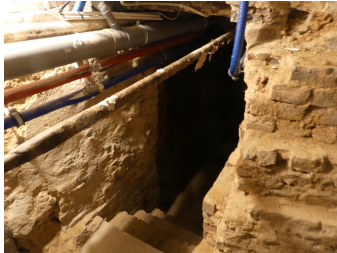
Afb. §89.02, trap naar kelder langs leidingwerk
