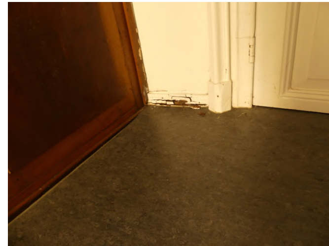
Afb. $45.01, door bruinrot aangetaste plint
