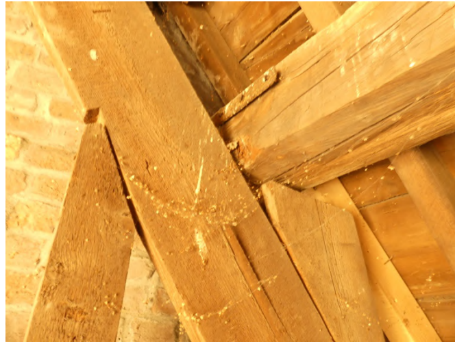
Afb §24.02 diverse losse en openstaande verbindingen
