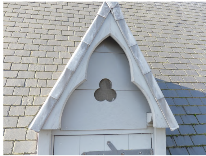
Afb. §46.21.08, overstek dakkapel met geprofileerde lijst
