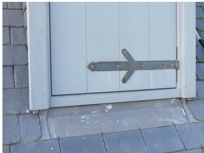
Afb. §30.20, onderzijde dakkapel, roestende schroeven op erg dun geheng
