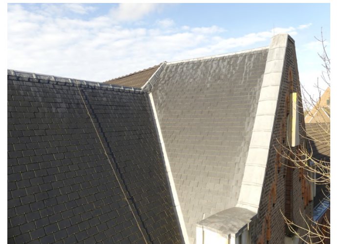
Afb. §33.02, overzicht loodbekleding op topgevel
