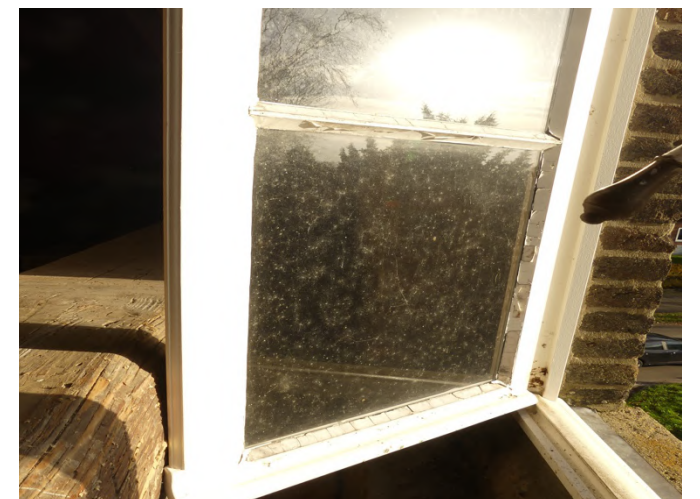
Afb. §34.06, van stopverf afbladderende verf
