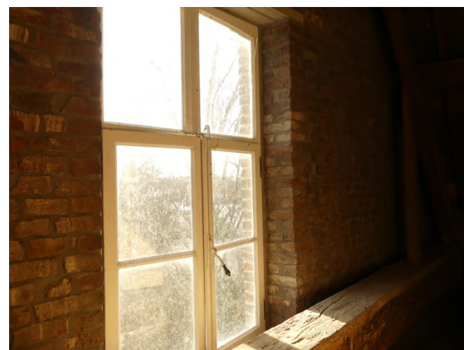
Afb. §30.17, openstaande, kromgetrokken tongnaald, daardoor tocht en mogelijke indringing (slag-)regen
