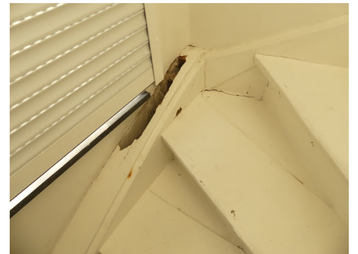
Afb. $45.04, door bruinrot aangetaste aftimmerlat
