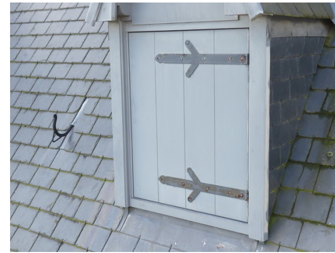
Afb. §46.21.13, aanzicht dakkapel, vale verf
