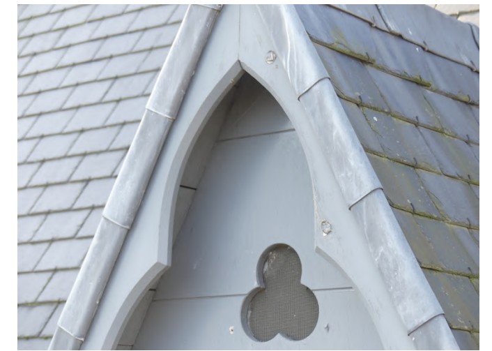
Afb. §46.21.14, noesten tekenen af, vochtintreding kan zorgen voor aantasting
