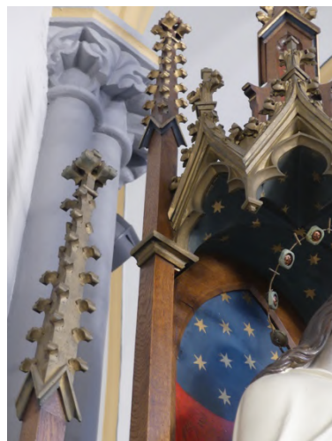
Afb. §45.07, afgebroken hogels
