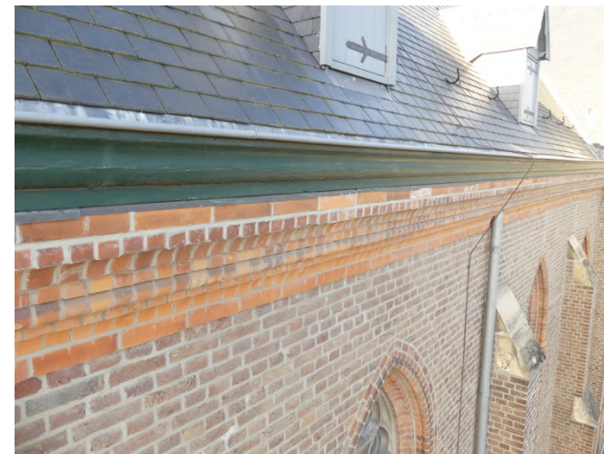
Afb. §46.21.01, overzicht geprofileerde bakgoot oostgevel
