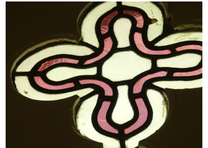
Afb. §34.04, gescheurd gekleurd figuurrutje
