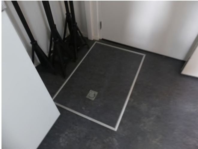
Afb. §89.01, luik naar kelder, lastig in te klimmen
