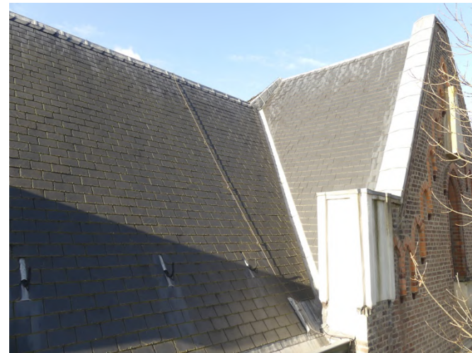
Afb. §33.01, overzicht oostdak met kilkeper
