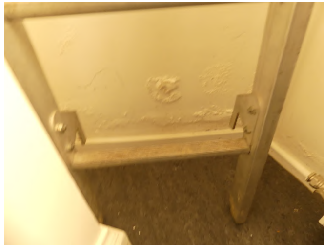
Afb. $40.06, optrekkend vocht net boven vloerniveau
