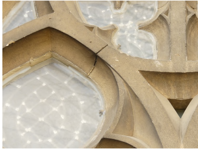
Afb. §35.02, uitgespoeld voegwerk tracering
