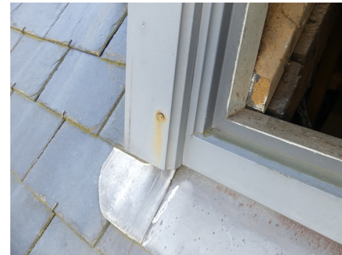
Afb. §46.21.15, noesten tekenen af, vochtintreding kan zorgt hier voor vochtintreding en uiteindelijk aantasting
