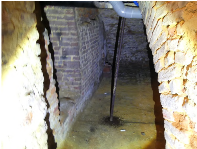
Afb. §89.03, overzicht vanaf trap
