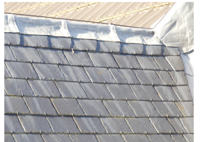
Afb. §33.04, te smalle leien toegepast naast de kil
