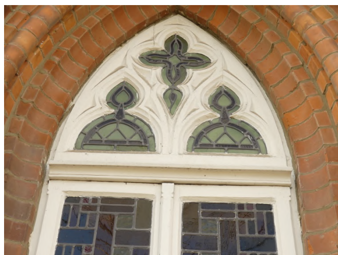
Afb. §30.09, houten tracering, bovendorpels zijn gelijk
