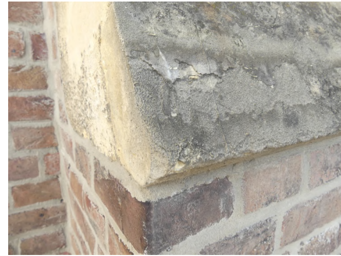
Afb. §35.07, scheurtjes in een afzaat
