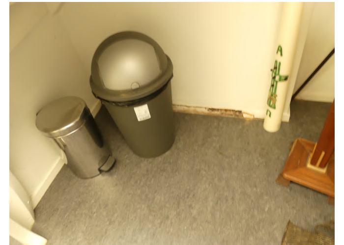
Afb. $45.02, door bruinrot aangetaste plint
