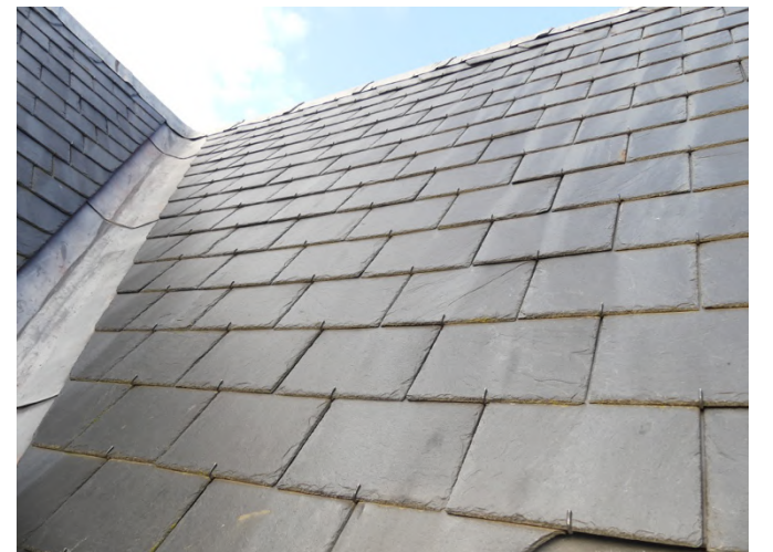
Afb. §33.06, gebroken lei, onderaan op de foto
