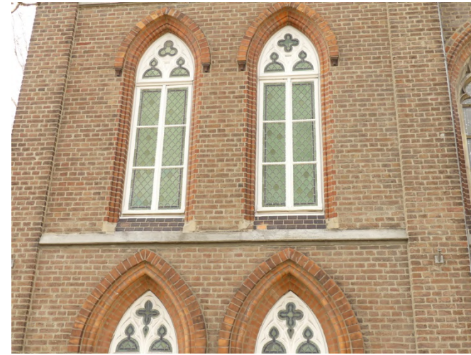
Afb. §22.05 overzicht linkerdeel oostgevel
