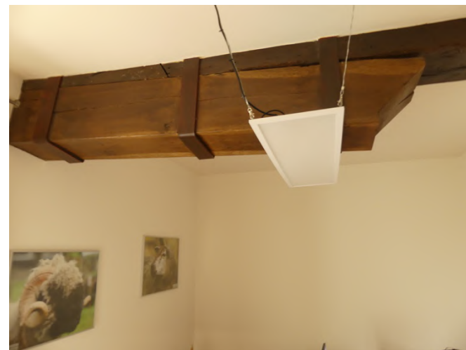
Afb. §24.05, open verbinding tussen sleutelstuk en balk
