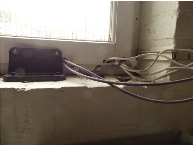
Afb. §89.02, kabels door raam- en kozijnhout geboord en gevoerd
