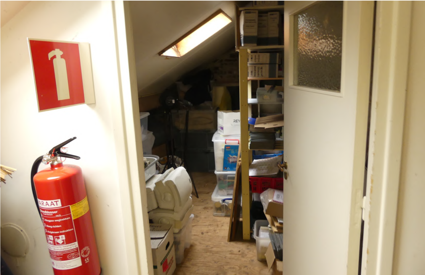
Afb.13: kleine bergruimte op tussenzolder onder westelijke lessenaarsdak
