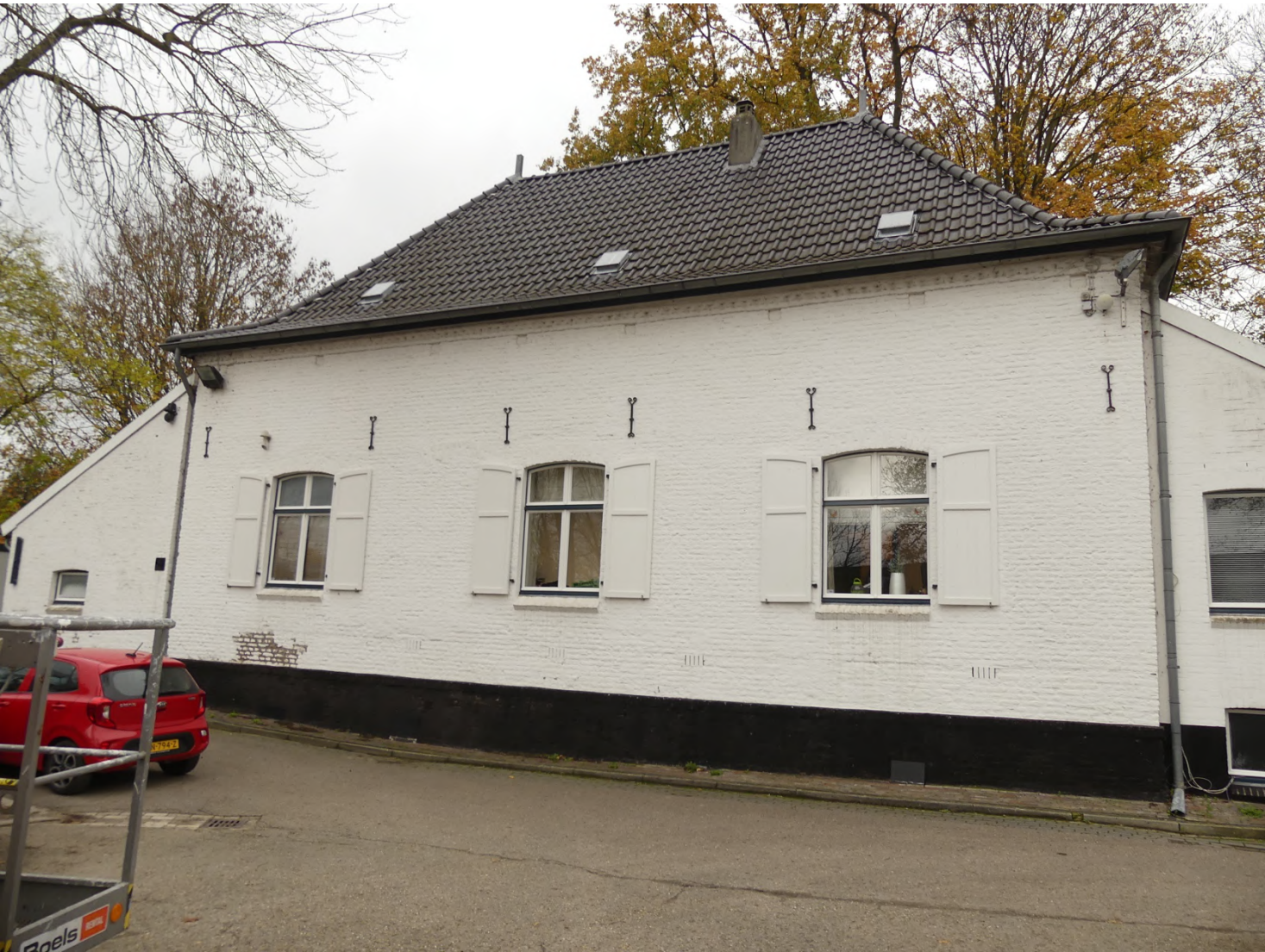
Afb. 02: zuidgevel van de tuinmanswoning
