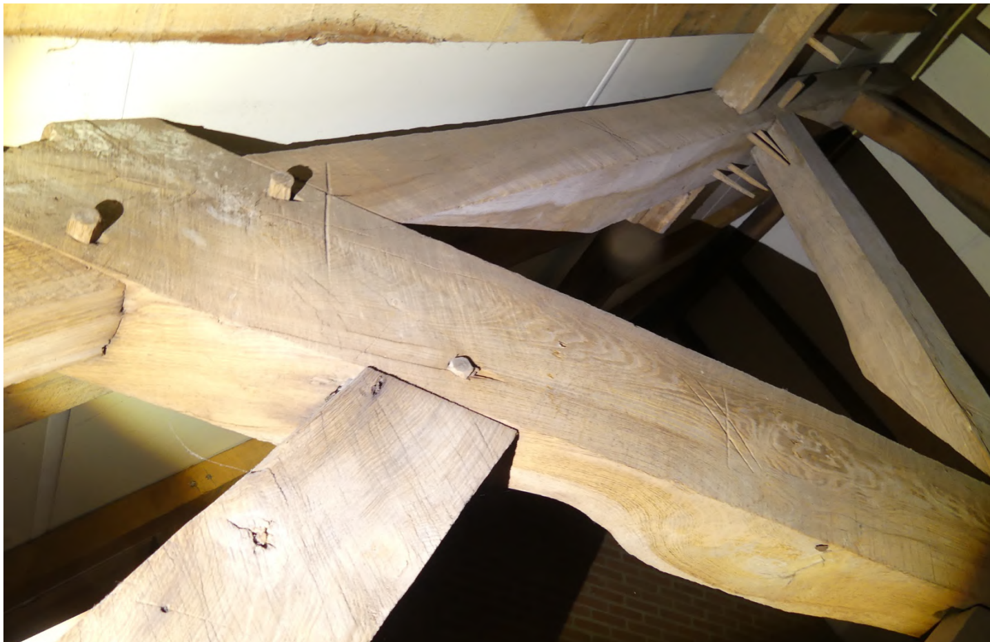
Afb.16: oude kapconstructie westelijke zolder met sporen en nieuwe dakplaten
