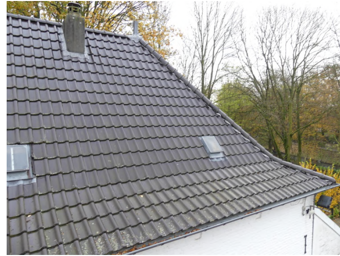
Afb. §33.01, overzicht oostelijke hoekkeper zuidoak en dakramen
