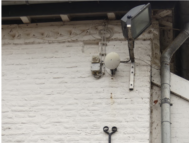
Afb. §89.01, veel onbeschermdde kabels aan exterieur
