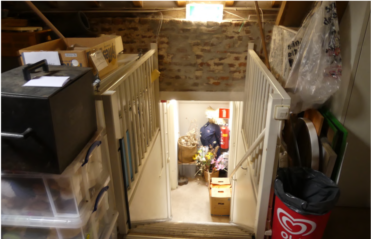
Afb.14: trap van westelijke zolder naar de tussenzolder
