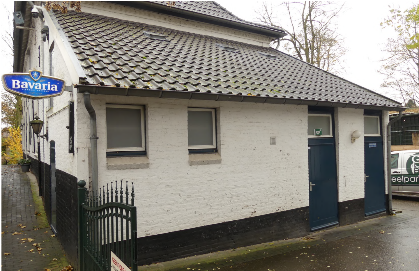
Afb.09: westgevel met toegangsdeuren voor het westelijk deel van de begane grond en de westelijke zolder
