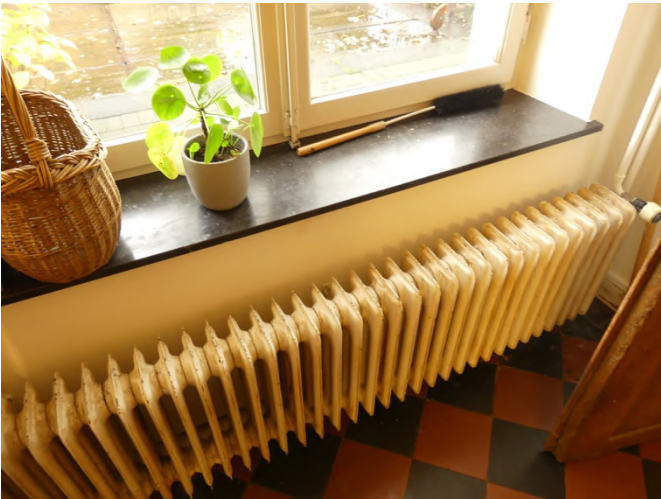
Afb. §89.04, radiator tegen steens muur, geen isolatie of folie
