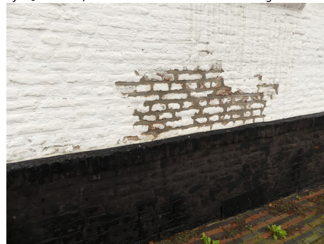
Afb. §46.22.05, afgedrukt sauswerk, vermoedelijk dampdicht
