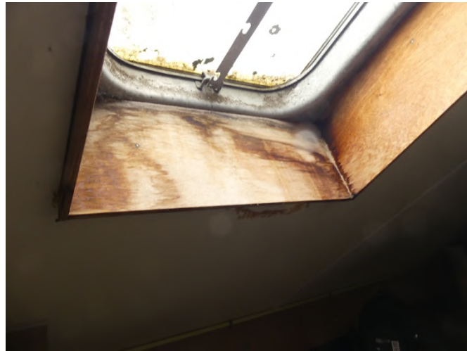
Afb. §30.04, doorslaande dakramen
