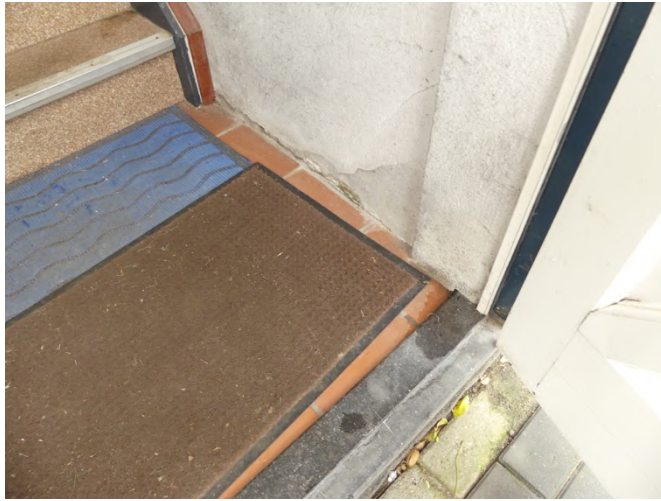
Afb. §30.01, regen doorlatende deur/kozijnsluiting
