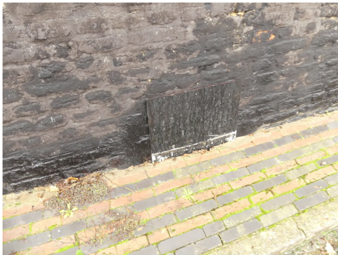
Afb. §46.22.07, afgedrukt sauswerk, vermoedelijk dampdicht
