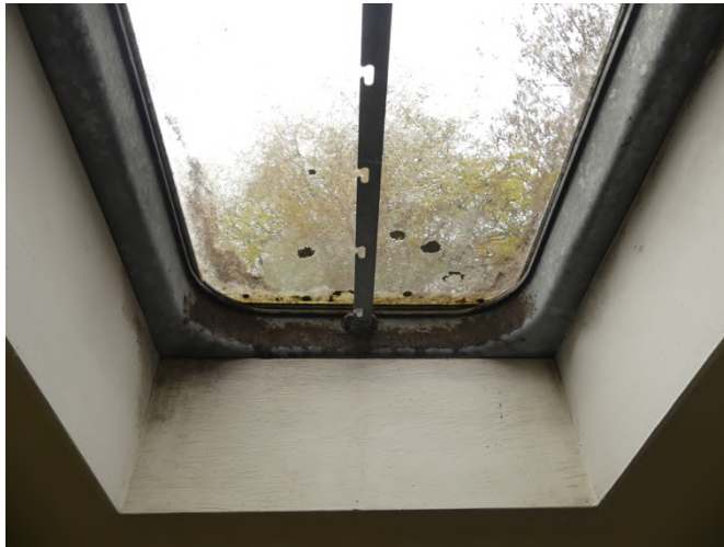
Afb. §30.03, doorslaande dakramen
