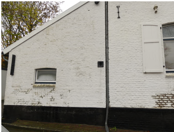
Afb. §22.01, overzicht zuidelijk deel oostgevel
