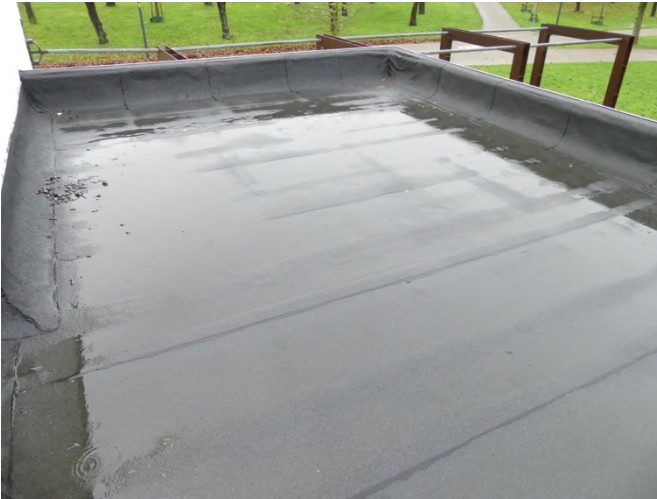
Afb. §33.01, overzicht richting Vijverweg
