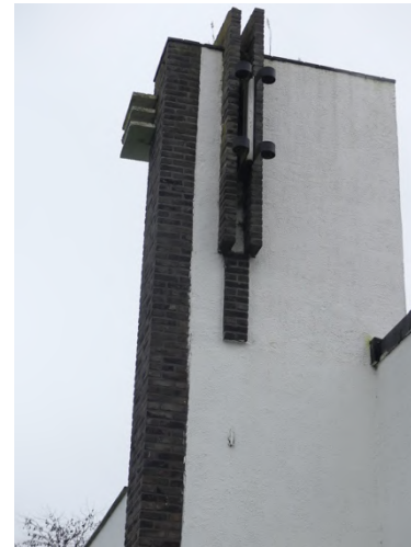
Afb. §22.13, begroeiing op afdekken toren
