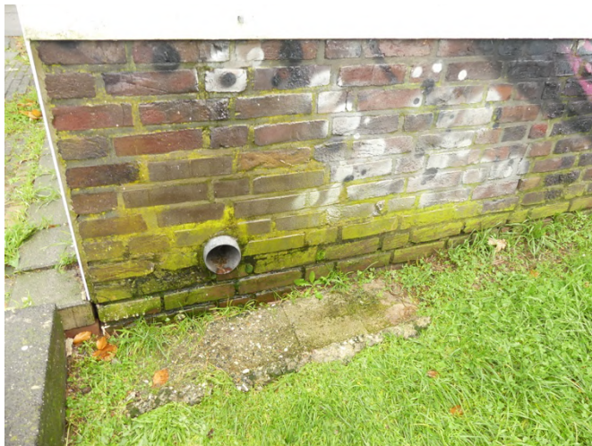
Afb. §52.03, zware alggroei door opspattend regenwater uit uitloop
