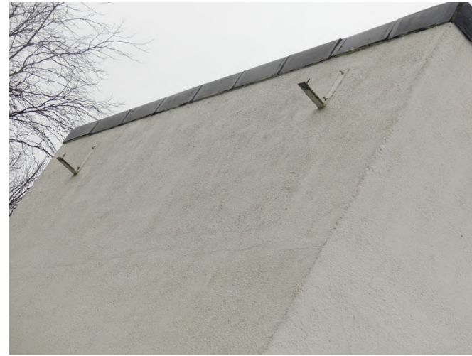
Afb. §40.19, te opgezet pleisterwerk, smeedijzeren element volledig opgenomen in pleisterlaag
