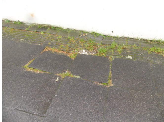
Afb. §15.02, begroeid, verzakkend tegelwerk
