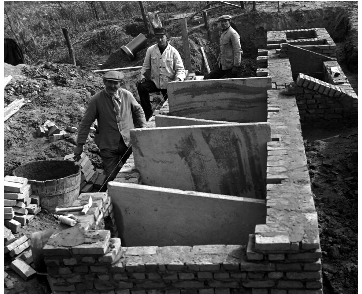
Afb. 16: aanleg van het zwembad, funderingswerk, 1932-1933 (Gemeente Sittard, Glasplatencollectie)
