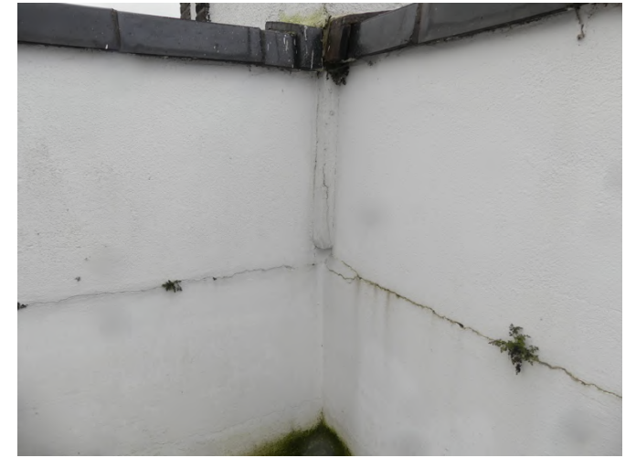
Afb. §40.20, horizontale en verticale scheur met begroeiing
