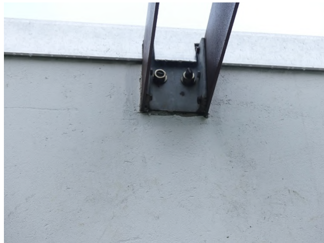
Afb. §43.04, in pleisterwerk gespaarde console, RVS moeren
