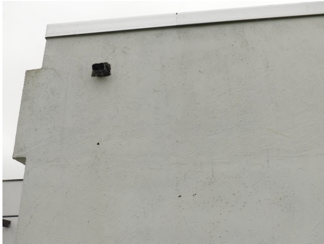
Afb. §40.01, doorvoer uitloop plat dak
