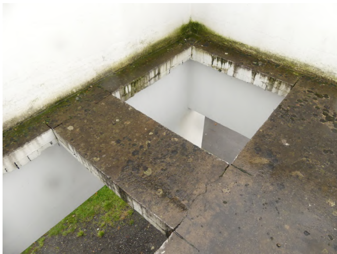
Afb. §21.05, zaagsnedes en scheurvorming, ontbrekende rand-beveiliging
