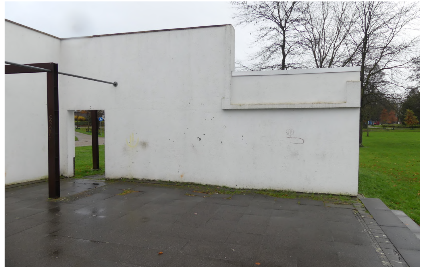
Afb. 10: 'binnen-gevel' linkervolume voormalige zwembad
