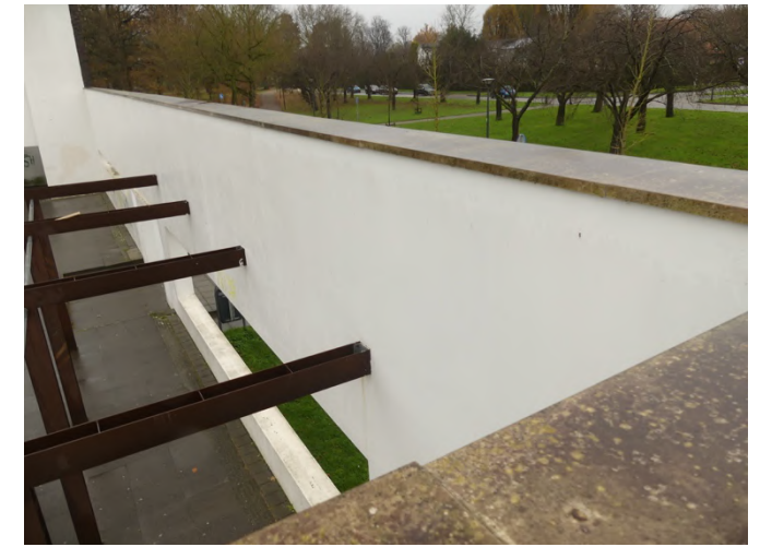
Afb. §35.02, overzicht natuursteen afdekken, onregelmatig gelegd
