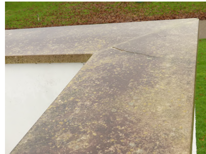
Afb. §35.05, gebroken hoekstuk
