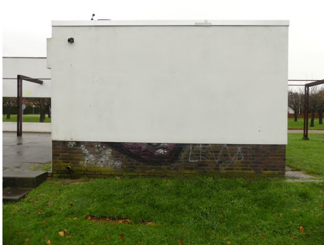
Afb. §52.01, uitloop platte dak
