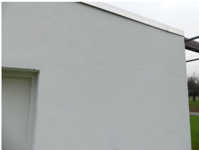
Afb. §40.05, onregelmatig afgewerkte horizontale oneffenheid, mogelijk aftekening van een scheur in het metselwerk
