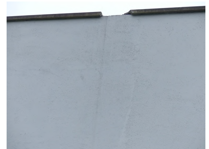
Afb. §35.06, afgebroken stuk natuursteen op langsmuur
