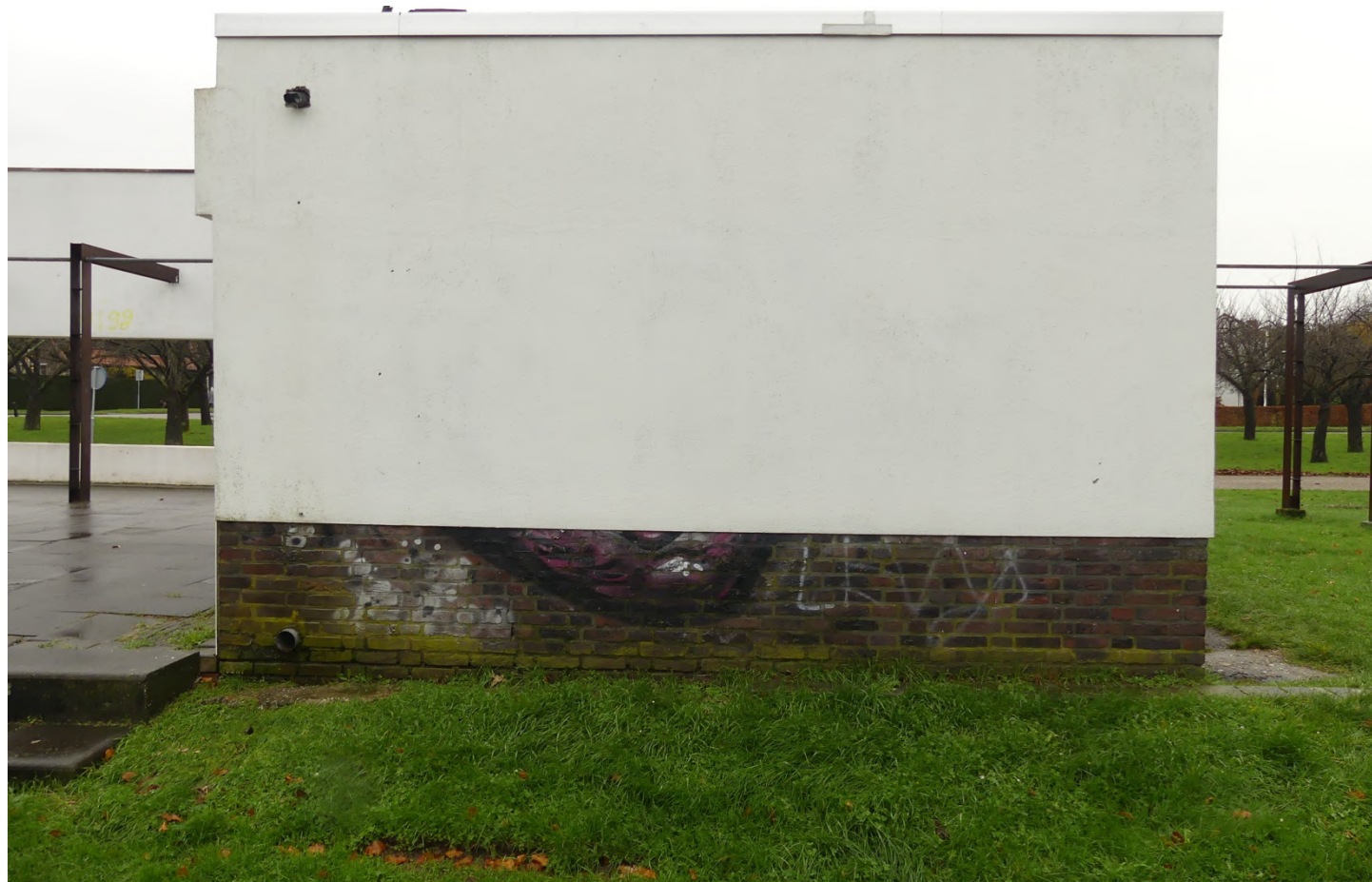
Afb. 09: achtergevel linkervolume voormalige zwembad
