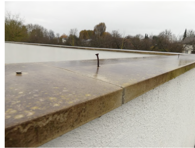
Afb. §35.03, uitkomende schroeven (vanaf bovenzijde aangebracht!)
