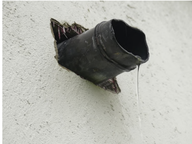
Afb. §52.02, watervoerende uitloop platte dak
