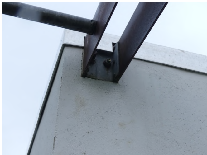
Afb. §43.03, in pleisterwerk verzonken console, ijzeren moeren
