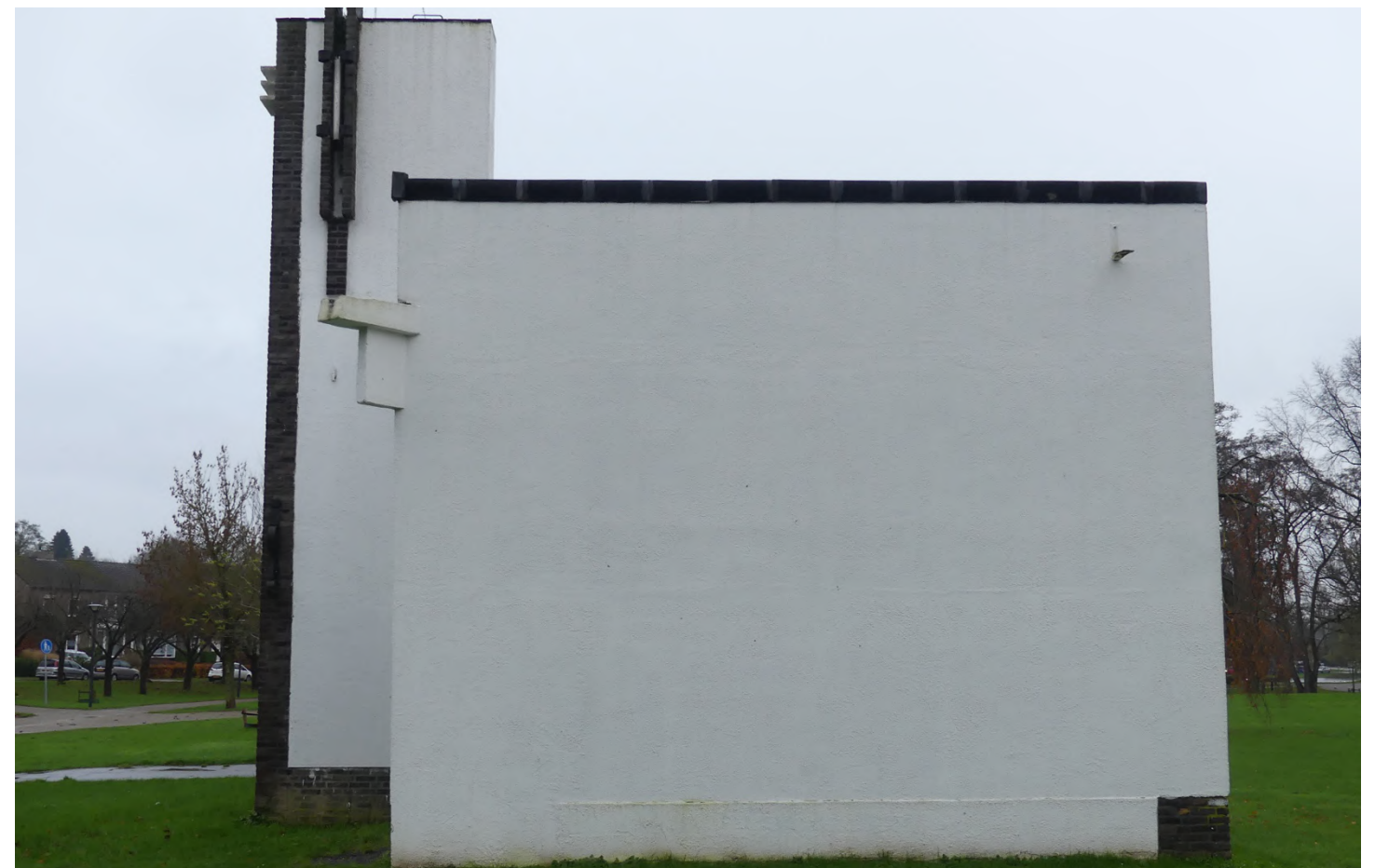
Afb. 14: rechtergevel rechtervolume voormalige zwembad
