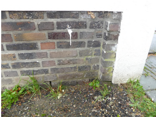
Afb. §22.05, uitgespoeld voegwerk bij maaiveld en begroeiing
