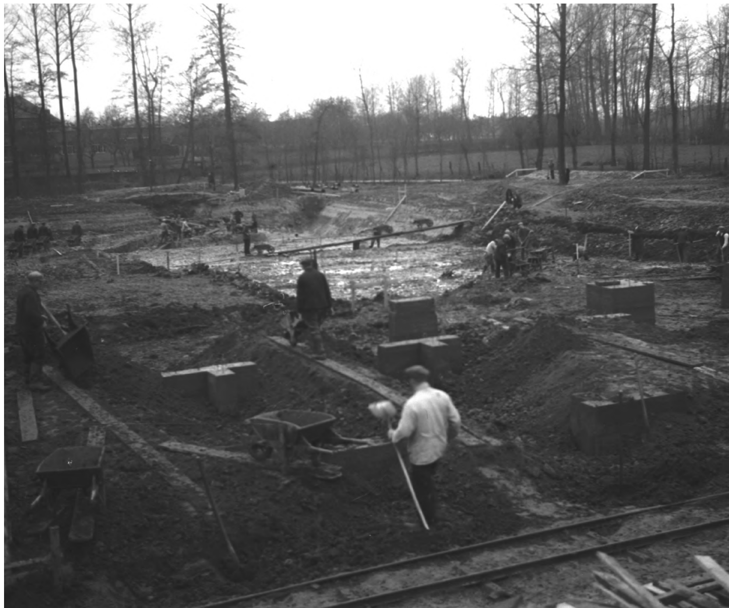
Afb. 15: aanleg van het zwembad, graaf- en funderingswerk voor het bassin, 1932-1933 (Gemeente Sittard, Glasplatencollectie)
