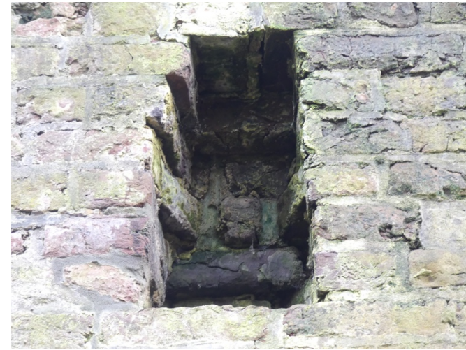
Afb. §22.25, detail gat met opzettelijk schuin gelegde stenen (functie?)
