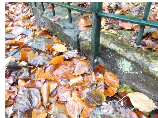
Afb. §43.18, roestvorming op sluitpilaster poortje
