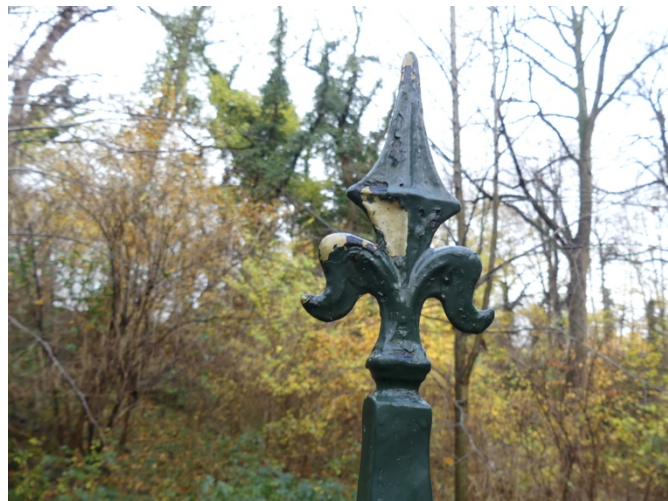
Afb. §43.04, goudverf onder groene deklaag (mogelijk verguld)
