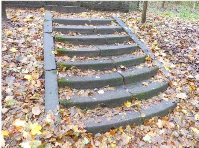
Afb. §15.01, trap met bladval, alg- en mosaangroei en open voegen tussen treden
