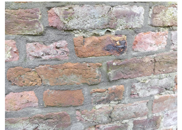
Afb. §22.28, fracties mogelijk origineel voegwerk
