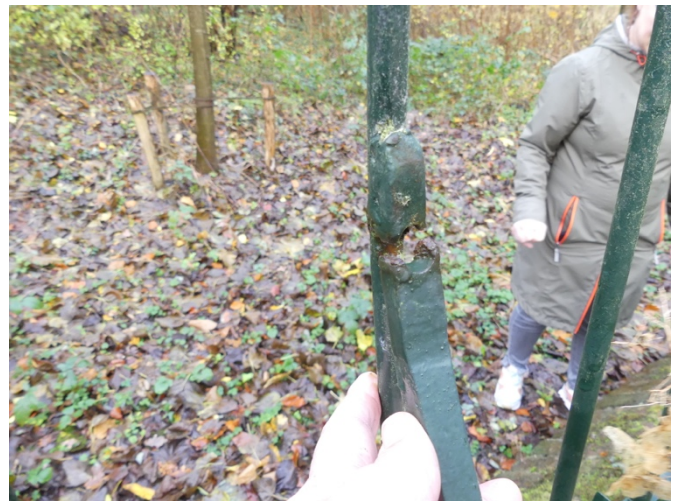
Afb. §43.10, losgeroeste bevestiging schoor
