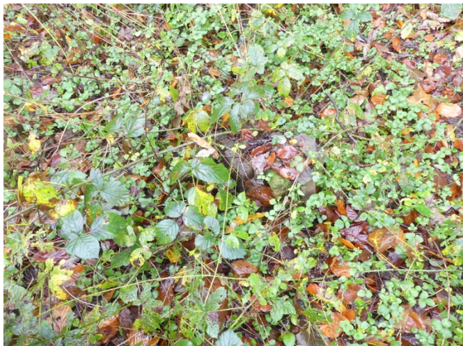
Afb. §15.03, (mogelijk) afgefallen stukken metselwerk
