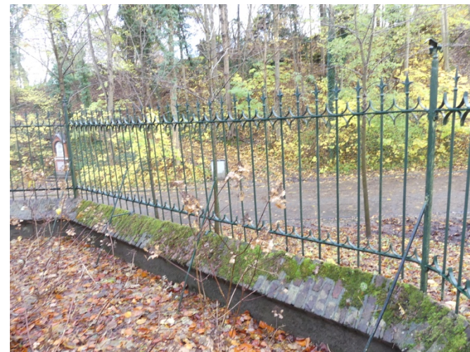
Afb. §43.02, overzicht binnenzijde hekwerk met pilasterschoren
