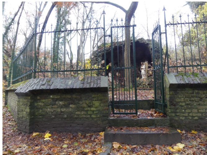
Afb. §43.01, overzicht buitenzijde hekwerk met poort
