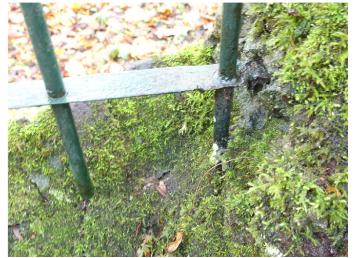
Afb. §43.06, roestvorming en aangetaste, dun geworden strip
