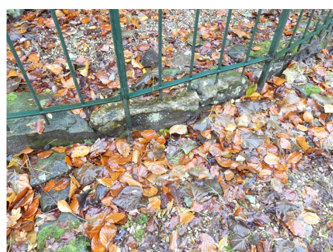
Afb. §43.19, onderzijde poortje met roestvorming
