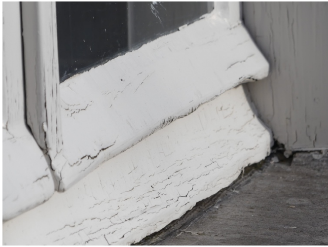
Afb. §46.11, ernstig gebarsten schilderwerk op raam- en kozijn-dorpel
