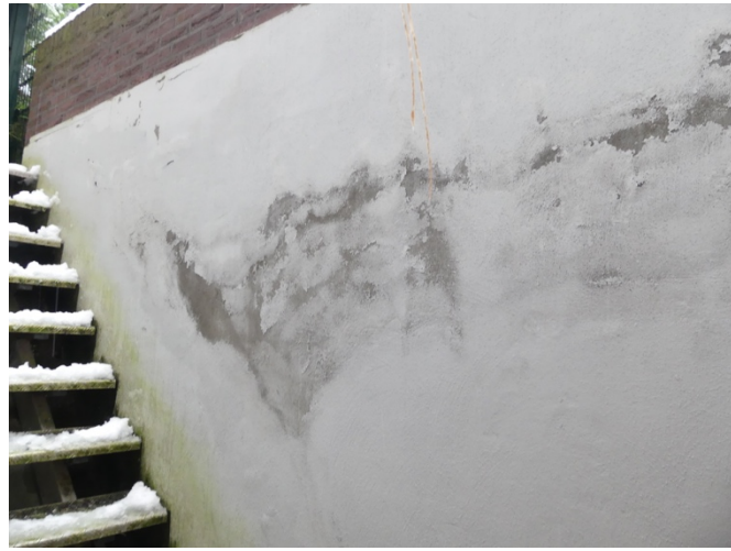
Afb. $46.23, doorslaand vocht buitenwand trapkoekoek
