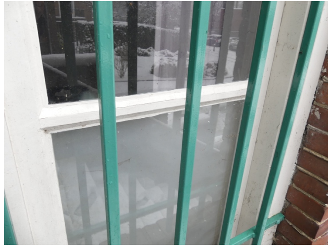
Afb. §34.01, losscheurende stopverf
