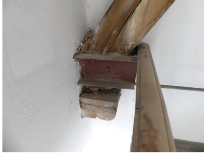
Afb. §24.02, versteviging/vervanging van onder eind spantbeen
