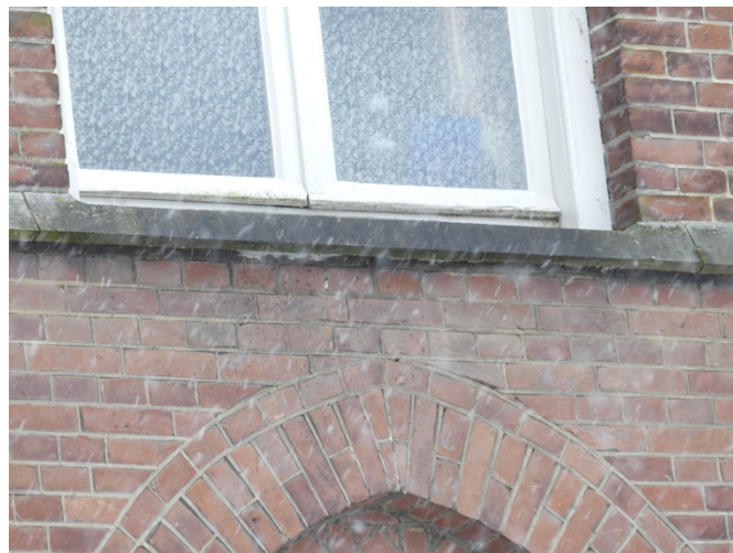
Afb. §46.02, slecht schilderwerk onderzijde raamdorpels, gebarsten verf
