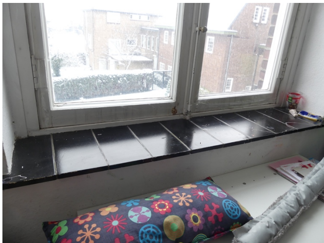
Afb. §46.03, binnenzijde draairaamkozijn
