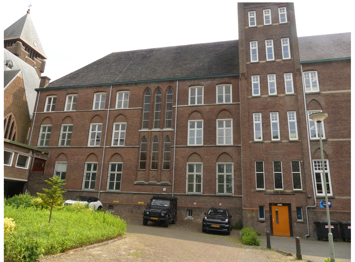
Afb. 07: noordgevel van de Duitstalige kloosterschool; de uitspringende hogere gevel hoort niet bij het monument
