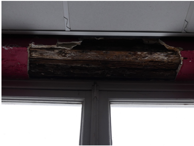
Afb. §45.02, afgefallen betimmering houten latei
