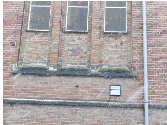
Afb. §22.07, algaanslag op afzaatstenen van de nissen
