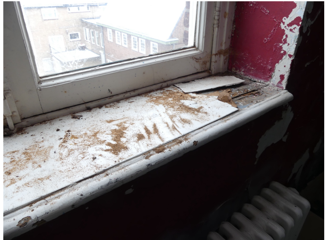
Afb. §45.01, beschadigde originele vensterbank met board camouflageplaatje
