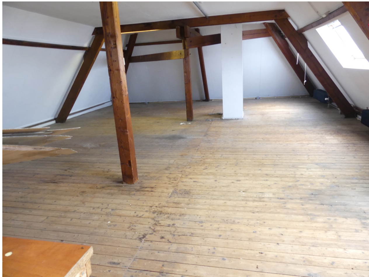
Afb. 10: zolderverdieping met deels afgetimmerde kapconstructie
