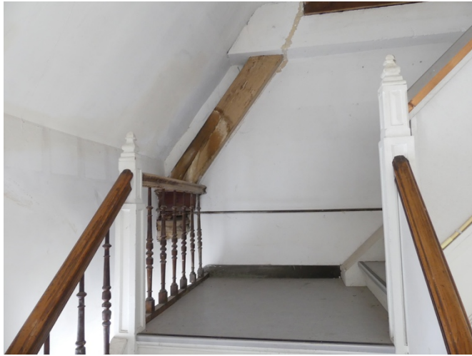
Afb. §24.01, overzicht kapconstructie in trappenhuis
