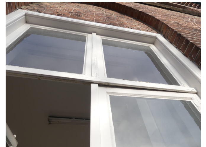
Afb. §46.10, gebarsten schilderwerk op bovenraam
