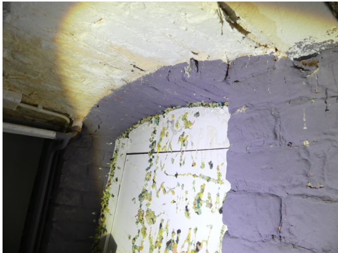
Afb. $46.24, doorslaand vocht troggewelf, bladderend sauswerk
