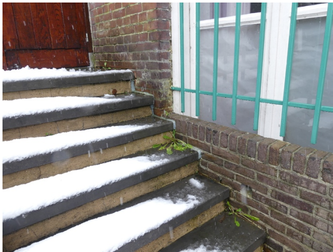
Afb. §22.03, algaanslag, uitgespoeld en met -foutief aangebrachte-kit 'hersteld' voegwerk
