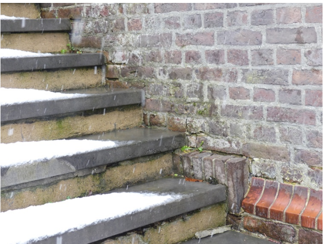
Afb. §22.04, algaanslag, uitgespoeld en foutief hersteld voegwerk
