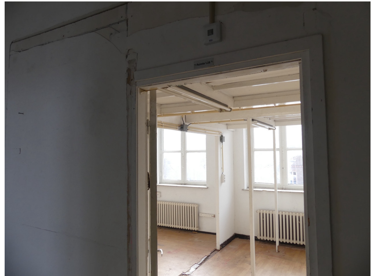
Afb. 12, lokalen aan de zuidgevel
