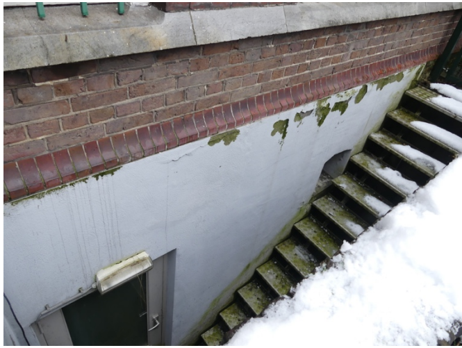
Afb. $46.22, aangetast, afbladderend schilderwerk trapkoekoek
