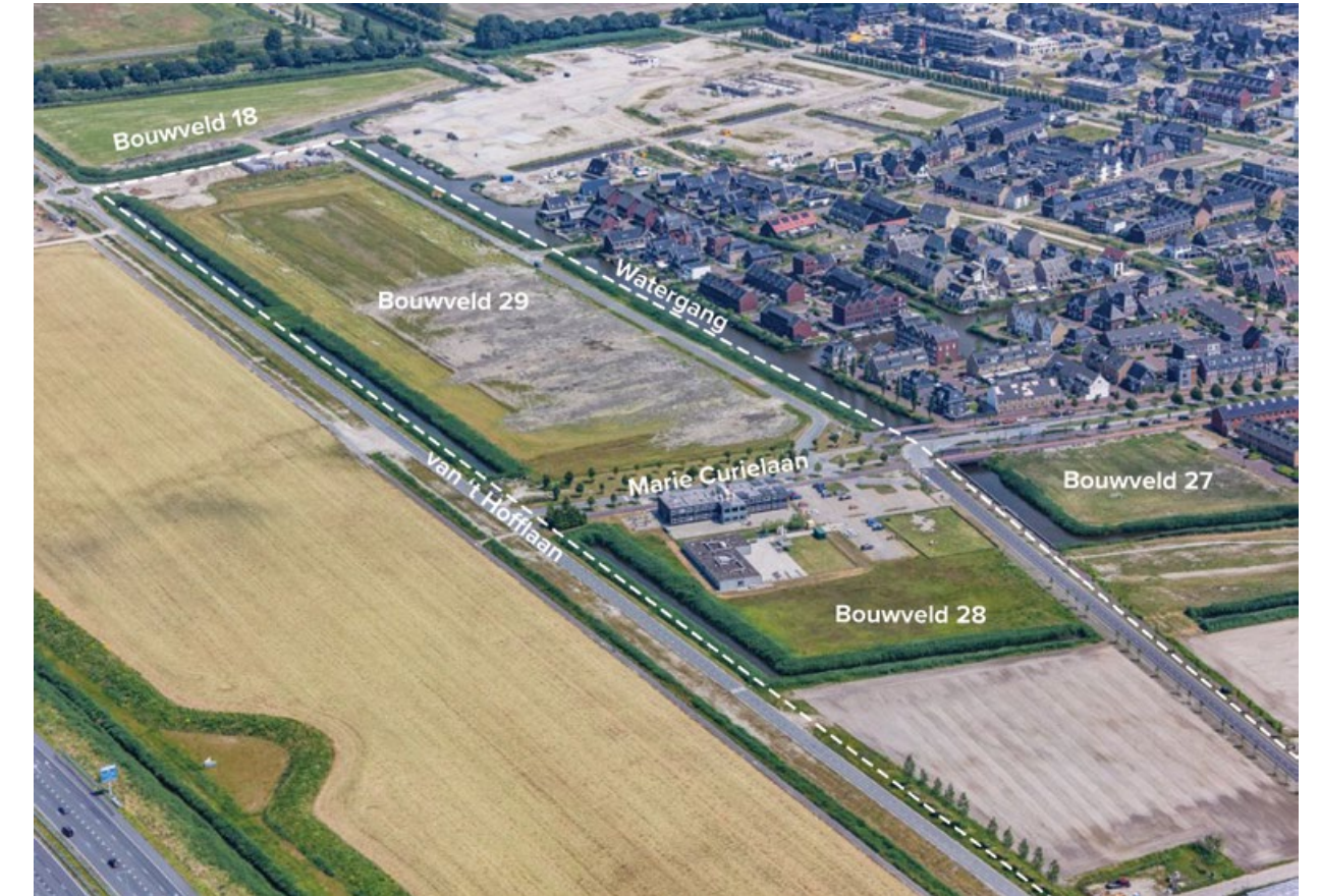
Luchtfoto plangebied vanuit west (situatie mei 2024)
