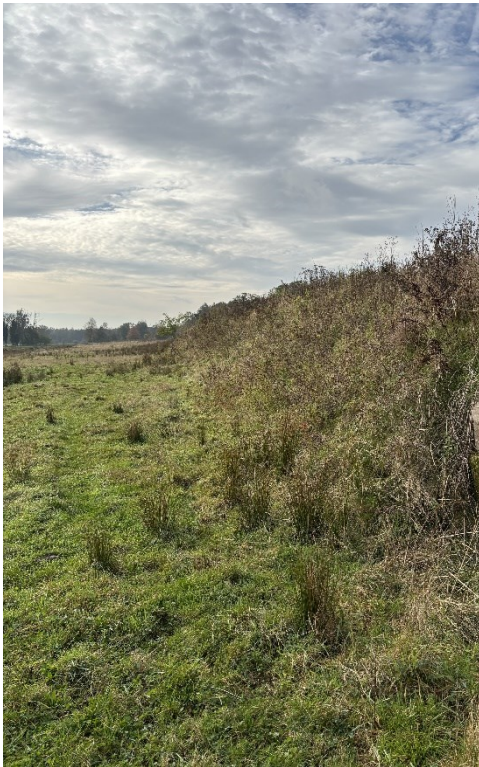
Figuur 12: Foto buitentalud steilranddijk dijktraject 62-1 (genomen d.d. 28-10-2024)
