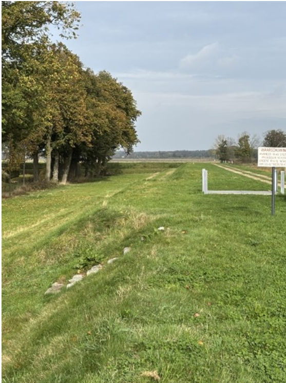
Figuur 26: Verbreiding dijk pomplocatie 't Sor
