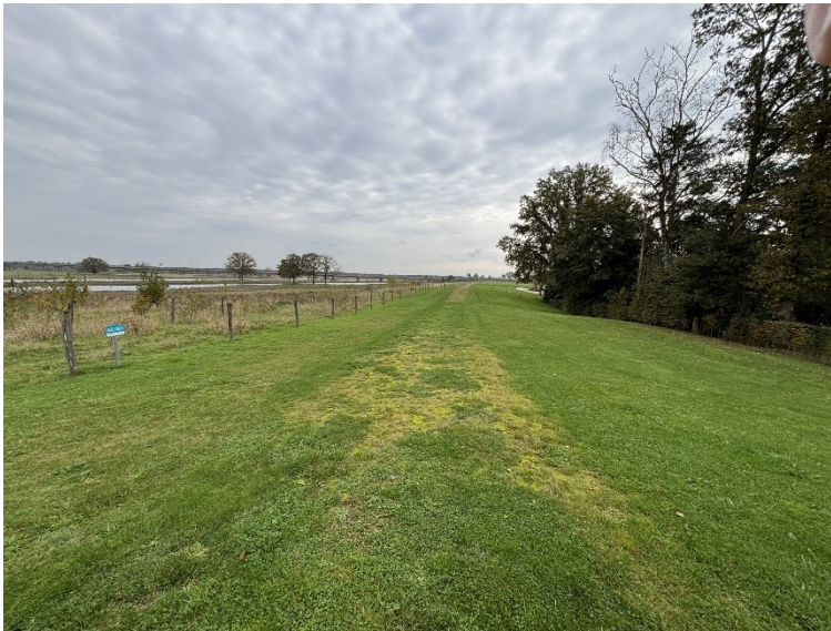
Figuur 14: Foto hoge gronddijk dijktraject 62-1 (genomen d.d. 28-10-2024)
