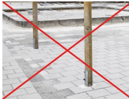
Figuur 4: Buitenruimte is niet volledig verhard
