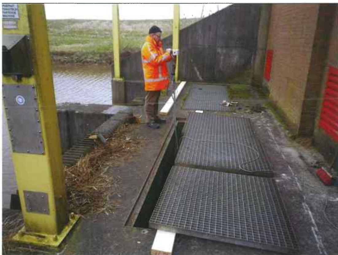
Figuur 5.1 Overzicht meetlocatie pomp 1
