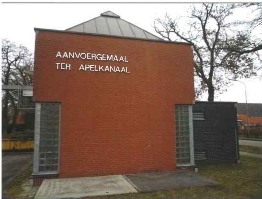
Figuur 1.1 Aanvoergemaal Ter Apelkanaal
