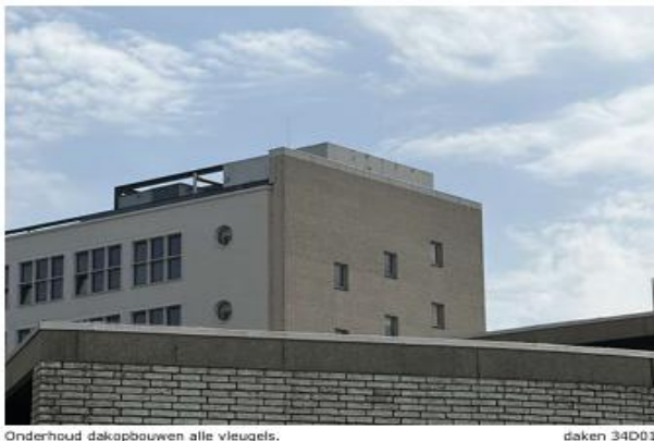
Onderhoud dakopbouwen alle vleugels. Figuur 6 – Dakopbouwen
