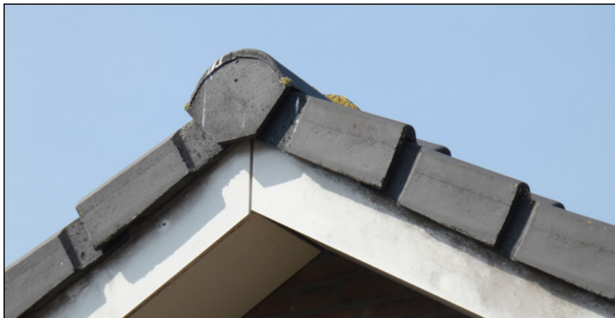
Figuur: potentiële verblijfplaats voor huismus of gierzwaluw.
