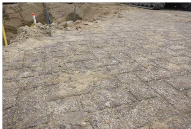
F10: Vloer inspectie gebied.
