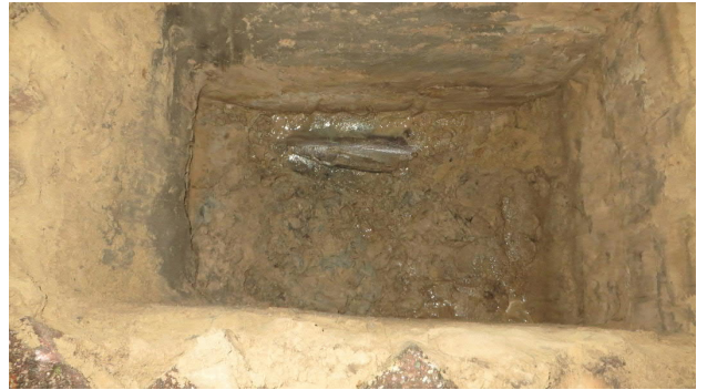
Foto 2: Het hoofdriool (PVC) in ter plaatse van proefsleuf 4 in het Schouthof.
