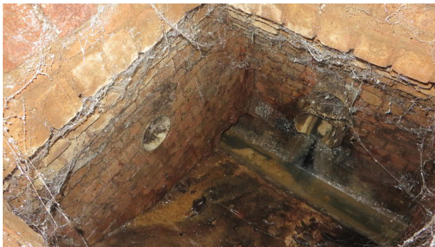
Foto 3: Inkijkje in 'n inspectieput in het Schouthof met daarop aangesloten diverse PVC-leidingen
