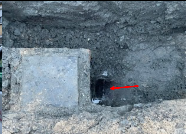
Foto 2: Verbinding tussen rioleringsbuizen
