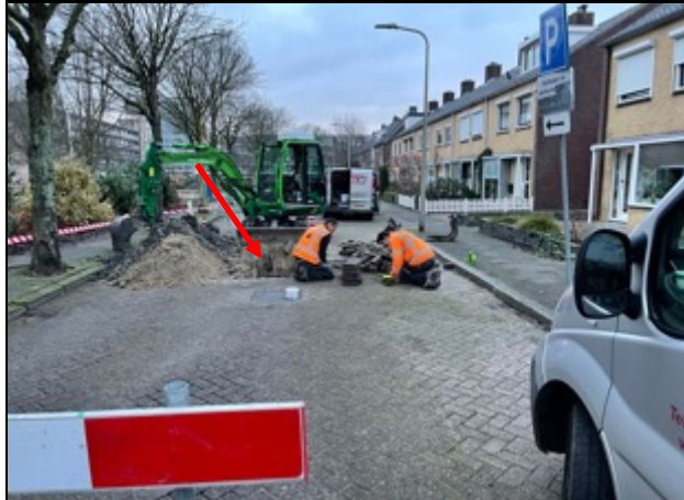
Foto 1: Verbinding tussen rioleringsbuizen
