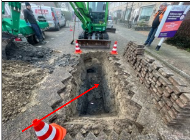
Foto 1: Verbinding tussen rioleringsbuizen Conradstraat
