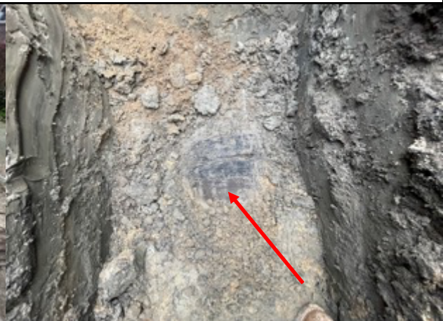
Foto 2: Verbinding tussen rioleringsbuizen Conradstraat
