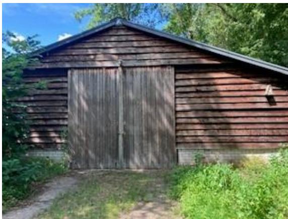
voormalige ligboxenstal-opslag buitenzijde
