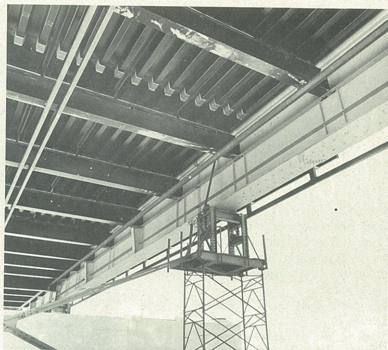
6 Aanzicht binnenzijde hoofdliggers
