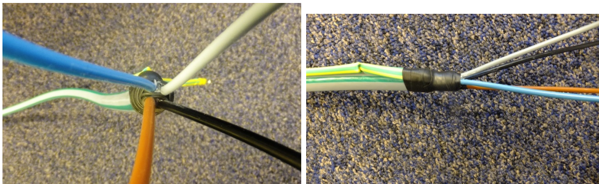
Figuur 2: eind afwerking voor OVL kabels in Lichtmasten en in OVK schakel- en verdeelinrichtingen, doormiddel van vulkaniserende 3M Scotch 23 Rubber.
