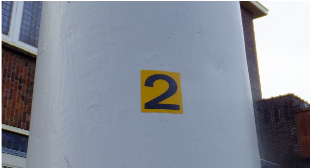
Figuur 1: zelfklevende nummerstickers, materiaal: scotchlite 580-71, kleur: geel, retroreflecterend. Druk: 1 kleur zwart. Cijfervlak: 38x25mm / cijferhoogte: 32mm.
