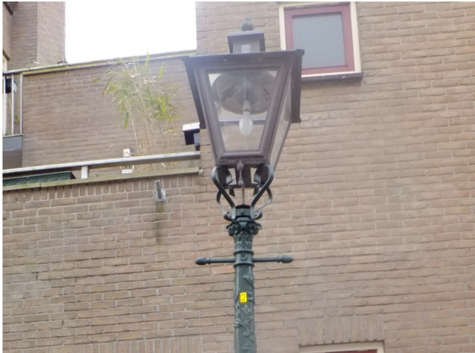
Figuur 1: verlichting armatuur Leidse Lantaarn met nostalgische openingshandel haaks op de rijrichting monteren. De trapsteunen met de rijrichting mee monteren.
