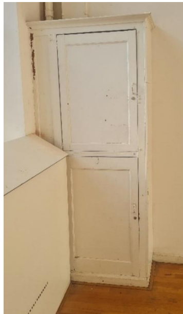
Begane grond: oorspronkelijke kast (vermoedelijk meterkast)
