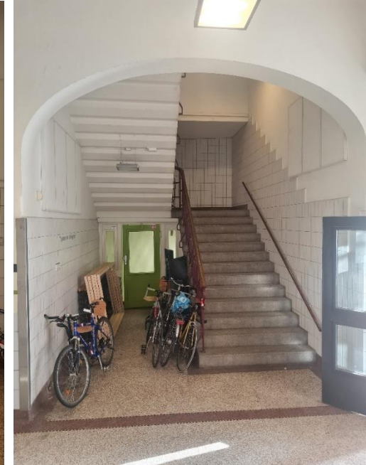
Het trappenhuis met links de voormalige binnenplaats en rechts het voorhuis (GM).
