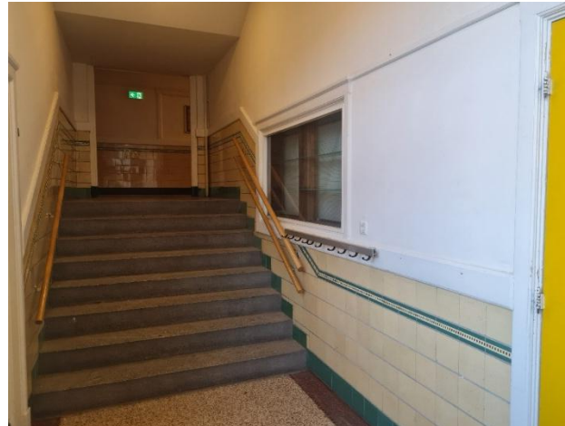
De trap aan het eind van de gang dateert uit ca 1927 toen er boven de gymzaal lokalen kwamen.
