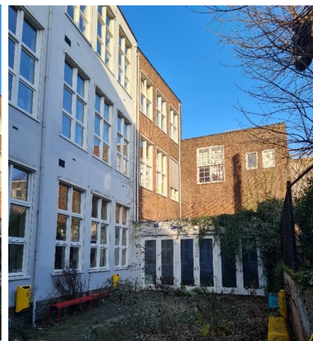
De in metselwerk uitgevoerde gevels uit 1922 en 1927 met aanbouw uit 1966 die aansluit op de gymzaal.
