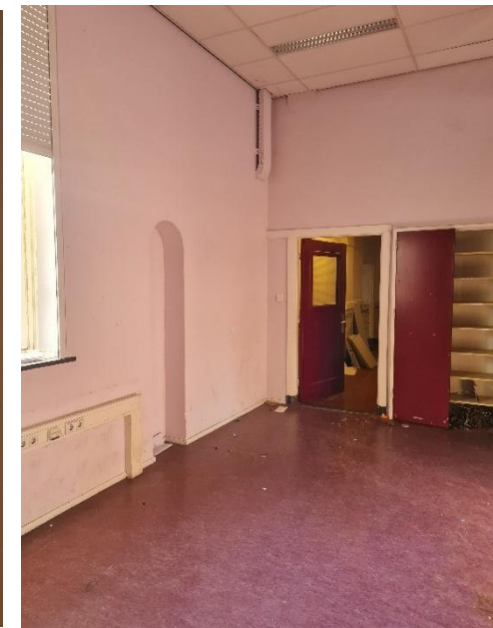
Het lokaal aan het uiteinde van de gang, boven de gymzaal. In de nis zat waarschijnlijk ooit een wasbak. De kastdeuren zijn vernieuwd.
