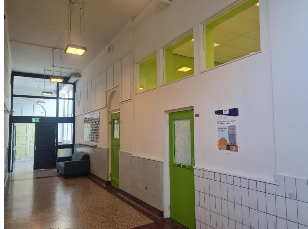
Voorste deel van de gang (2 e verdieping) met links de nieuwe branddeur. De deur onder de boognis geeft toegang tot het oorspronkelijke lokaal. De deur rechts hiervan is een latere toevoeging. Hier zat oorspronkelijk een venster met daarachter een binnenplaats. De vloer dateert uit 1909, de tegellambrisering uit 1961-1968 of later.
