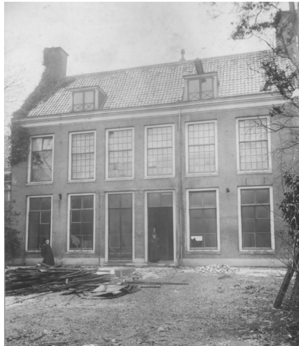
Vlak voor de sloop in 1909, De achtergevel van de aanbouw met op de verdieping zijn schuifvensters met vijfdeling (1 e helft 18 e eeuw) en op de begane grond en het eerste venster zijn empire schuifvensters met een verdikte middenstijl (1 e helft 19 e eeuw). De veranda is reeds gesloopt.
