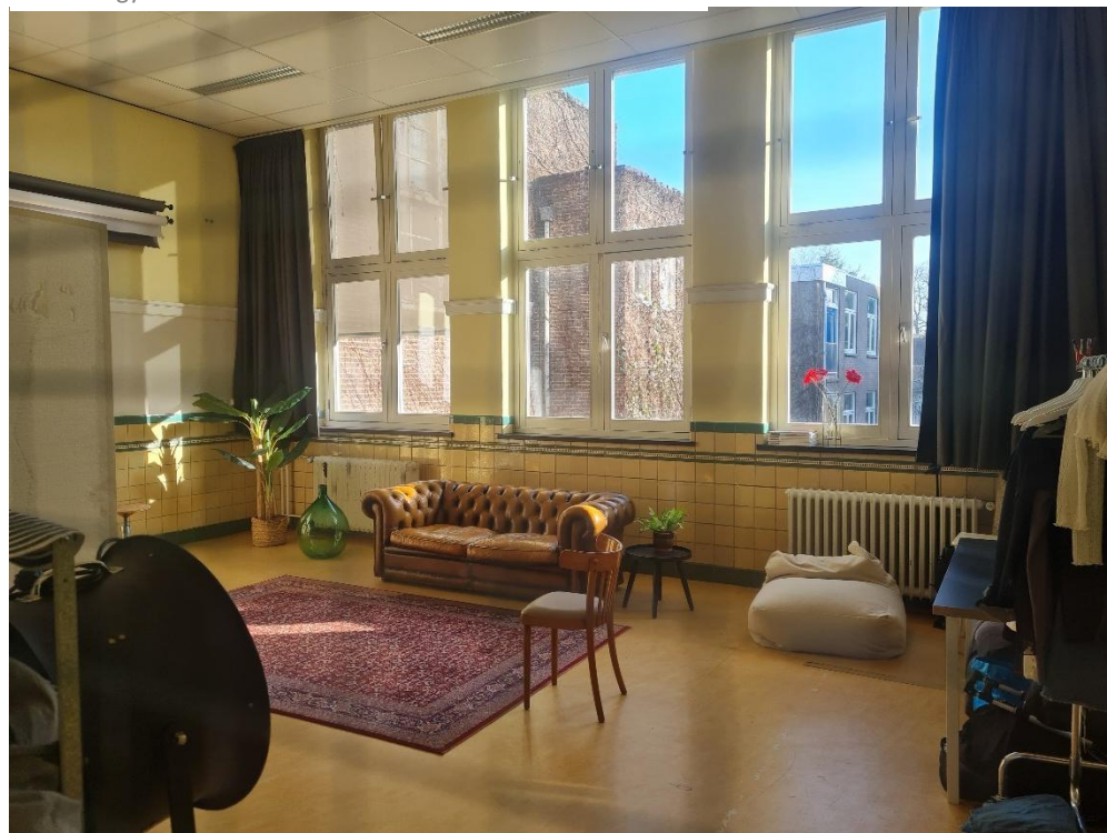
Klaslokaal uit 1922 (1 e verdieping) met de oorspronkelijke tegellambriserings, lijstwerk langs de wanden, vensterbanken en inbouwkast met dubbele paneeldeur.
