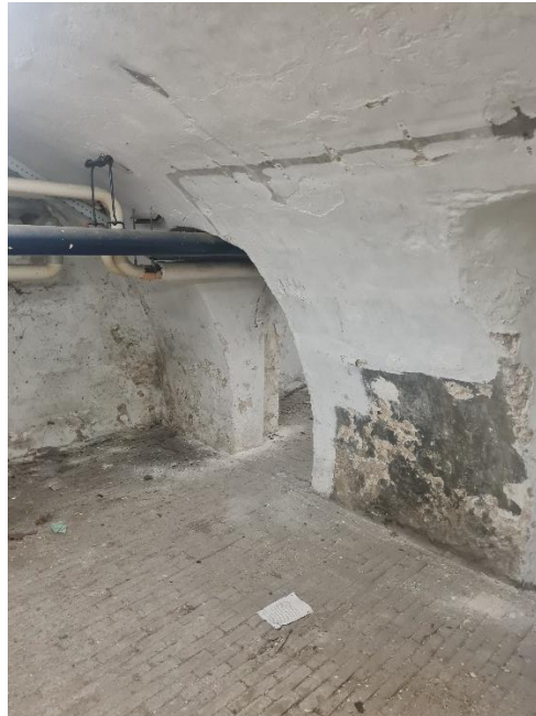
Een deel van het souterrain van de het voorhuis heeft nog zijn (vermoedelijk) laat middeleeuwse tongewelf. Deze heeft een hoge bouwhistorische waarde vanwege de ouderdom en omdat ze kenmerkend zijn voor Utrecht.
