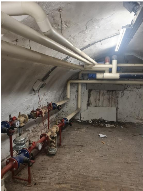
Een deel van het souterrain van de het voorhuis heeft nog zijn (vermoedelijk) laat middeleeuwse tongewelf. Deze heeft een hoge bouwhistorische waarde vanwege de ouderdom en omdat ze kenmerkend zijn voor Utrecht.
