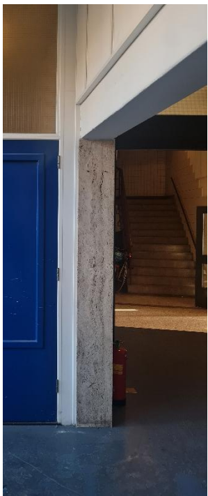
Doorgang met een natuurstenen afwerking (mogelijk travertin)
