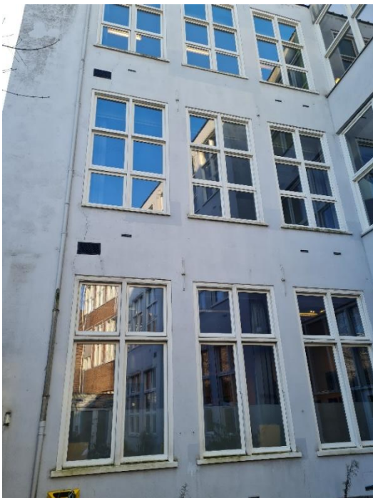
Achtergevel Kromme Nieuwegracht (noord)
