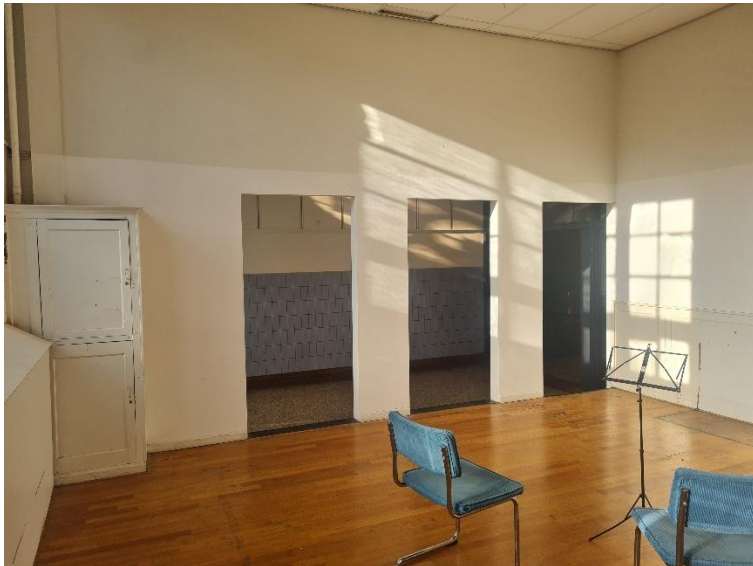
Begane grond: ruimte aan de voorzijde met zicht op de gang. Alleen de laatste opening is oorspronkelijk (hier zat een paneel deur). De kast links dateert vermoedelijk uit de bouwtijd (1909). Geheel rechts is de oorspronkelijke lambrisering.
