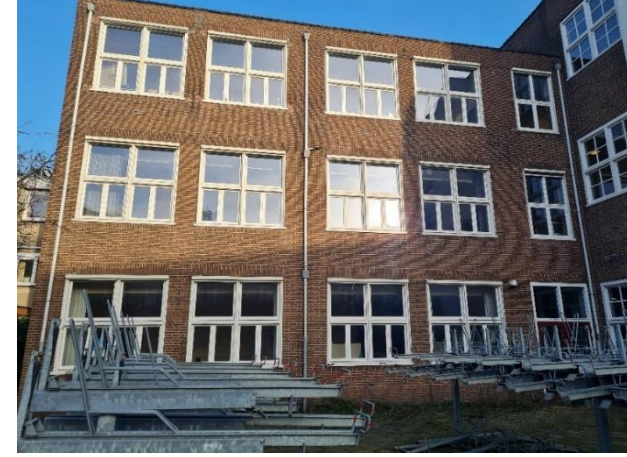
De achtergevel van het bouwdeel aan de Nobeldwarsstraat (1922) het raamhout en dubbele deuren zijn later vernieuwd en voorzien van dubbel glas.
