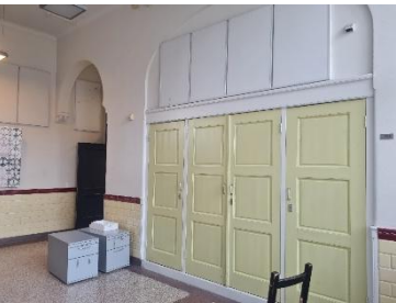
Boogvormige doorgang en later aangebrachte inbouwkasten onder een segmentboogvormige nis.
