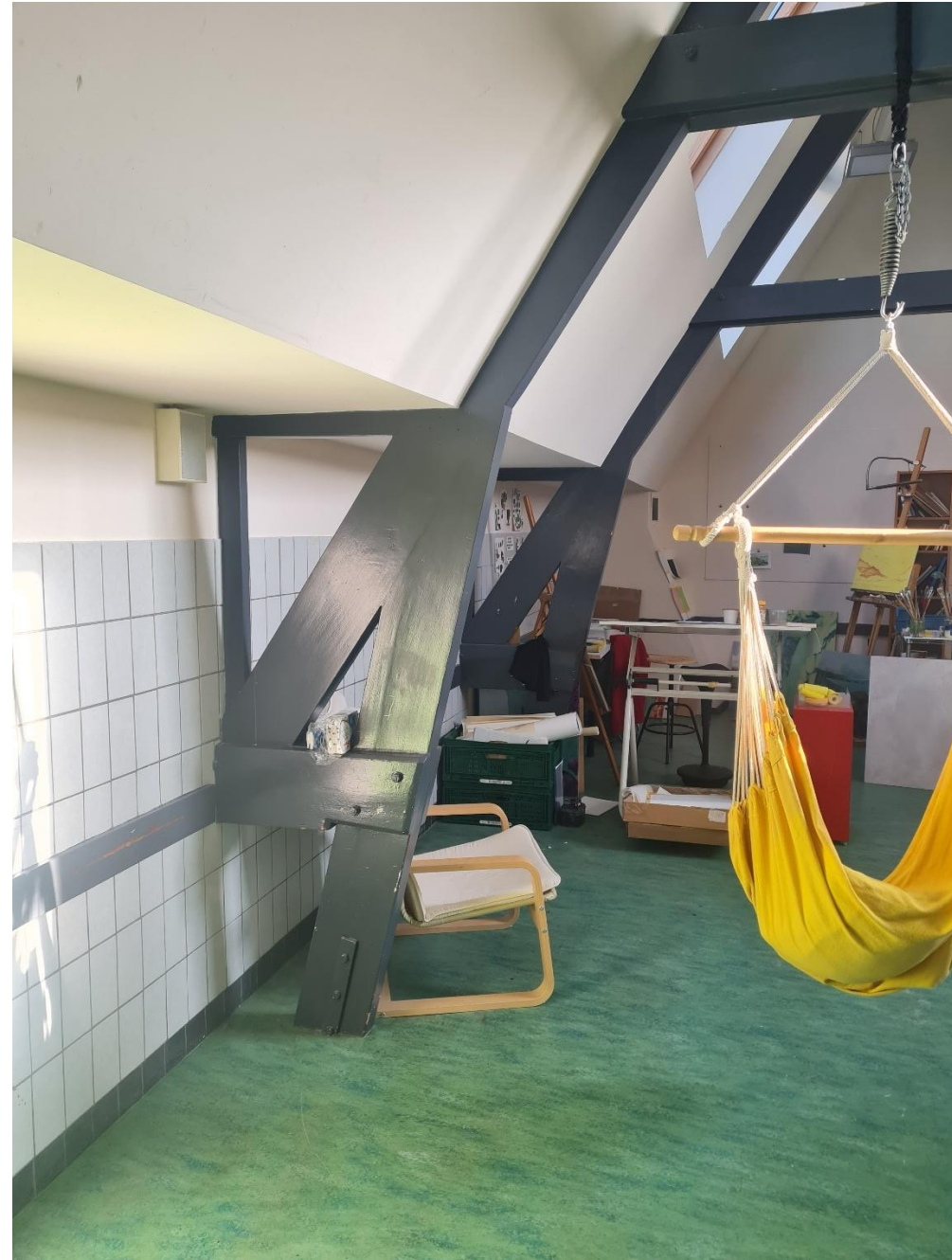
Zolderverdieping, buiten de constructie en dakkapel is er geen oorspronkelijke afwerking.
