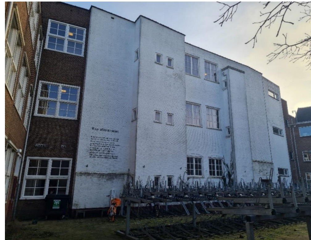
Gevel van de gang en toiletten.
