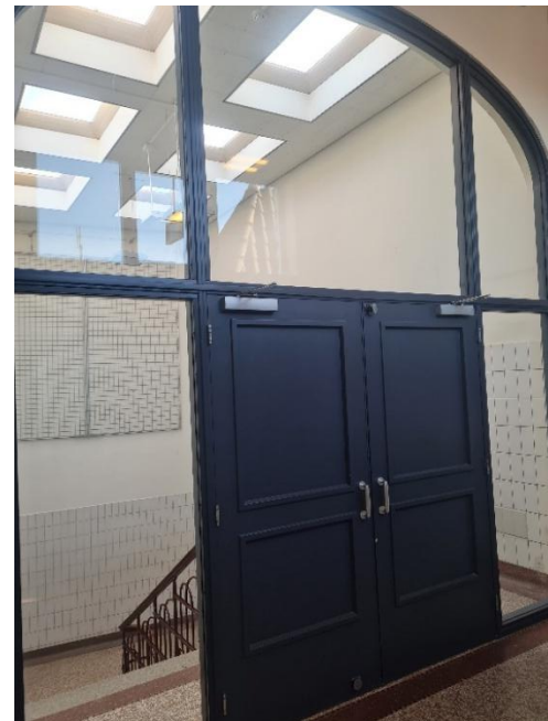
Branddeur, daklichten en tegellambrisering zijn latere toevoegingen.
