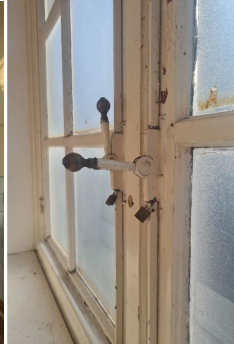
Begane grond: De vensters hebben hun oorspronkelijke hang- en sluitwerk (1909).
