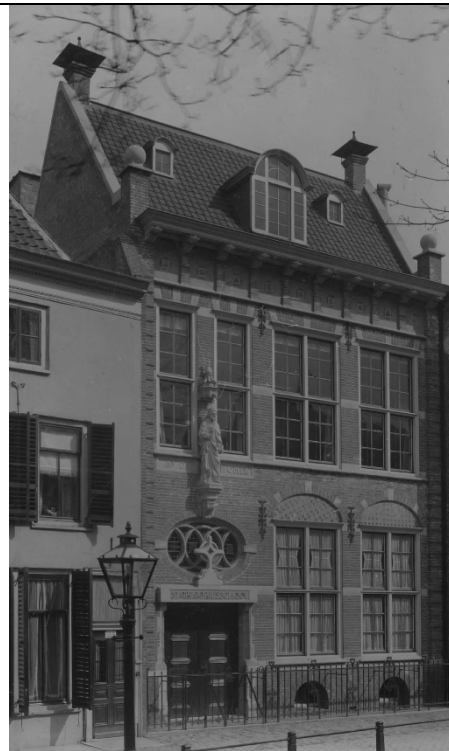
Voorgevel van de school, datering tussen 1909-1918
