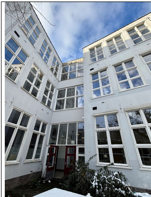
Gevel D, ten tijde van de inspectie
