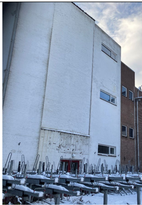
Gevel J, ten tijde van de inspectie
