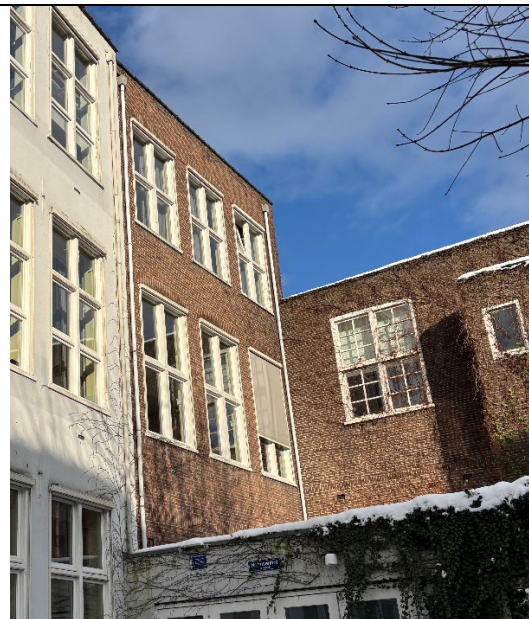
Gevel, ten tijde van de inspectie
