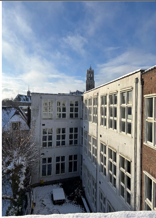
Gevel D en E, ten tijde van de inspectie
