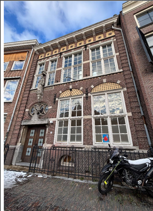
Voorgevel, gevel G ten tijde van de inspectie
