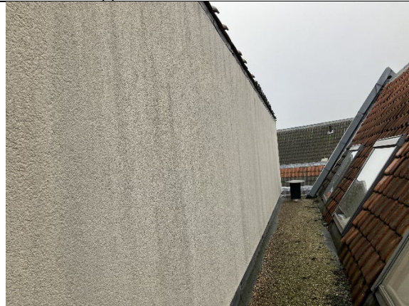
Buitenzijde voorzien van ISPO-gevel
