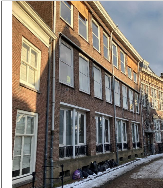
Voorgevel, gevel G, ten tijde van de inspectie
