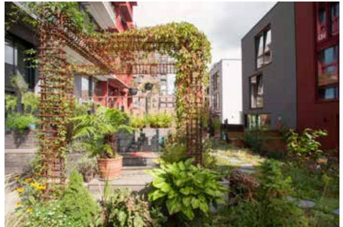
Pergola op dak
