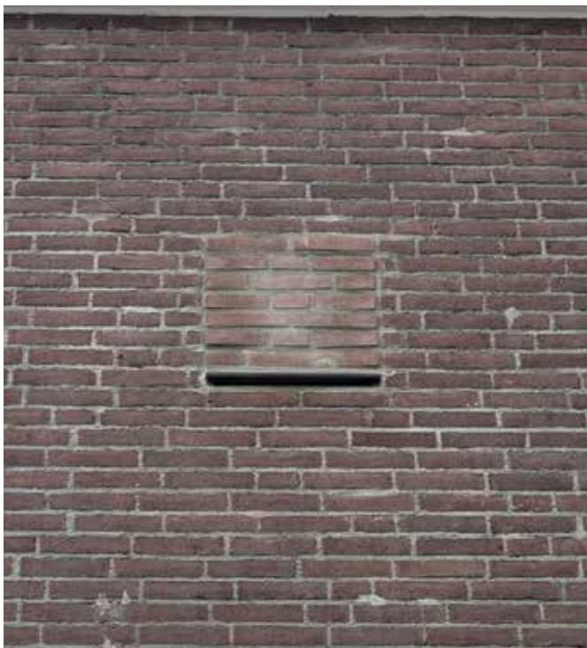
In 2024 werd tegelijk met spouwmuurisolatie een vleermuis-kast ingemetseld, in de gevel van een woonhuis uit 1978.
