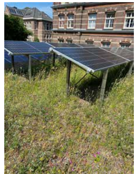
Groengeeldak op een gemeentelijk dak in de Ite Boeramastraat in Amsterdam West.
