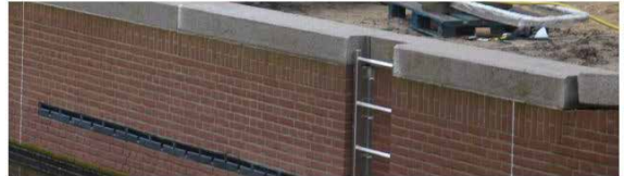
Uitklimtrap RVS verwerkt in de kadeconstructie
