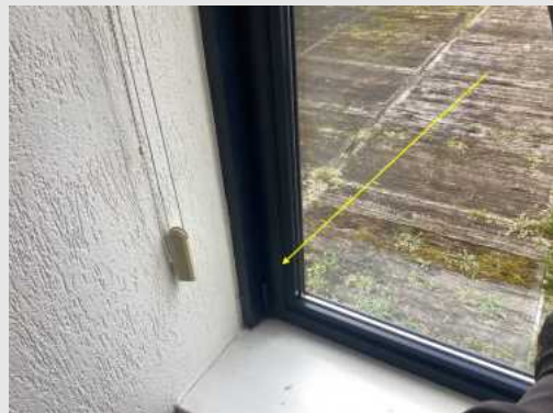
Meetpunt X30 kantoor begane grond
