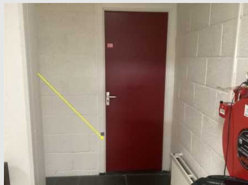
Meetpunt X14 kozijn deur naar vergaderruimte 2e etage.
