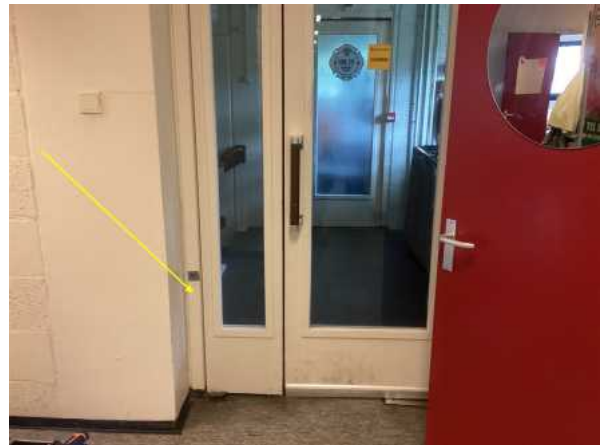
Meetpunt X24 kozijn deur naar vergaderruimte 2e etage.
