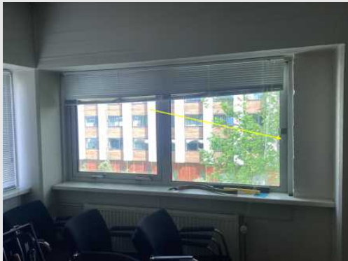
Meetpunt X15 kozijn vergaderruimte noordkant 2e etage
