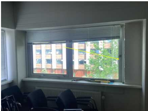
Meetpunt X15 kozijn vergaderruimte noordkant 2e etage
