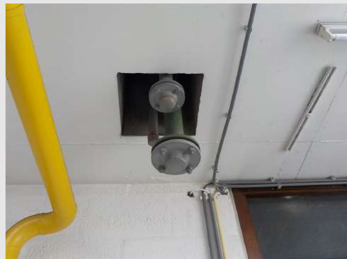
cv-ruimte slangenwasserij: 1x asbestpakking bij de bovenste flens (grijze leiding). In de onderste flens (groene leiding) is een rubberpakking aanwezig
