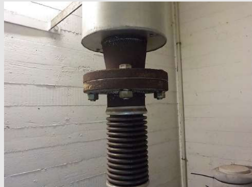
NSA ruimte begane grond
