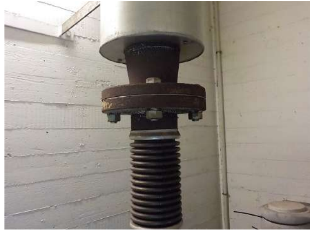
NSA ruimte begane grond
