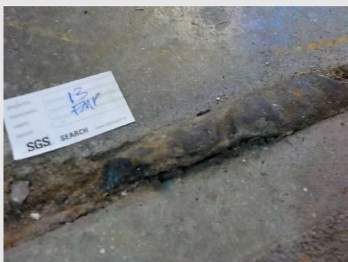
13 Bitumen, in vloer dilatatie
