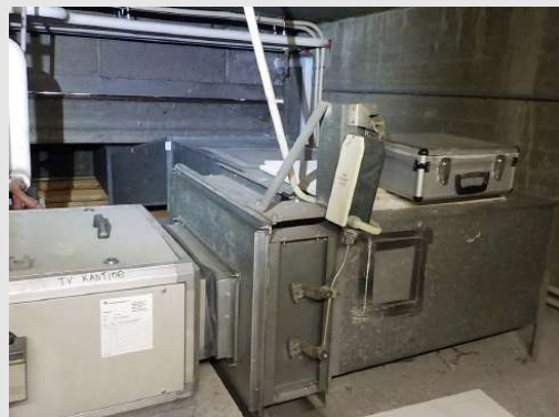
Kruipruimte 020, met kanaaltrace waarin kit gebruikt is
