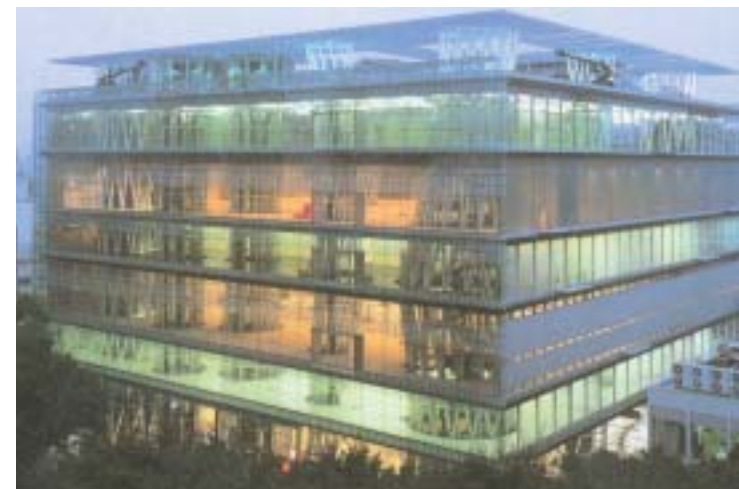
Voorbeelden van bedrijfsverzamelgebouwen
