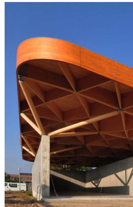
Houten constructie betonnen voet
