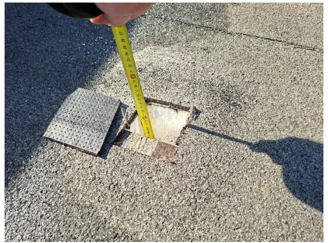
Foto 26 Insnijding 2, twijfel over de windweerstand, geen vocht aangetroffen.
