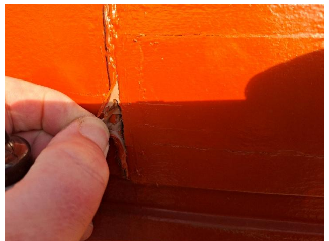
Foto 12 Aantasting van het hout bij de stuiknaden afgedicht met kit.
