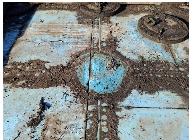
Foto 4 Lichte indrukking van de XPS-isolatie bij de tegel dragers.
