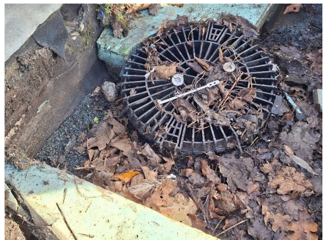
Foto 18 Veel bladeren en organische vervuiling bij de hemelwaterafvoeren.
