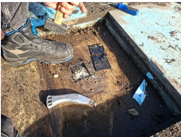
Foto 5 Insijding, er is een goede en volledige verkleving aangetroffen.
