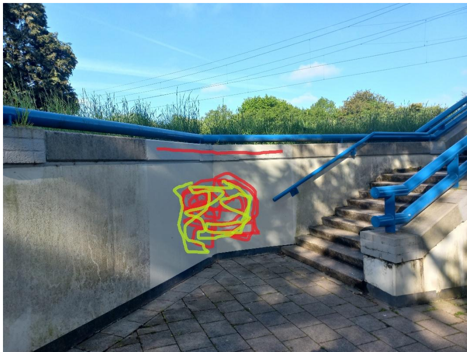
Foto graffiti Zwartewegtunnel
