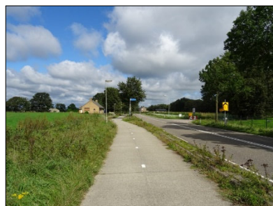
Figuur 2.20 Eindpunt tracé binnen bebouwde kom Moleneind, kijkrichting noord.
