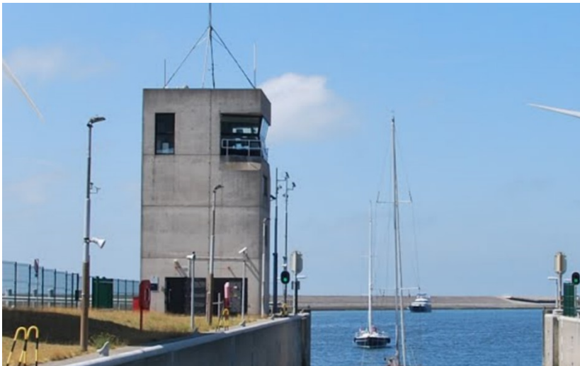
Figuur 20 Lokaal bedieningsgebouw Roompotsluis
