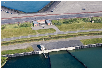
Figuur 23 situering Brouwersspuisluis
