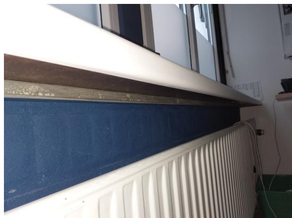
Radiatoren en vensterbanken geen asbest
