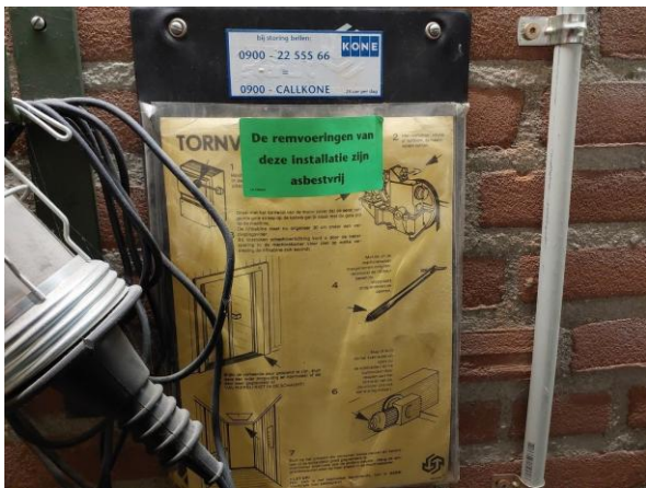
Remschoenen lift asbestvrij
