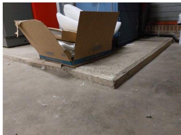
Betonopstorting, geen golfplaat
