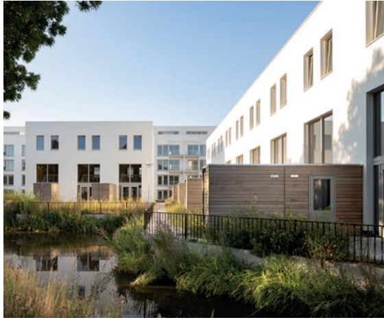
Hout als bouw materiaal met biobased pleisterwerk als gevelafwerking (Studio Nauta).
