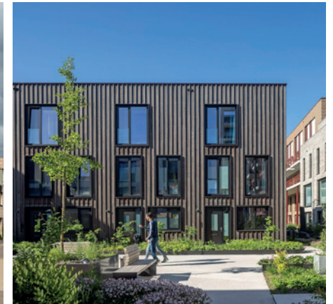
Houten gevel (ANA architecten).
