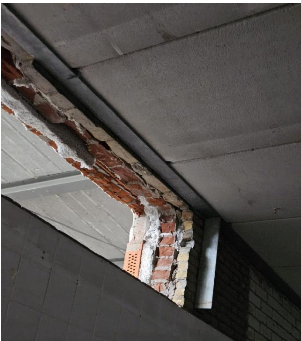
Figuur 10: foto van de hoeklijn die een groot vervorming blootstelt. Bouwbezoek d.d. 23-01-2026.
