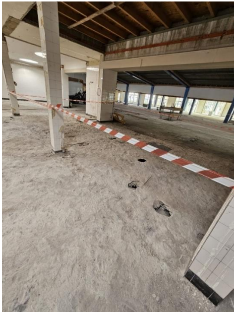
Figuur 15: Foto van de te vervangen combinatievloer.
