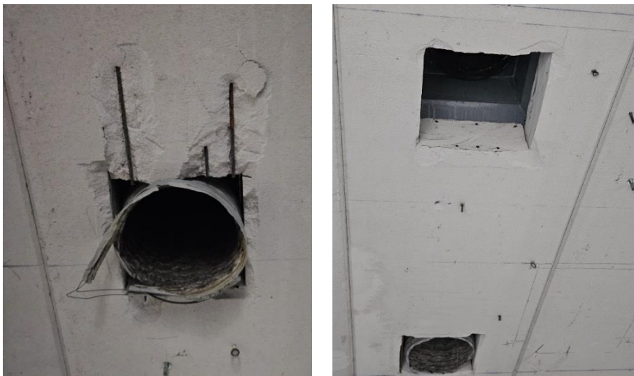
Figuur 8: foto van de sparingen in de gasbetonvloer. Bouwbezoek d.d. 23-01-2026.
