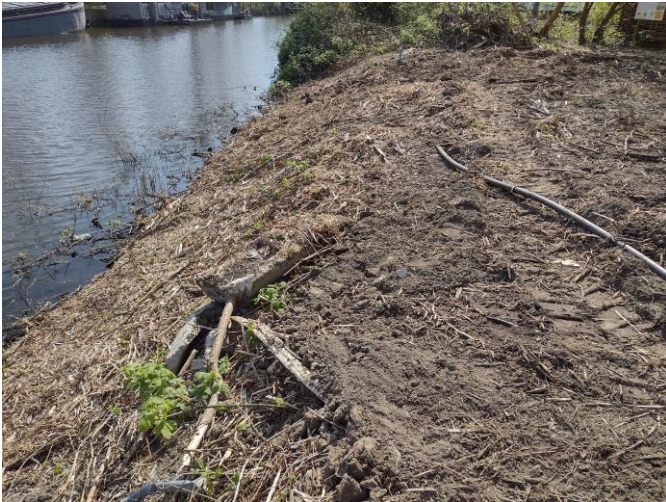
Foto 13: Beton in talud Suikerzijde
