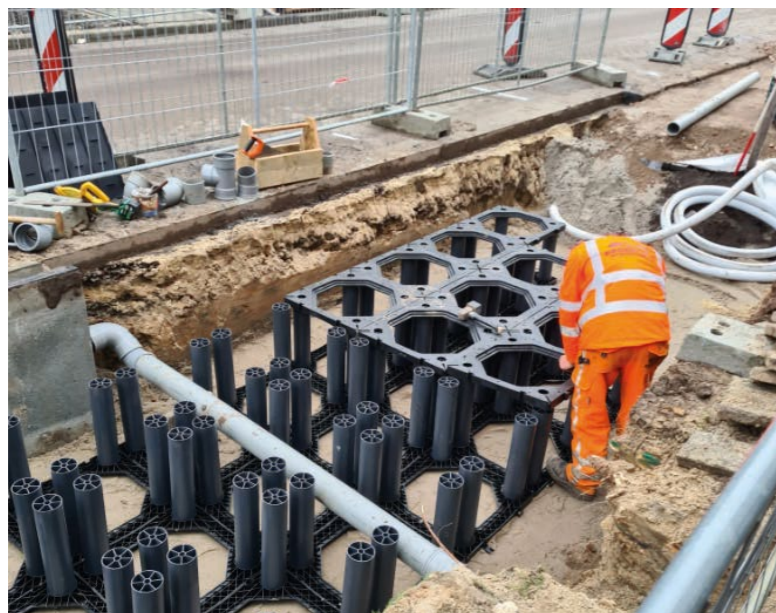
Foto aanleg boombunker Hagedisstraat Groningen
