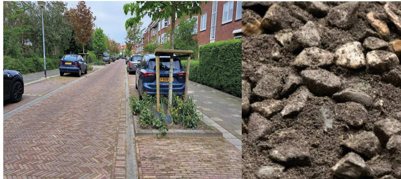
Foto bomen in bomengranulaat aan de Van Houtenlaan
