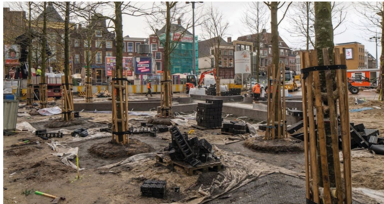
Foto Bomen met drukverdelende constructie Grote Markt Groningen
