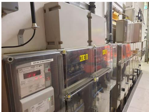
Afbeelding 4.2 RWS Hoofdverdeler met Stedin voeding (RED1 en RED2) en noodvoeding van ProRail (bron Figuur 39 rapport visuele opname brug Dordrecht)
