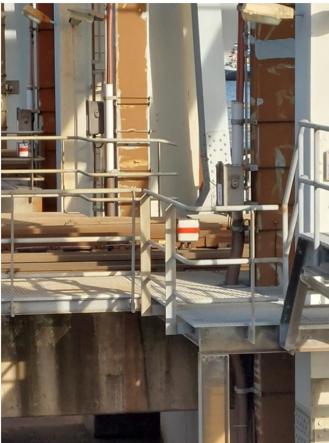
Figuur 50: mechanische vergrending en sein ProRail op hefbrug
