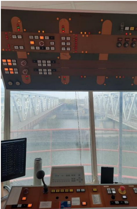
Figuur 21: storingstableau hefbrug en onderhoudsbediening
