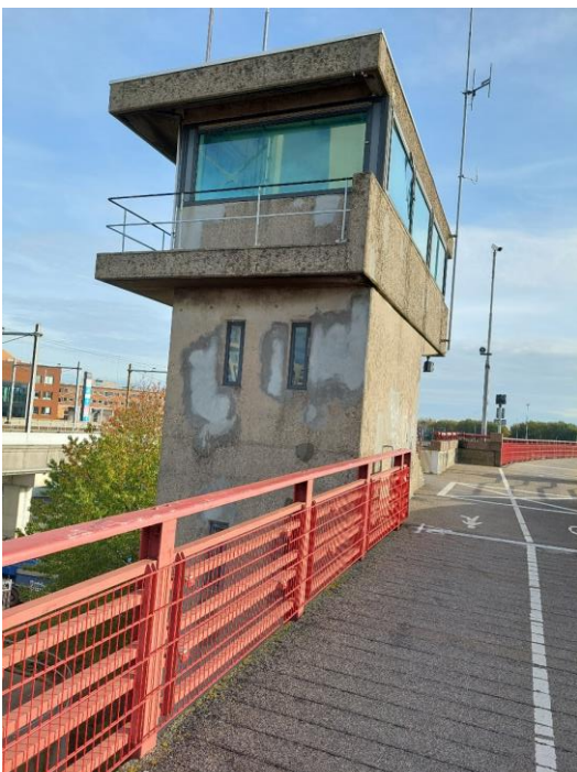
Figuur 56: oude bedienggebouw RWS brug (dordrechtzijde)
