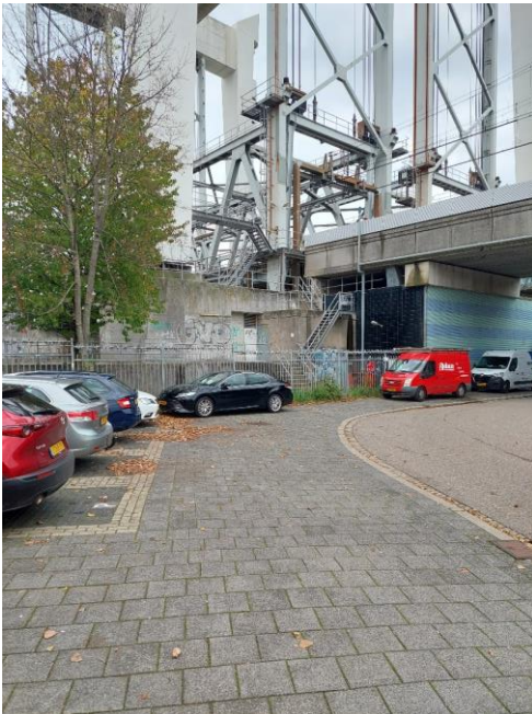
Figuur 49: technische ruimte hefbrug (prorail) dordrechtzijde
