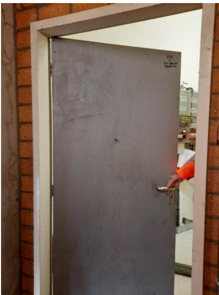
Figuur 33: Buiteningang bediengebouw naar technische ruimte bediengebouw
