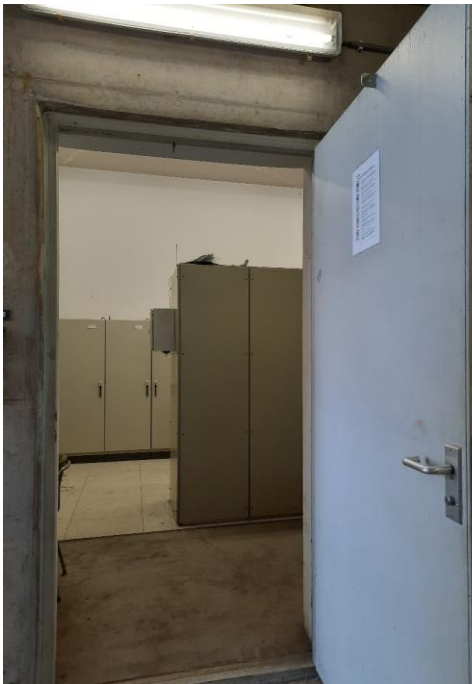
Figuur 12: Ingang technische ruimte ProRail hefbrug
