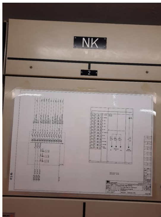
Figuur 9: Noodvoeding schakeling hefbrug PR
