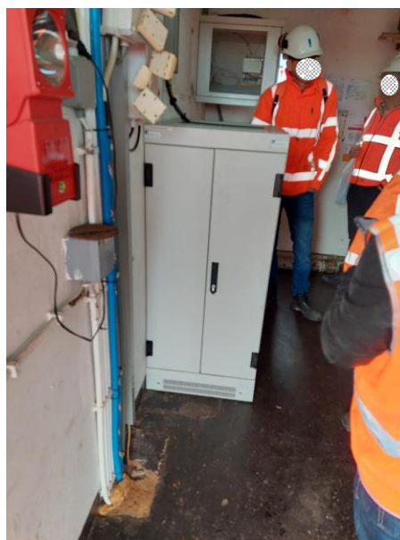
Figuur 46: overzicht bedienkast RWS brug in oude bediengebouw RWS
