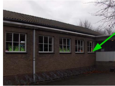
de stopverf in de gevelkozijnen is in 2019 onderzocht en bevat geen asbest
