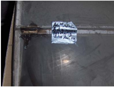
de stopverf in de oude dakramen op zolder is in 2019 onderzocht en bevat geen asbest
