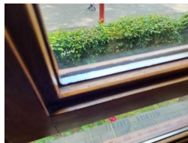
flexibele beglazingskitten zijn niet-asbestverdacht
