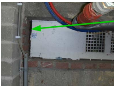
de vochtwering naast het kozijn in de kelder onder de ovale uitbouw is in 2019 onderzocht en bevat geen asbest
