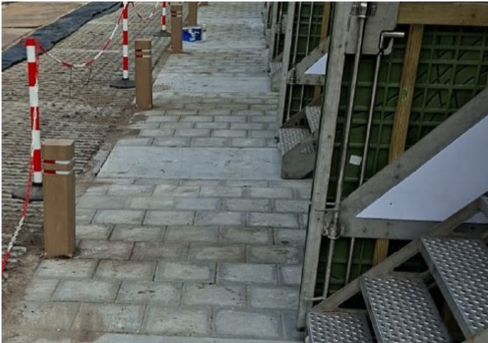
Figuur 3 Indicatieve opstelling Diamantkoppalen
