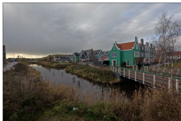
Figuur 10. Brede sloot (>2 meter) zonder natuurlijke oever ten oosten en zuiden van het plangebied.
