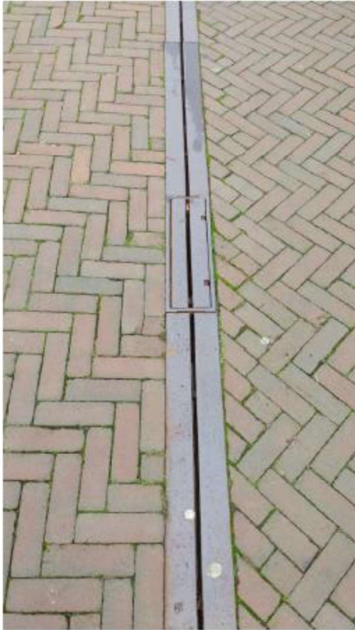
Lijngoot met doorspuitput na reinigen schamieren en deksel- rand invetten.
