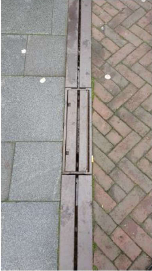
Lijngoot met doorspuitput na reinigen rand invetten
