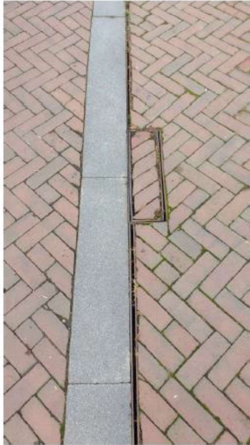
Lijngoot met doorspuitput met bestrating in deksel, na reinigen schamieren en dekselrand invetten.
