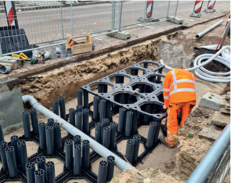
Foto aanleg boombunker Hagedisstraat Groningen
