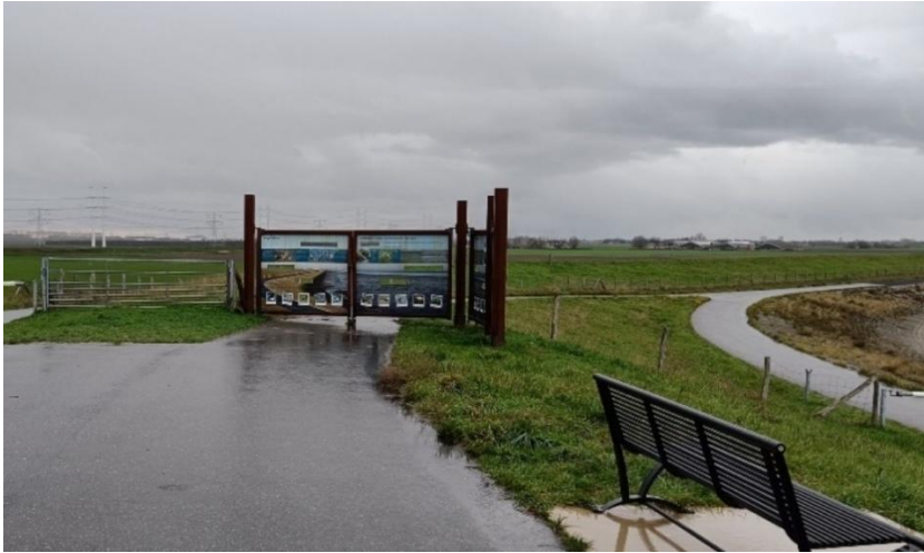
Afbeelding 7 Afgesloten onderhoudsweg met behulp van een informatiebord
