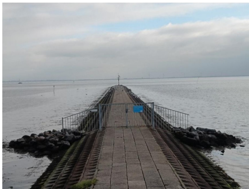
Afbeelding 3 Hoogwatervluchtplaats afgesloten achter een hek
