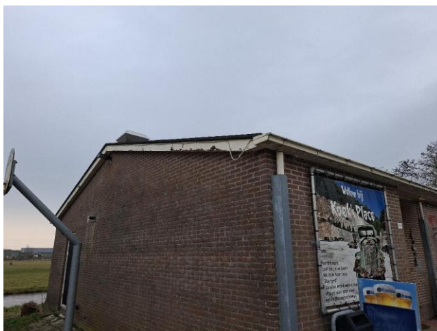
De boeidelen rondom het pand zijn van hout. de regenwaterafvoer en dakgoot zijn uit PVC vervaardigd
