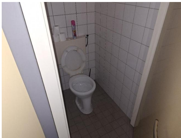
In het toilet bevinden zich vloer en wandtegels welke in specie gezet zijn.
