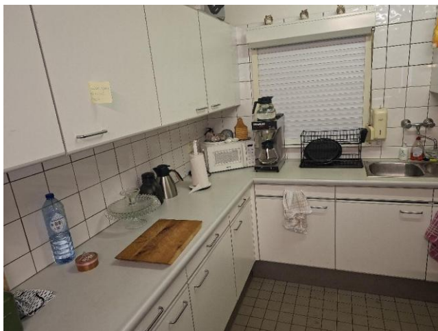
De tegels op de vloer en aan de wand in de keuken zijn in specie gezet
