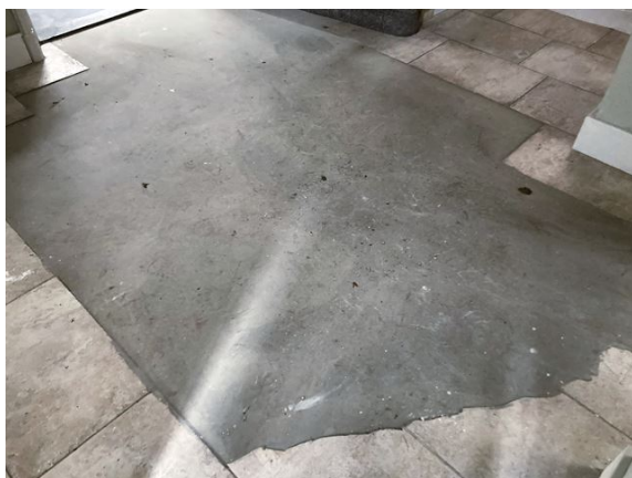
gang: egalisatiemortel aangebracht (2024)
