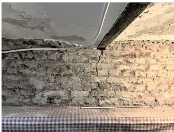
kelder: oproesten stalen balk (2025)
