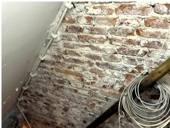
kelder: binnenpleisterwerk verwijderd (2025)
