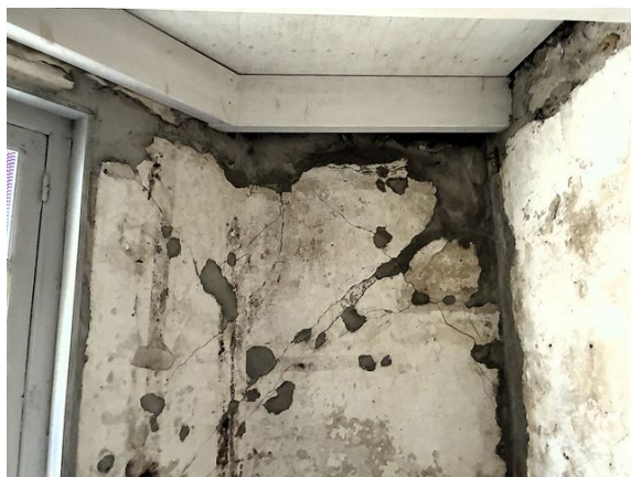
berging: scheurvorming (2025)
