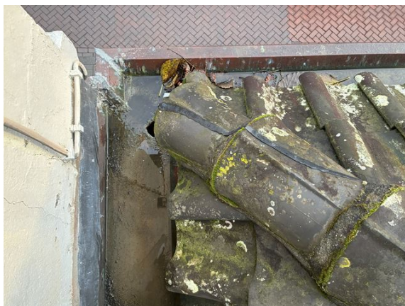
dak no. 3-4: gescheurde hoekkepervorsten tijdelijk met kit afgedicht (2025)
