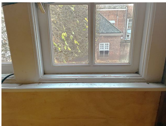
dakkapel no. 5: uitzetijzer ontbreekt (2025)
