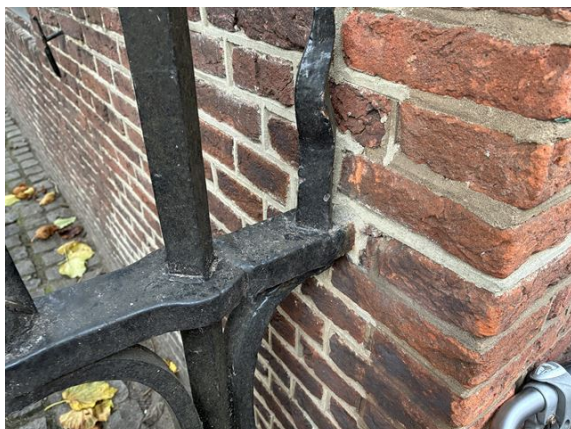
gevel no. 9: roestvorming ingemetselde delen (2025)
